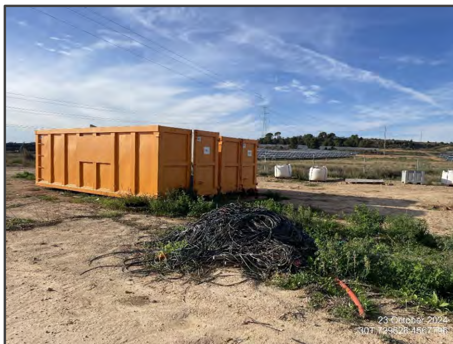
Fotografía 31. Zona de acopio de placas solares deterioradas
