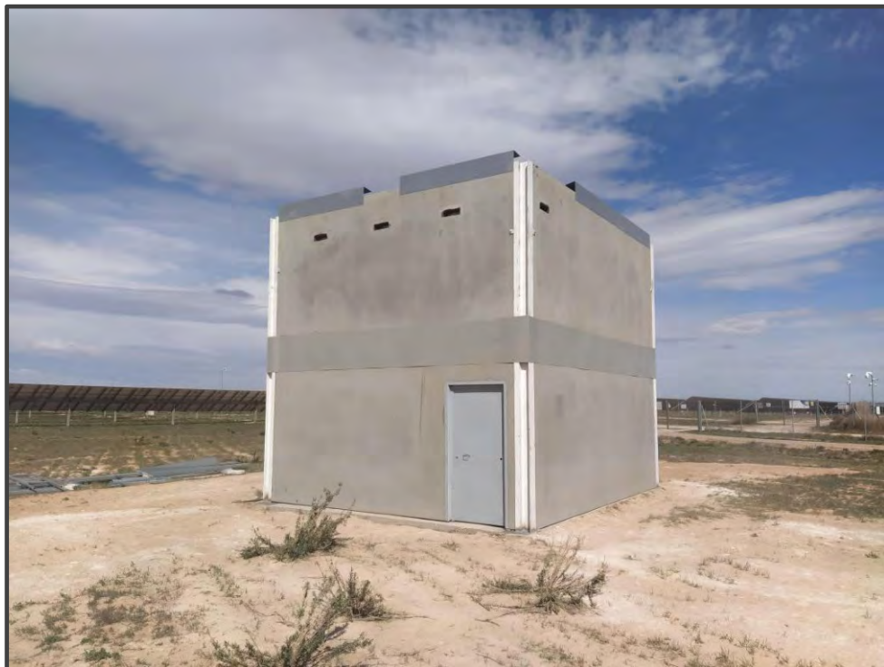
Fotografía 7. Exterior del primillar de nueva construcción.
