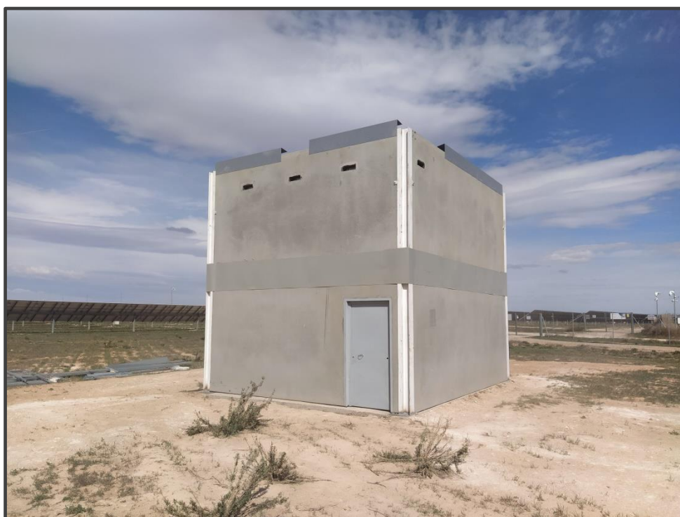
Fotografía 4. Exterior del primillar de nueva construcción.
