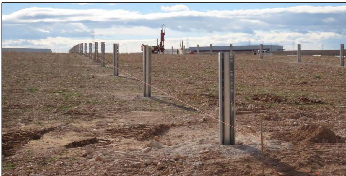
Ilustración 12. Hincas colocadas.
