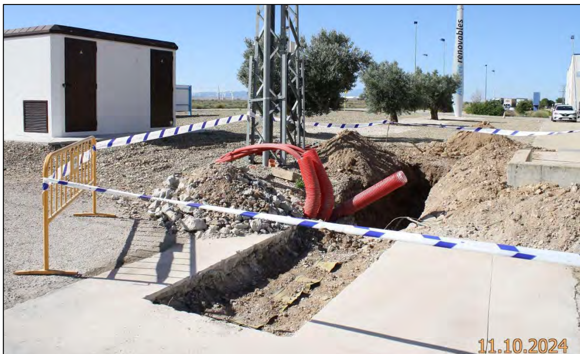
Ilustración 34. Ejecución de una de las LSMT.
