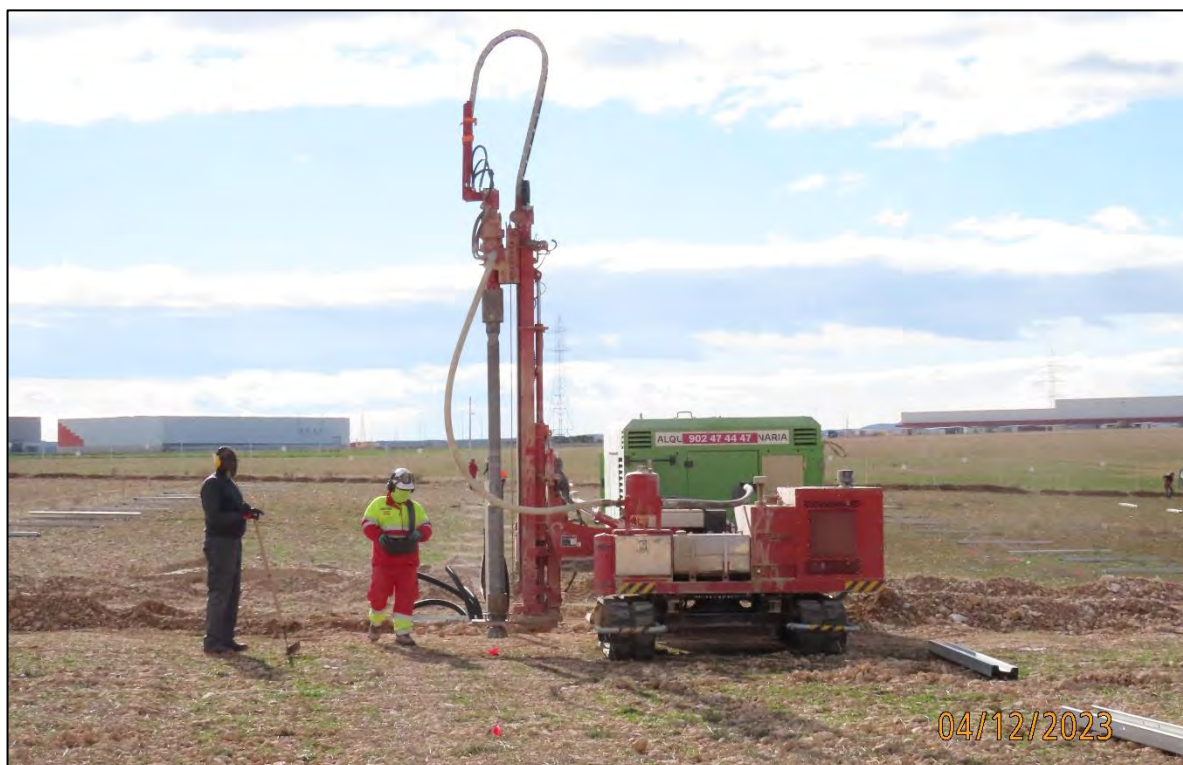
Ilustración 11. Hincadora perforando el suelo.
