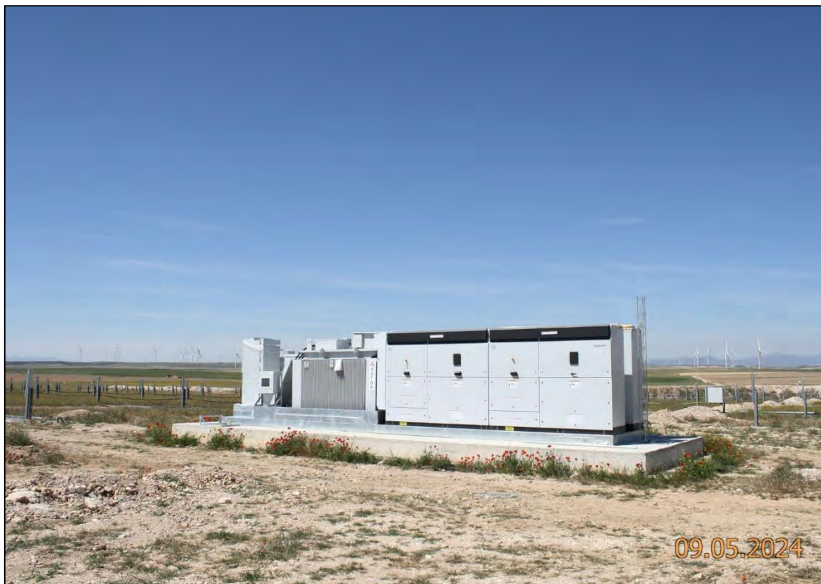
Ilustración 24. Instalación de la última Power Station.
