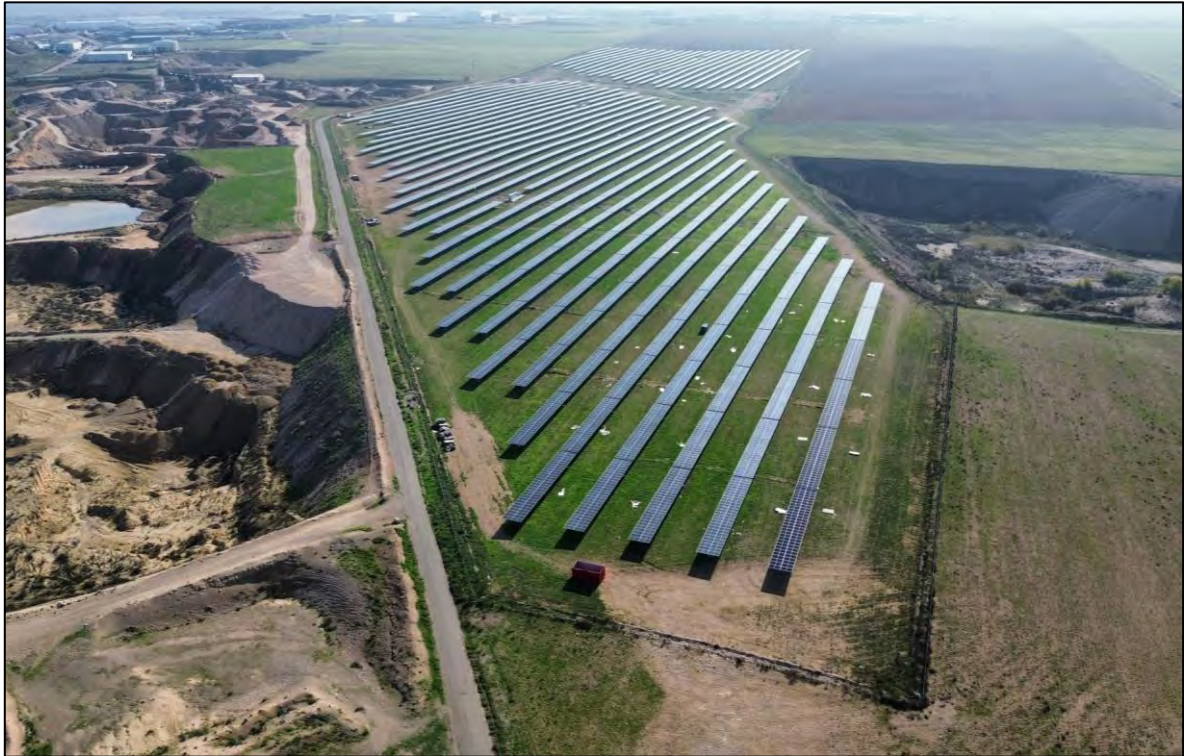
Ilustración 35. Estado del parque.
