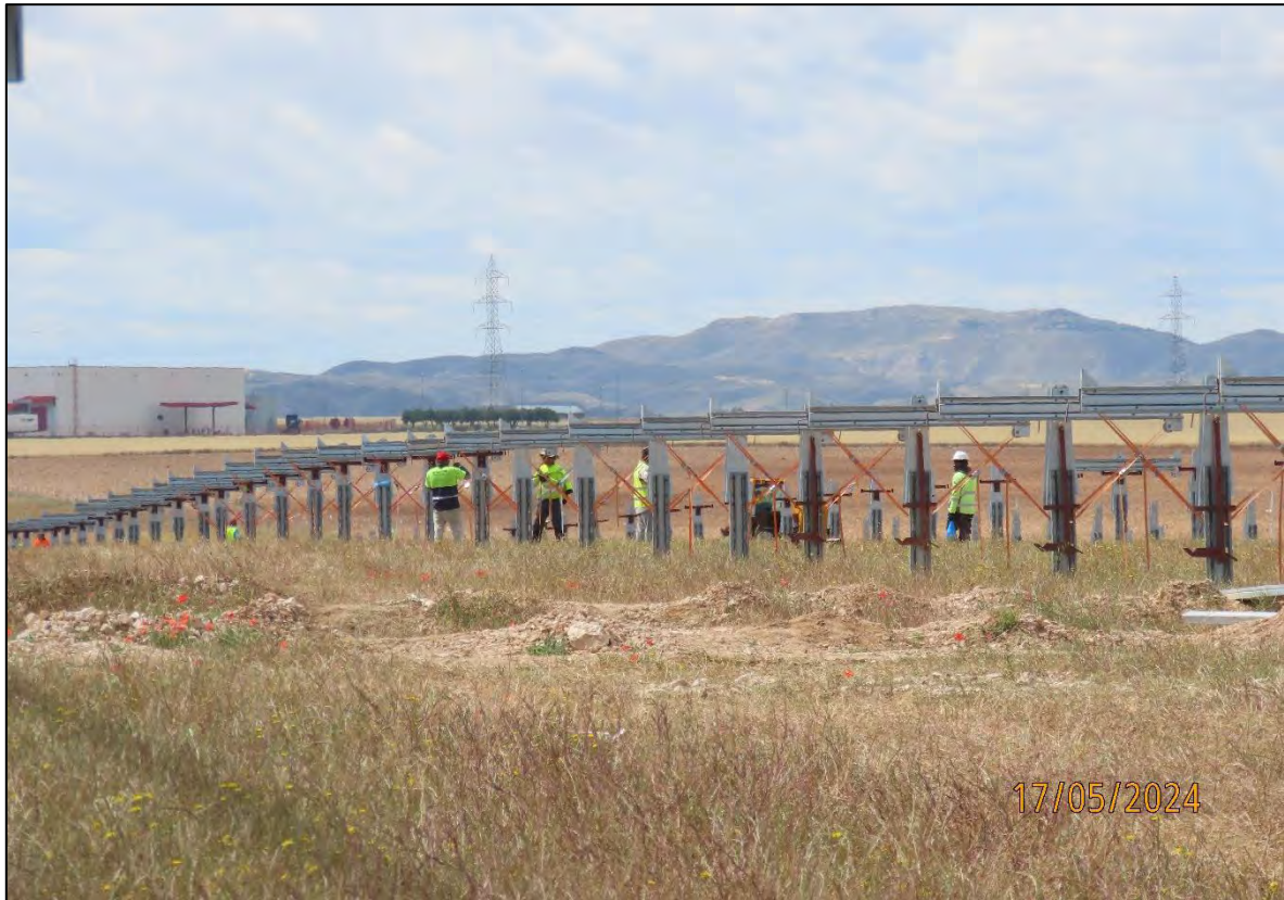
Ilustración 25. Trabajos de montaje de las estructuras de los seguidores.
