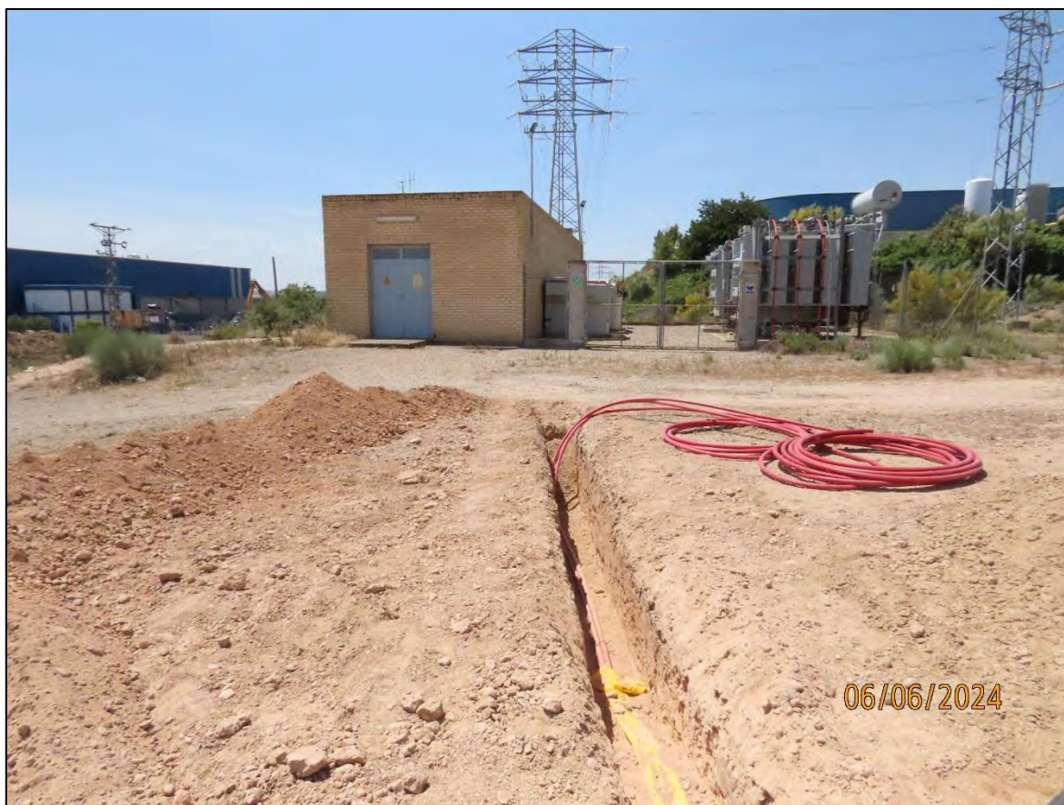
Ilustración 29. Trabajos en las zanjas de las líneas de evacuación.
