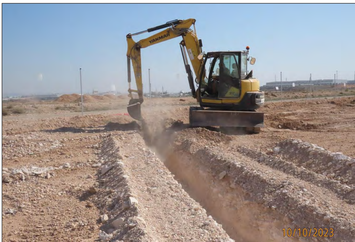
Ilustración 8. Tapado de zanjas.
