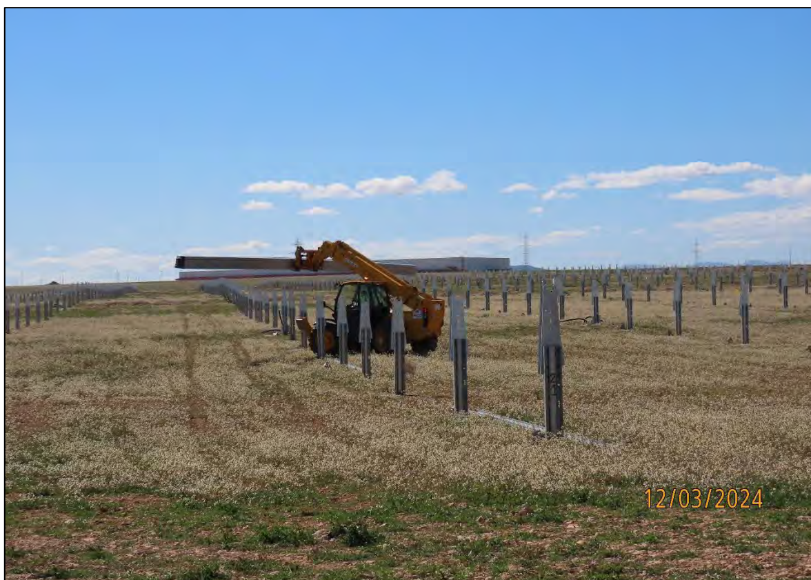
Ilustración 19. Preparación de las estructuras de los seguidores.
