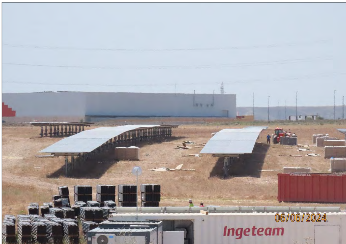
Ilustración 27. Inicio de la instalación de paneles solares.
