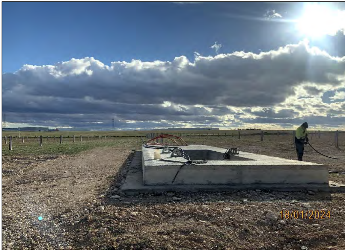
Ilustración 14. Instalación de cableado.
