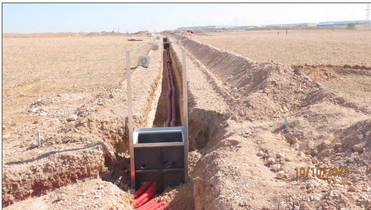
Ilustración 7. Colocación de tuberías de cableado y cajas de strings.
