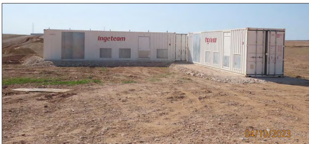
Ilustración 6. Casetas de obra.
