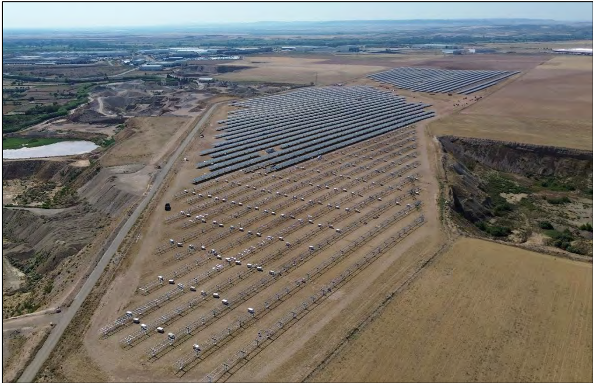
Ilustración 31. Estado del parque.
