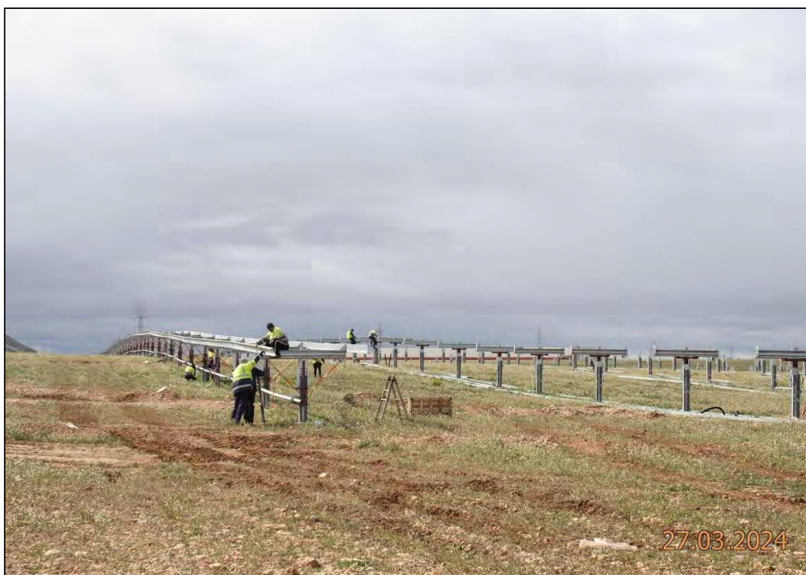
Ilustración 20. Montaje de las estructuras de los seguidores.
