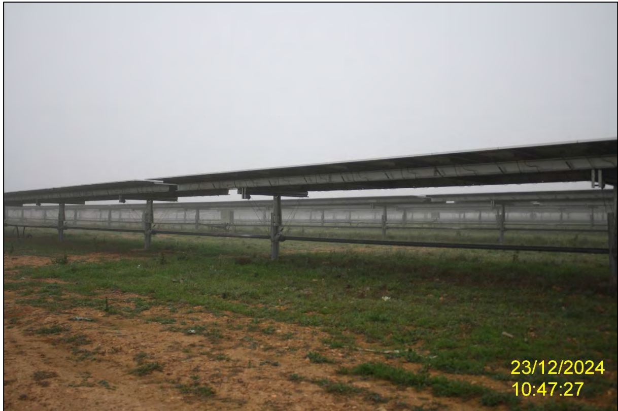
Ilustración 36. Últimos ajustes de la instalación de paneles solares.
