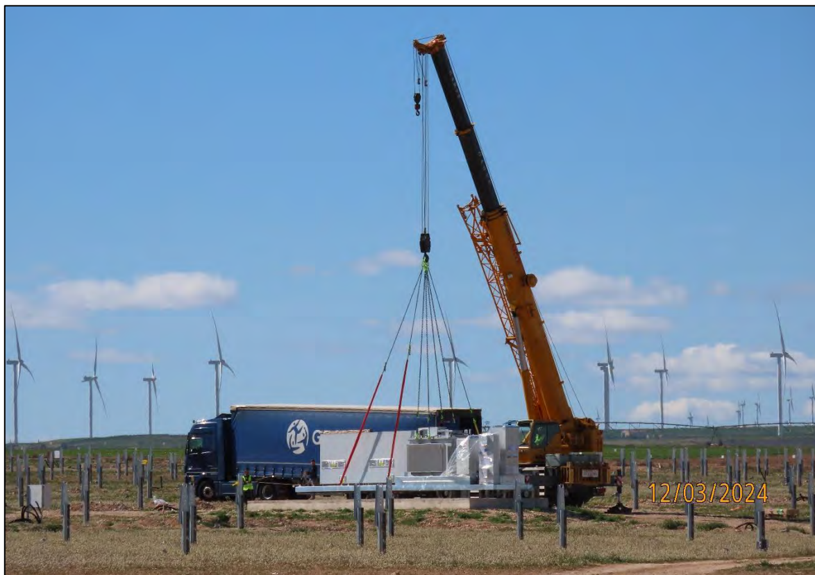
Ilustración 18. Instalación de la Power Station.
