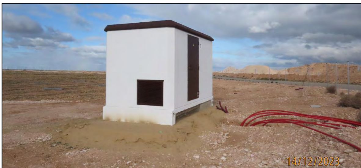
Ilustración 13. Instalación del Centro de Transformación.
