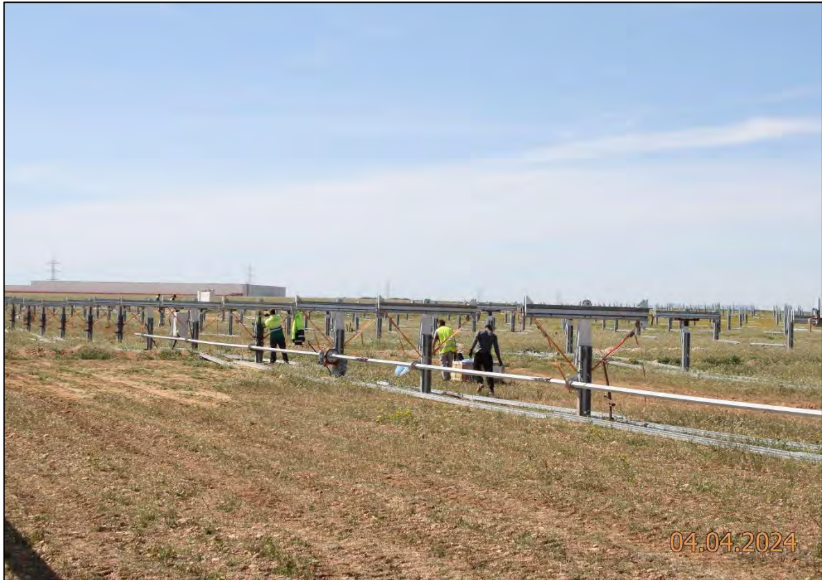
Ilustración 21. Montaje de las estructuras de los seguidores.
