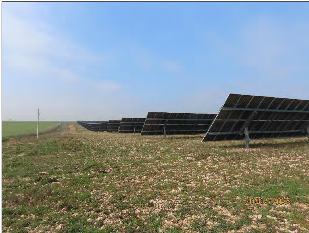
Ilustración 38. Estado actual del parque.
