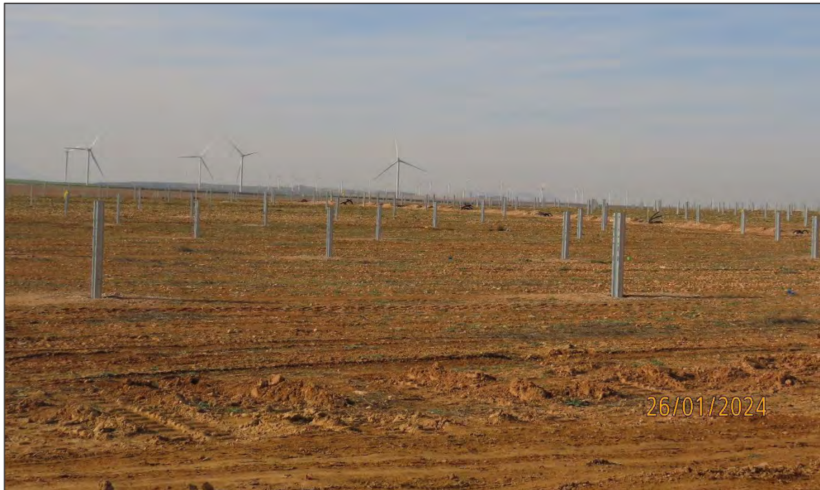
Ilustración 16. Finalización de los trabajos de hincado.
