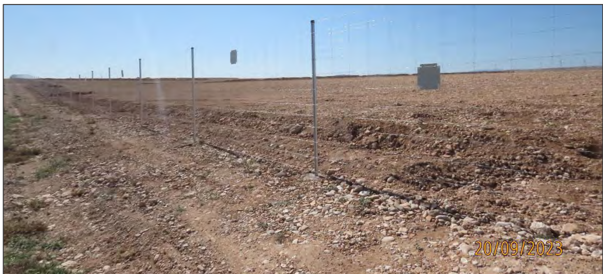
Ilustración 3. Instalación del vallado perimetral y de los elementos que lo visibilizan a la avifauna.
