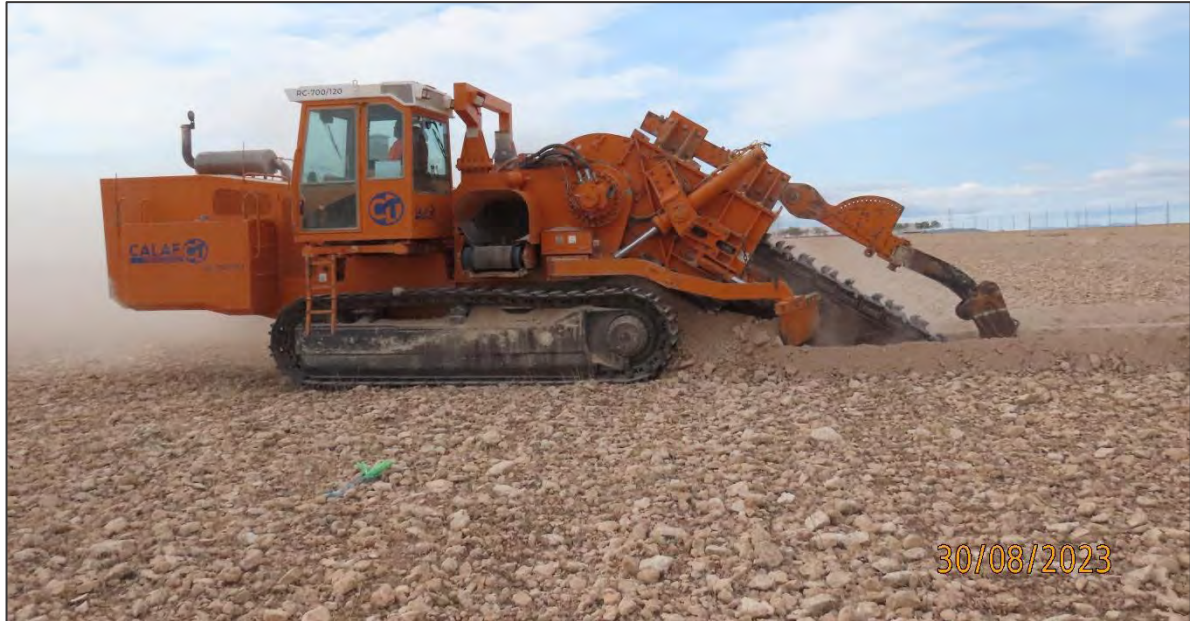
Ilustración 2. Apertura de zanjas con zanjadora.
