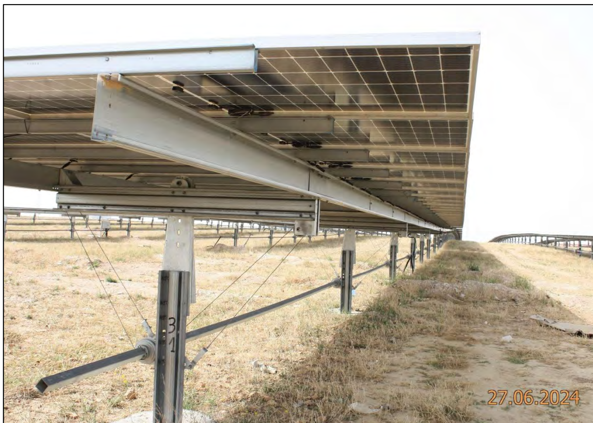
Ilustración 28. Instalación de paneles solares.
