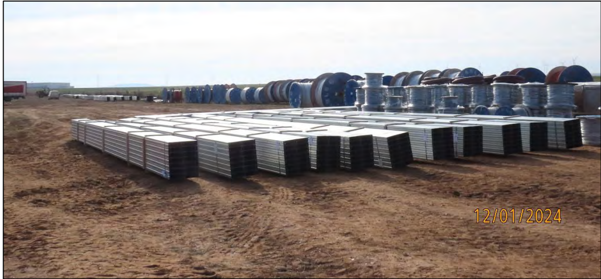
Ilustración 15. Acopio de materiales de obra.
