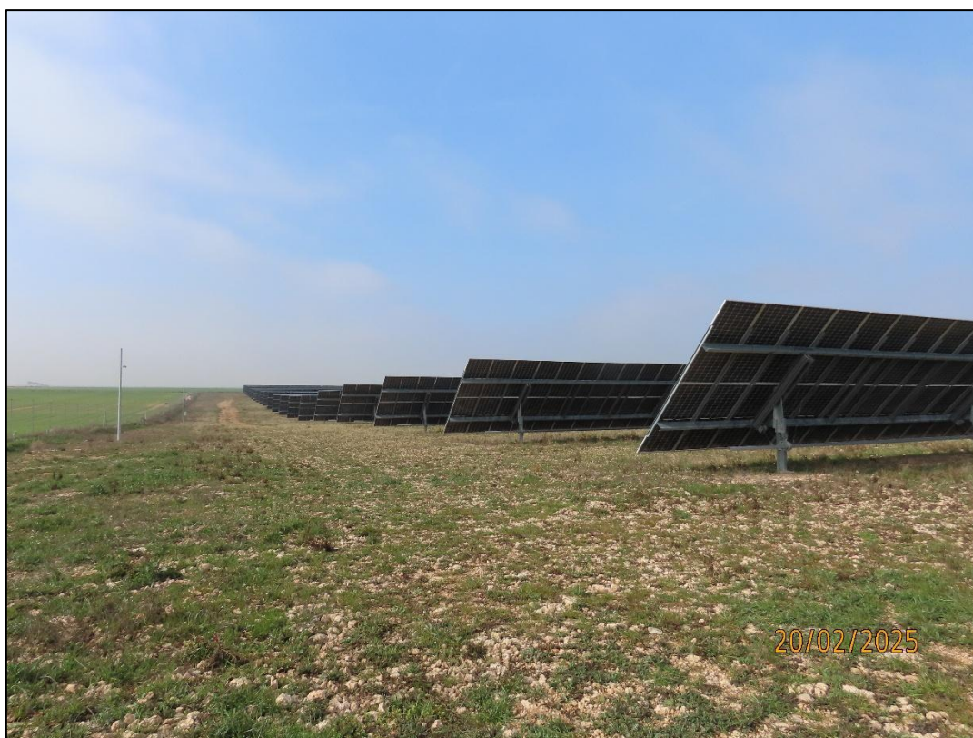
Ilustración 3. Estado actual del parque.
