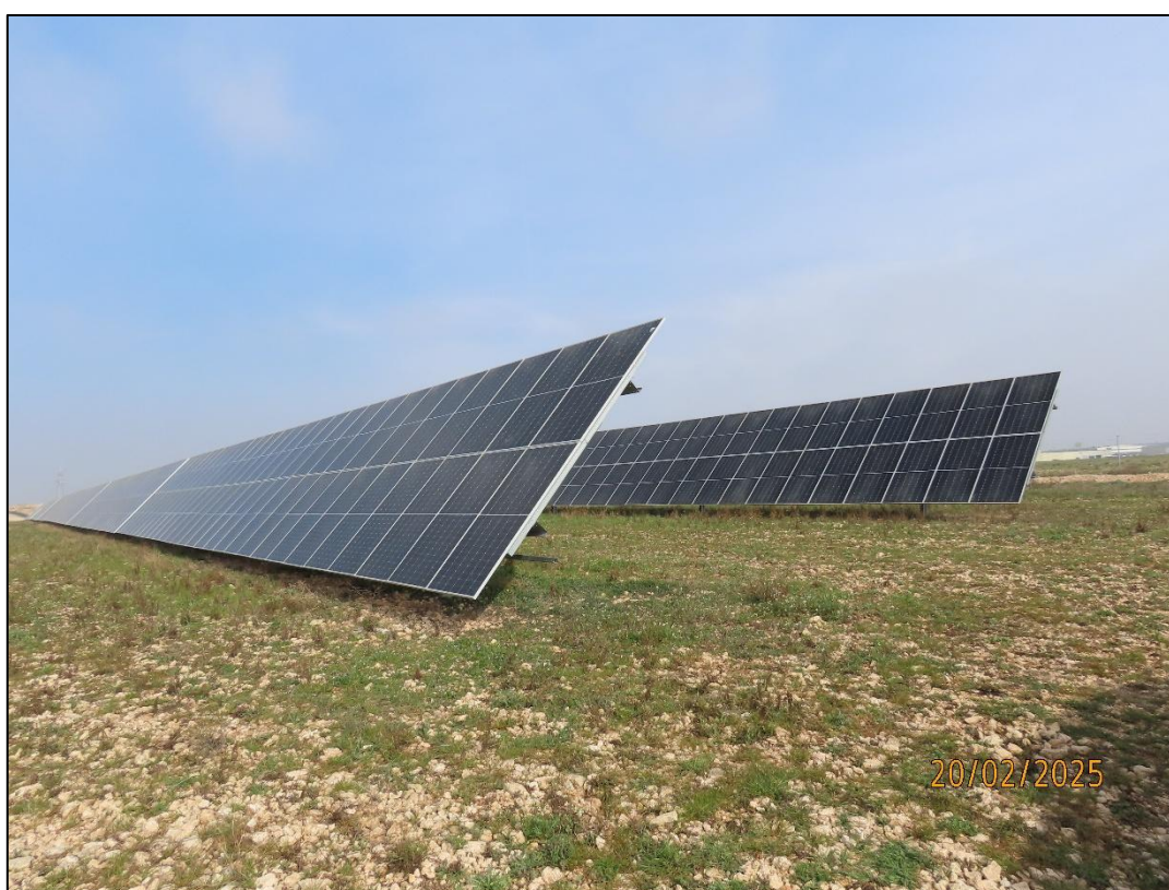
Ilustración 4. Estado actual del parque.
