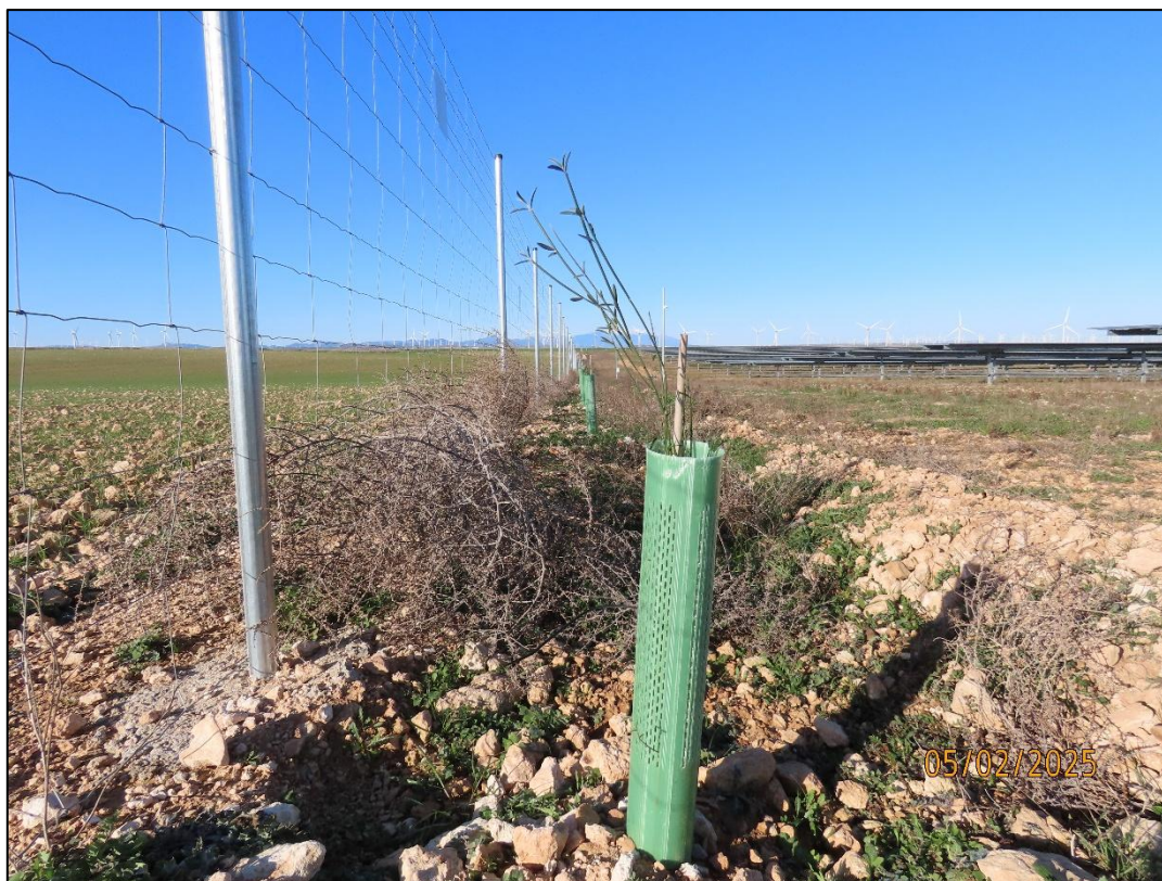
Ilustración 5. Estado actual de la pantalla vegetal.
