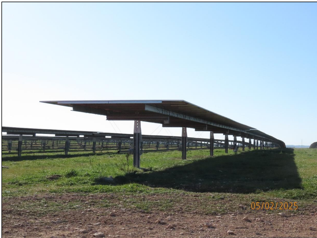
Ilustración 2. Estado actual del parque.
