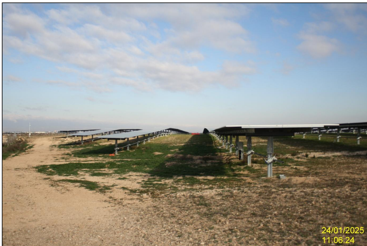
Ilustración 3. Últimos ajustes de la instalación de paneles solares.
