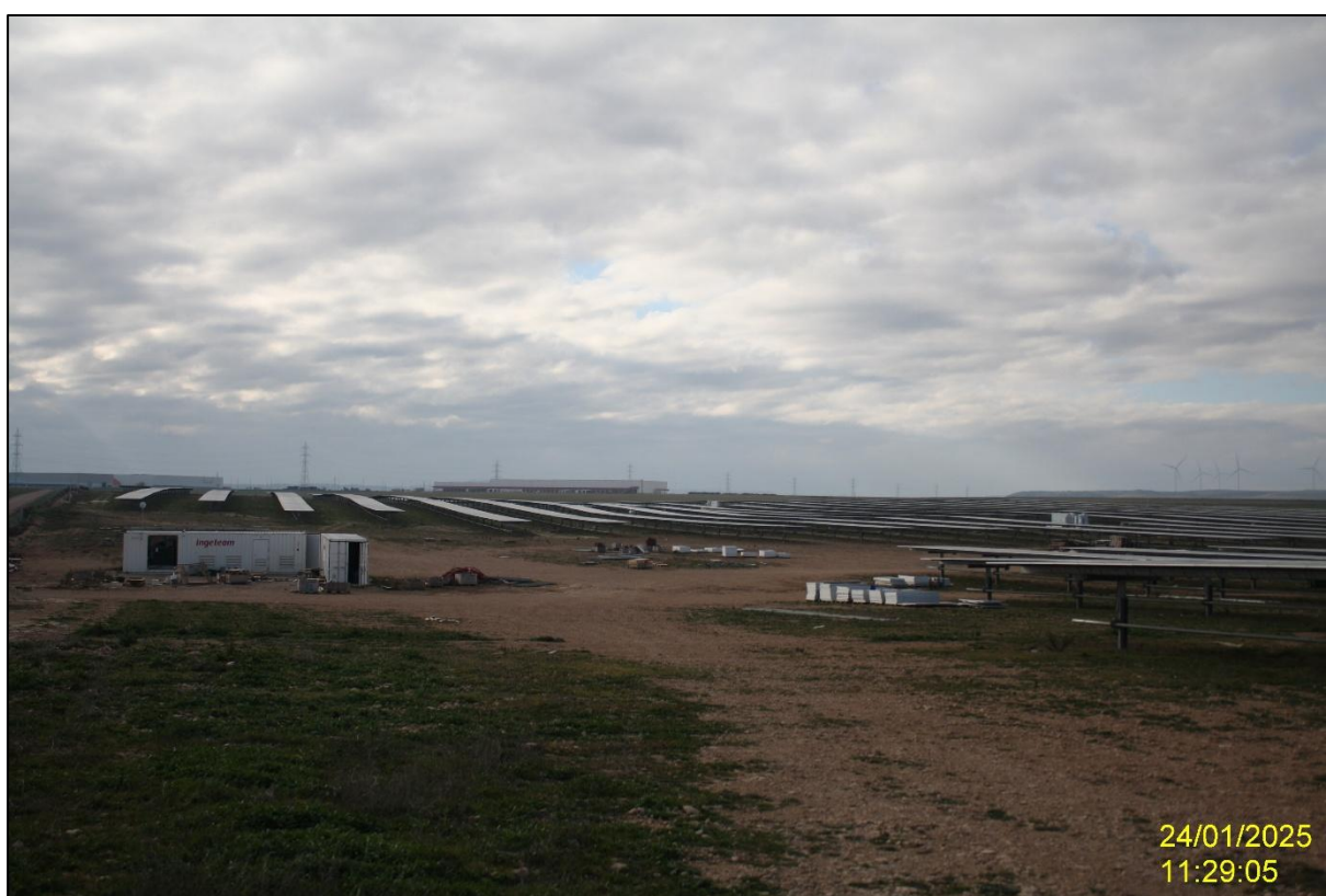
Ilustración 6. Estado actual del parque.
