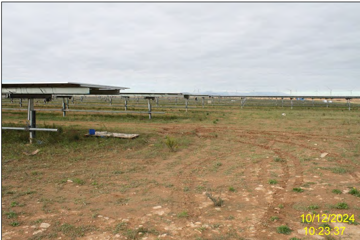
Ilustración 2. Últimos ajustes de la instalación de paneles solares.
