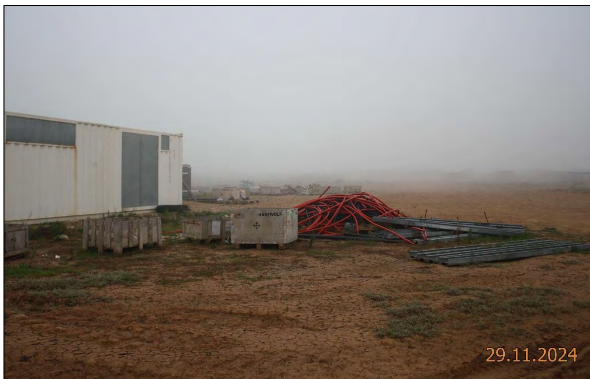
Ilustración 5. Zona de acopio con residuos de distintos materiales.
