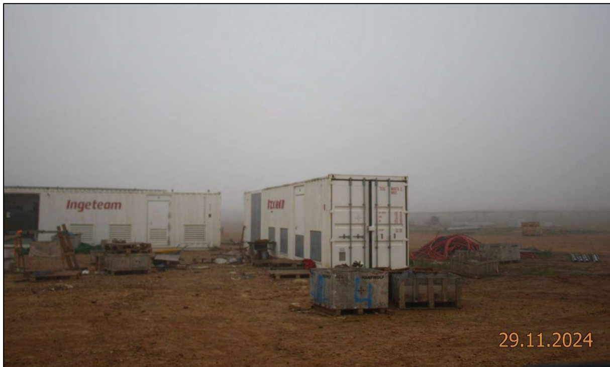
Ilustración 9. Acumulación de residuos en zona de acopio.
