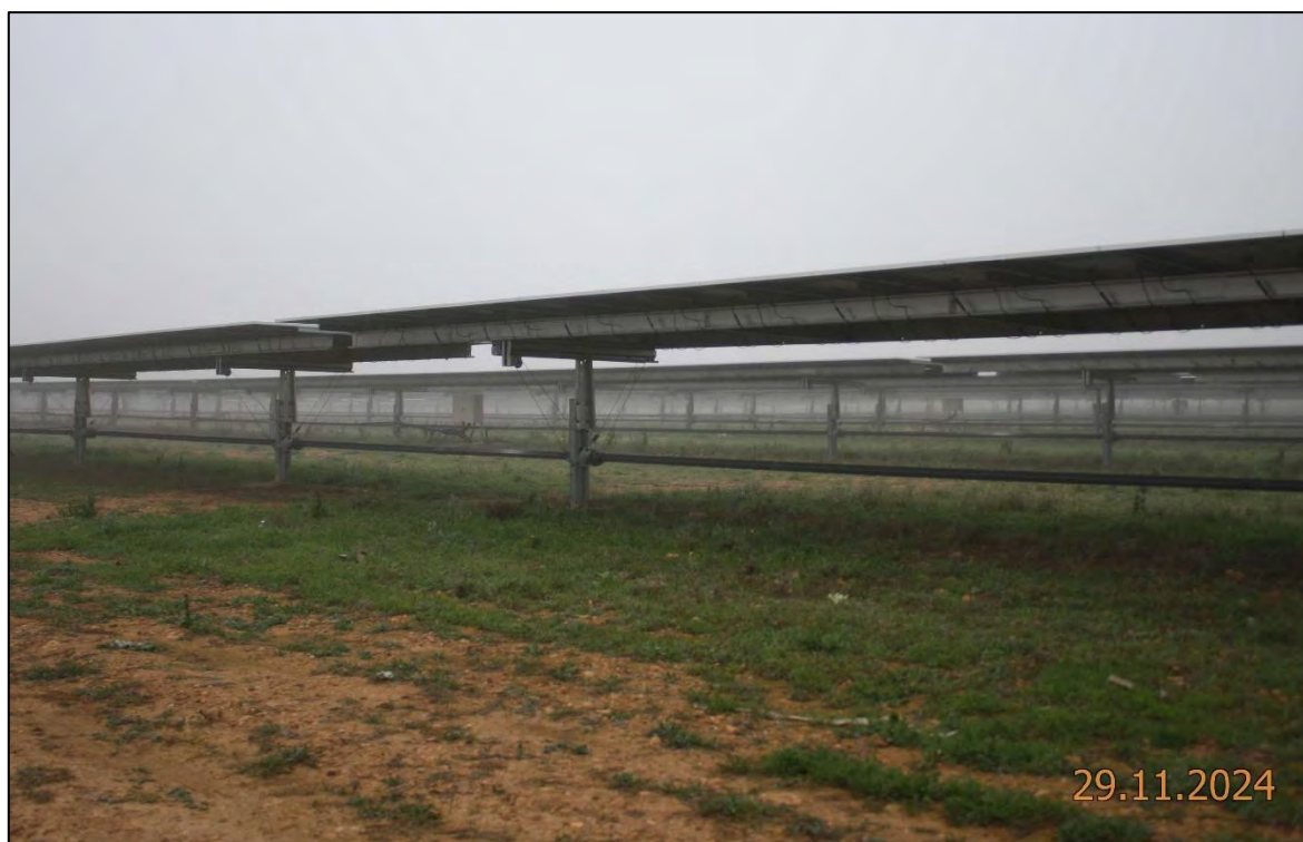
Ilustración 3. Últimos ajustes de la instalación de paneles solares.
