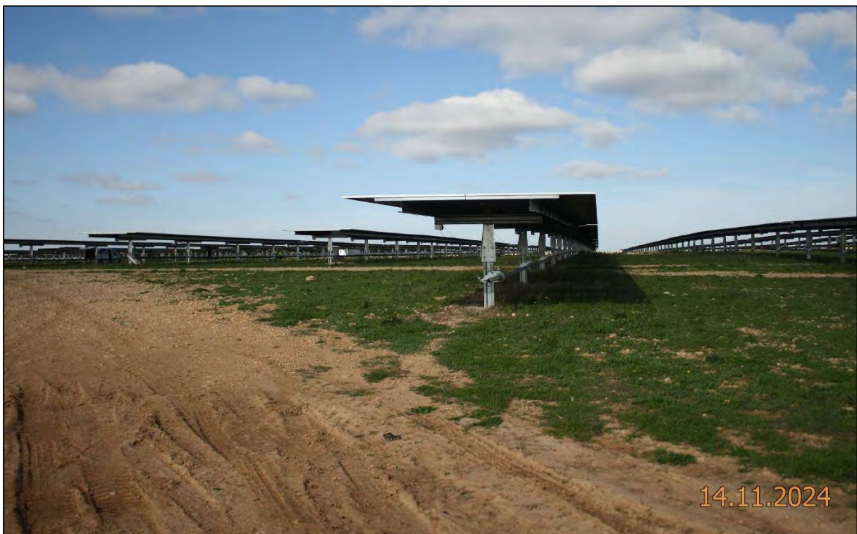
Ilustración 2. Últimos ajustes de la instalación de paneles solares.
