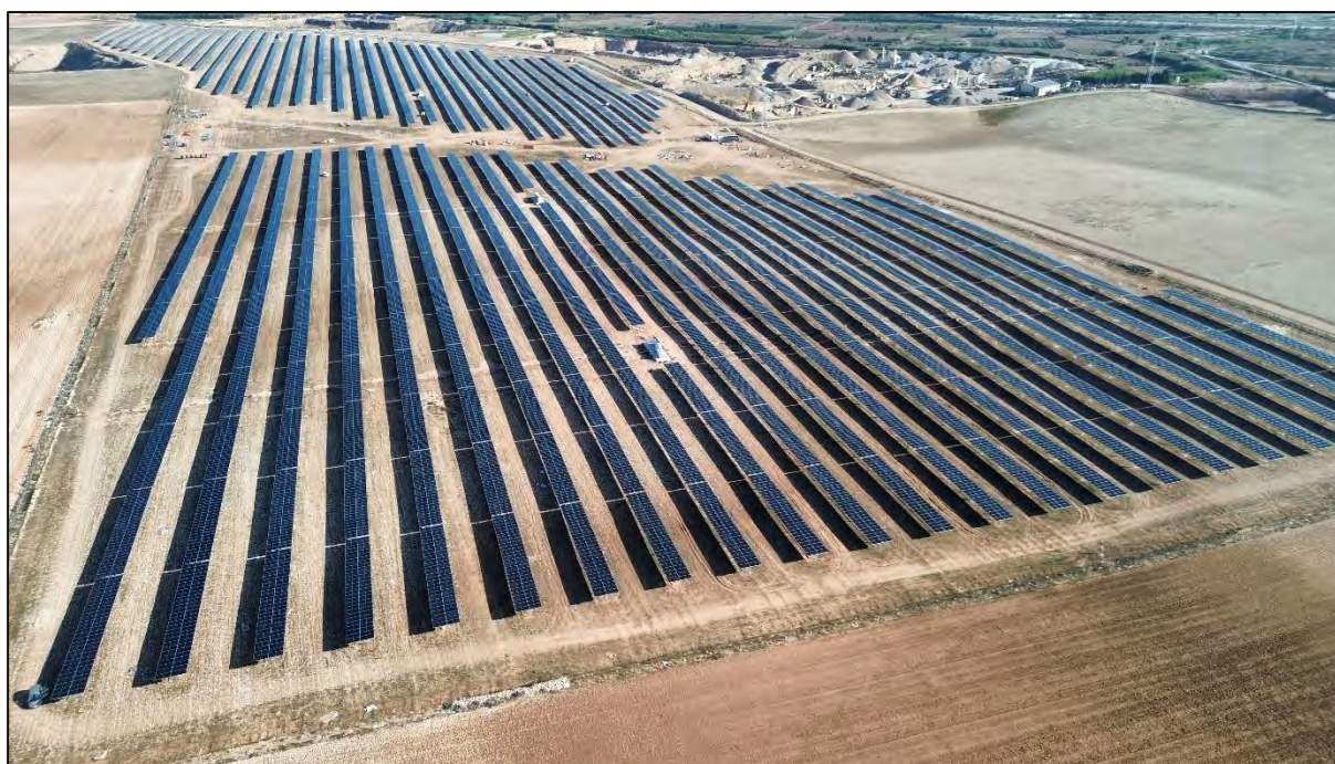
Ilustración 8. Estado actual del parque.
