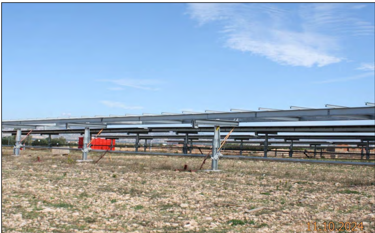
Ilustración 2. Instalación de paneles solares.
