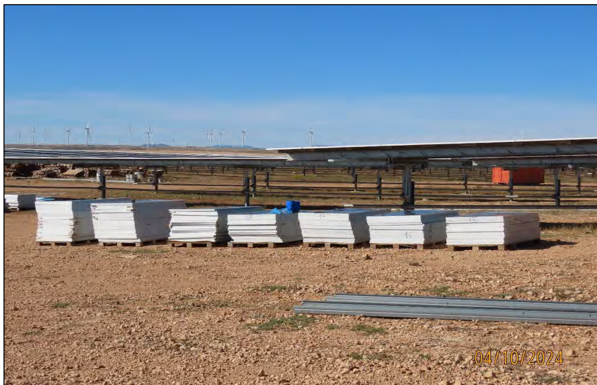
Ilustración 3. Instalación de paneles solares.
