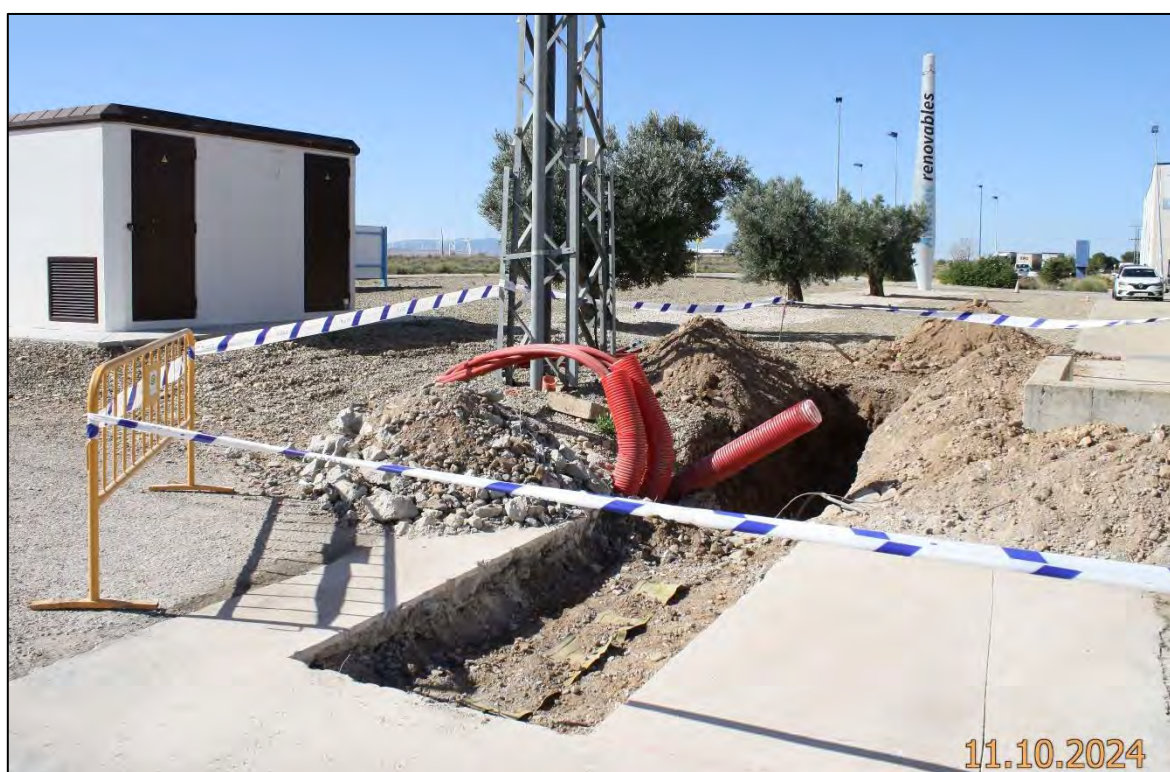
Ilustración 6. Ejecución de una de las LSMT..
