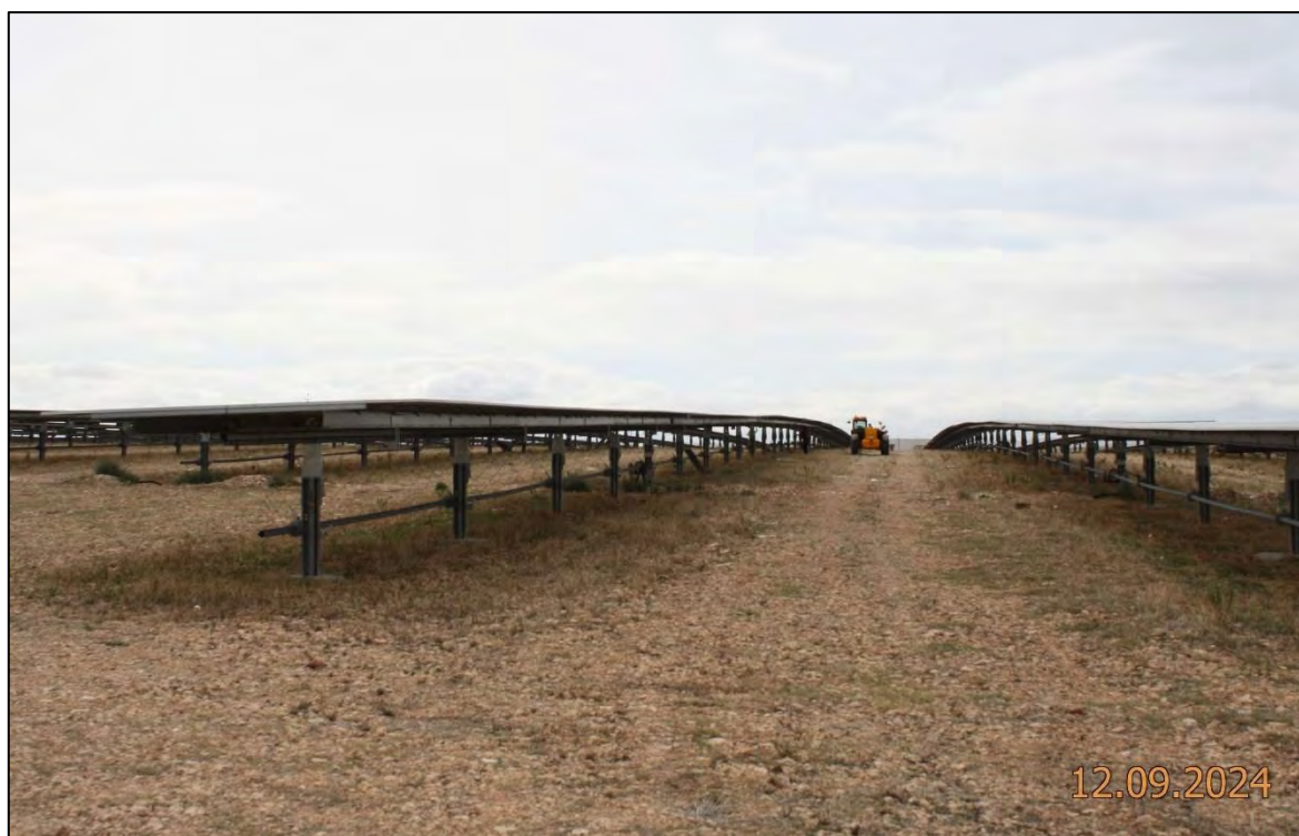
Ilustración 3. Instalación de paneles solares.
