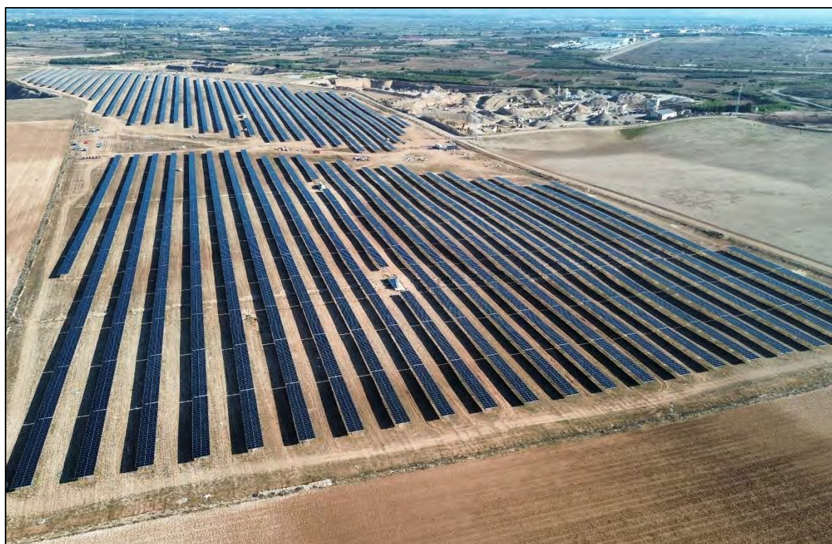
Ilustración 8. Estado actual del parque.
