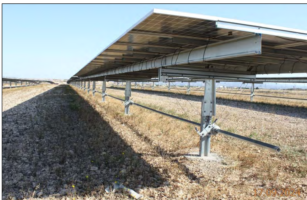
Ilustración 4. Instalación de paneles solares.
