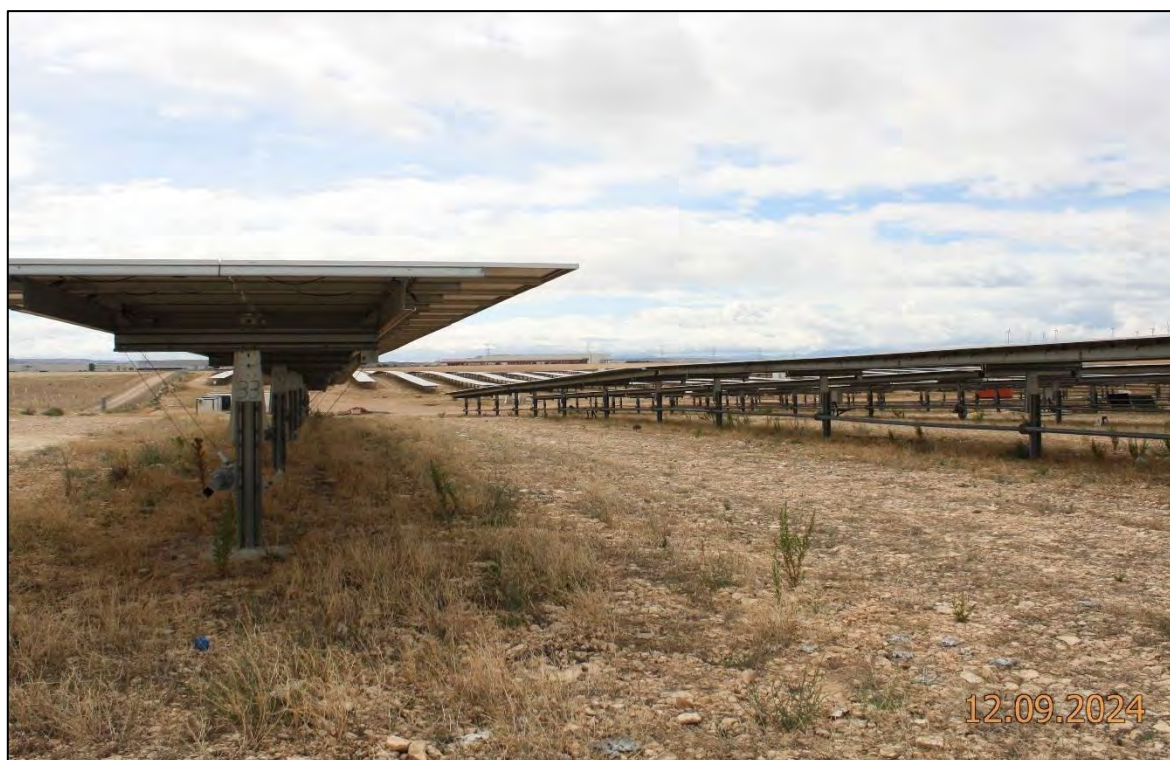
Ilustración 7. Estado actual del parque.
