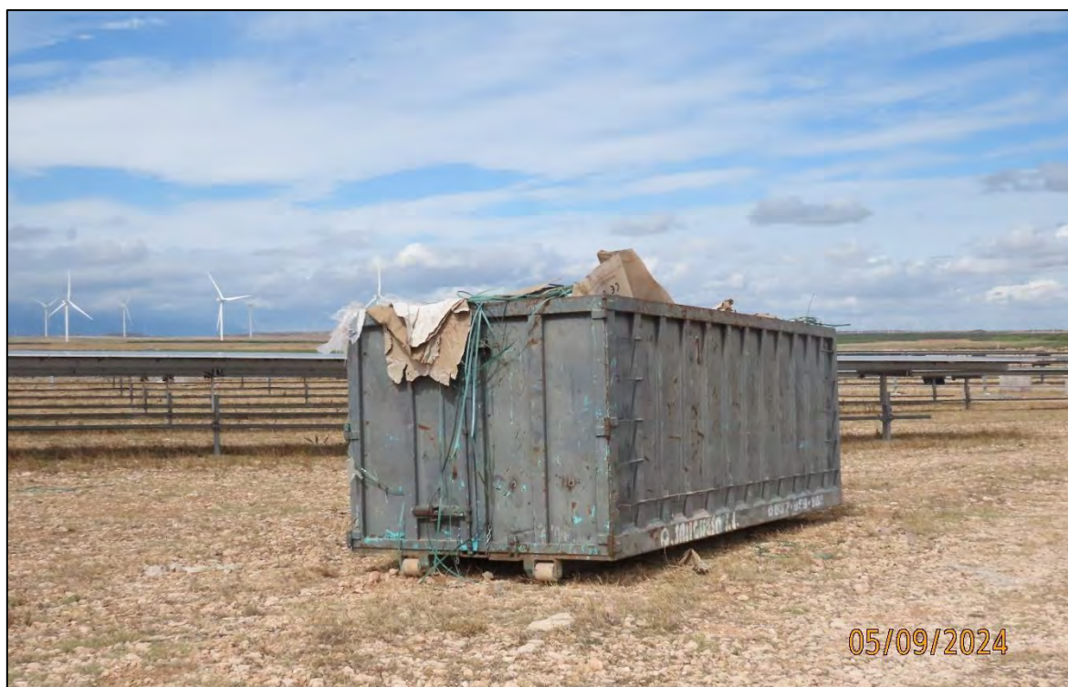
Ilustración 5. Control de residuos del montaje.
