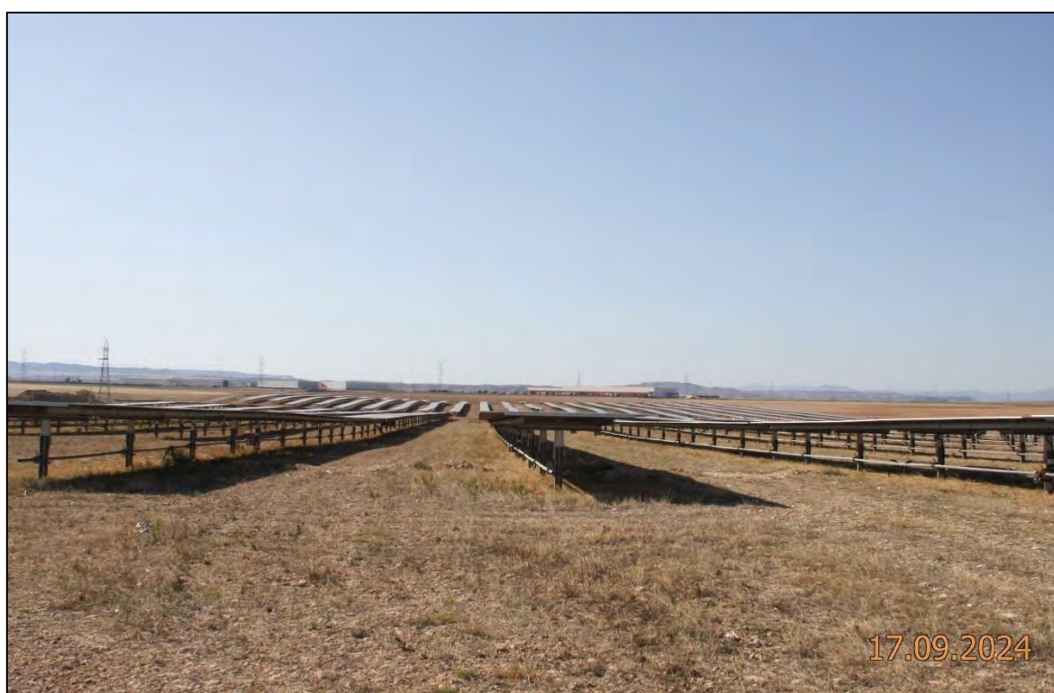
Ilustración 6. Estado actual del parque.
