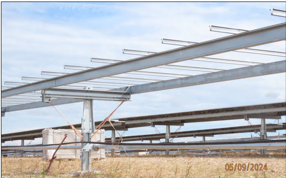
Ilustración 2. Instalación de paneles solares.
