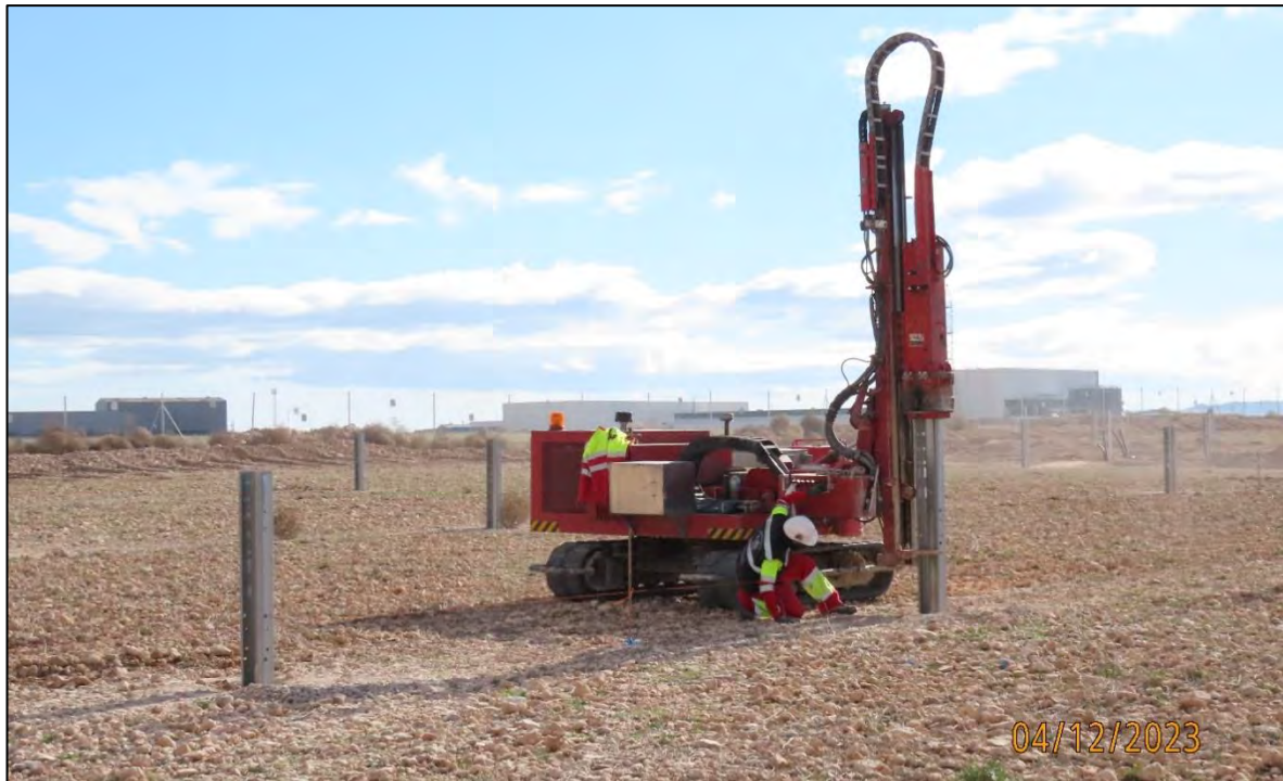
Ilustración 3. Hincadora instalando las hincas.
