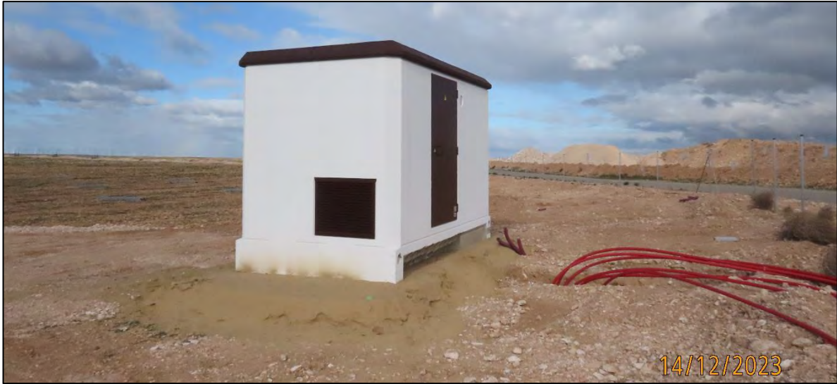
Ilustración 5. Instalación del Centro de Transformación.
