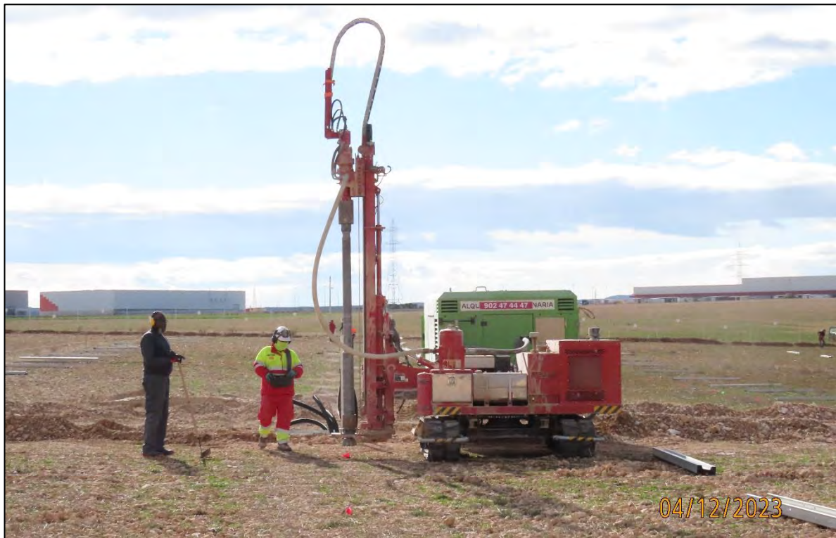
Ilustración 2. Hincadora perforando el suelo.
