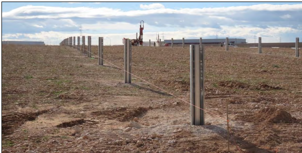
Ilustración 4. Hincas colocadas.
