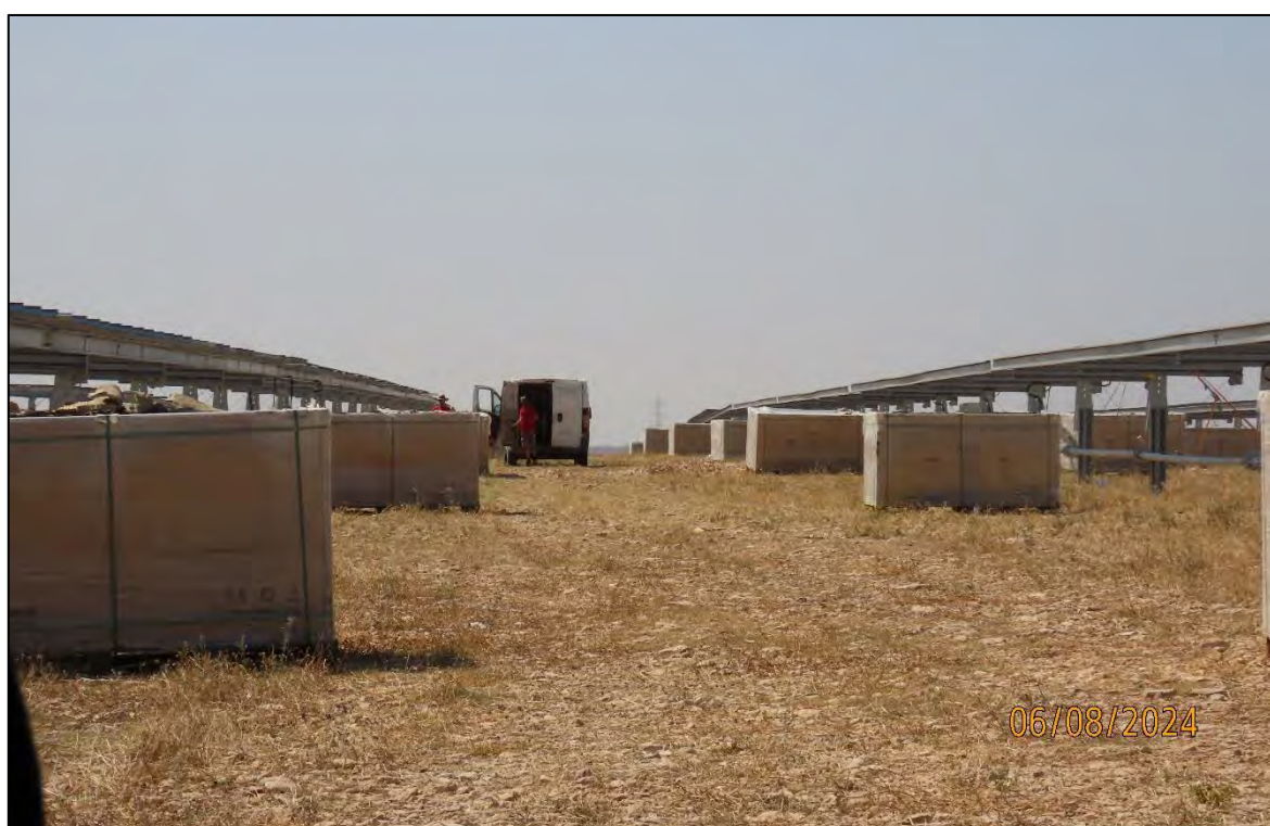
Ilustración 3. Instalación de paneles solares.
