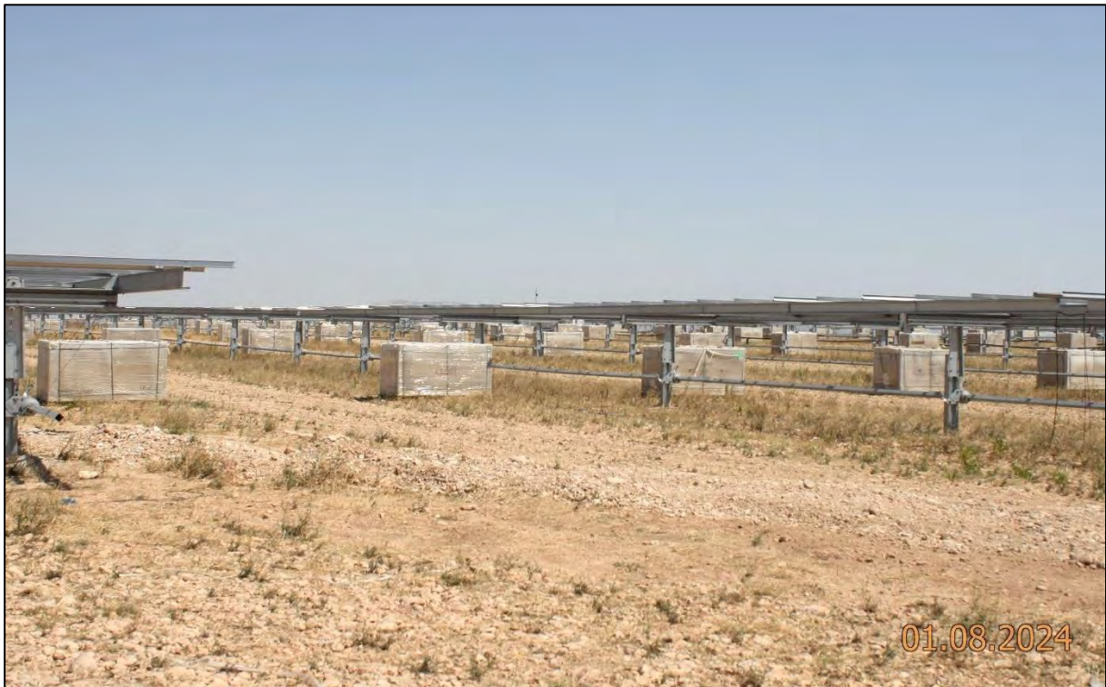
Ilustración 1. Instalación de paneles solares.
