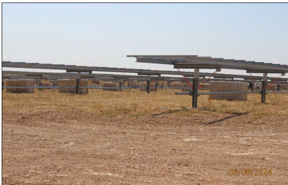
Ilustración 4. Instalación de paneles solares.
