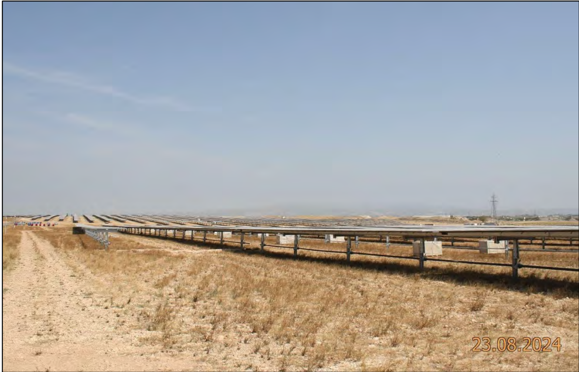
Ilustración 8. Estado actual del parque.
