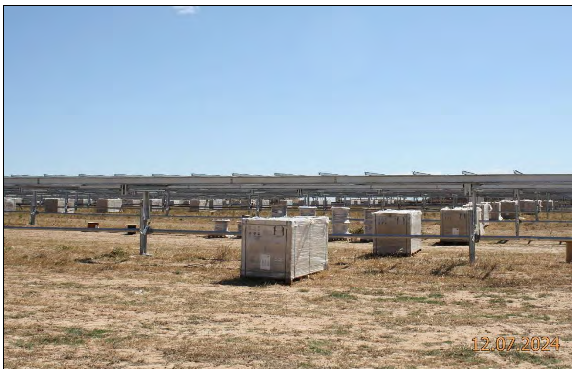
Ilustración 2. Instalación de paneles solares.
