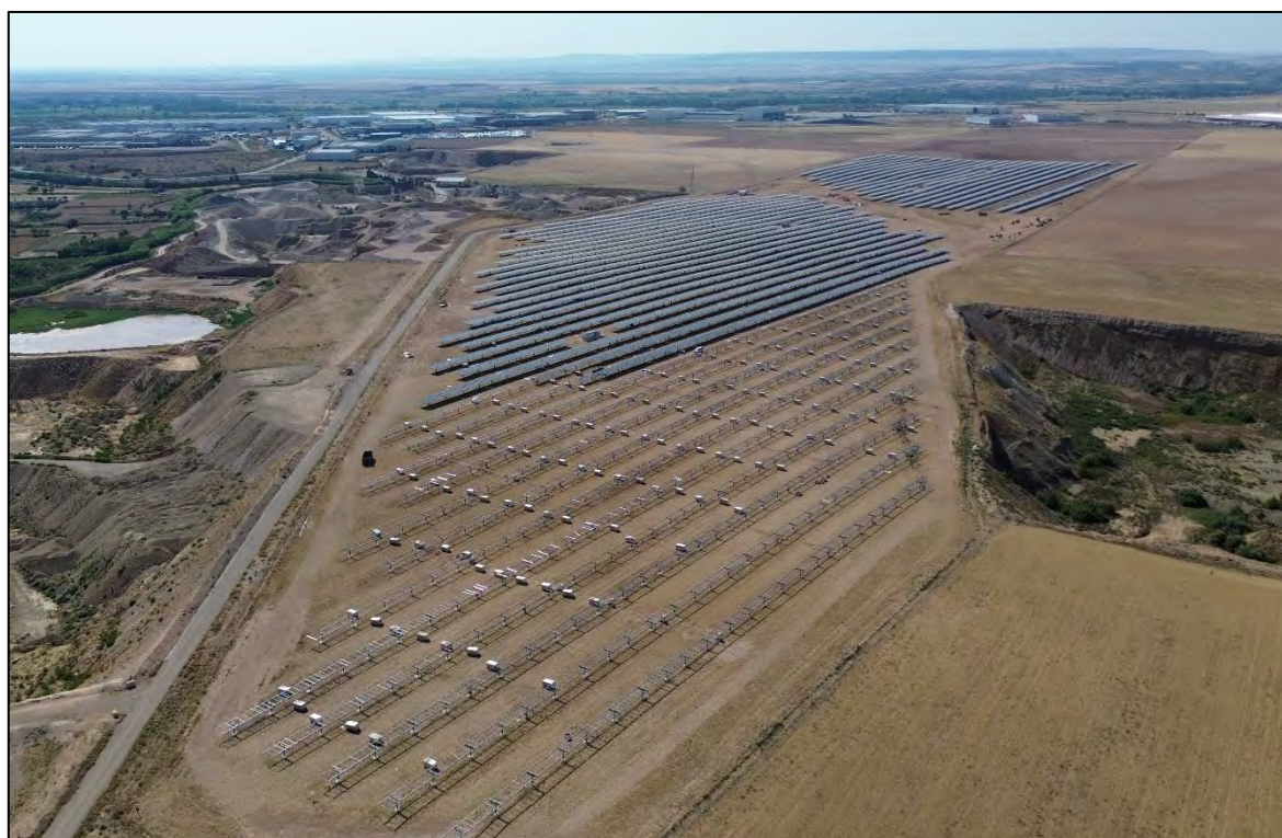
Ilustración 7. Estado actual del parque.
