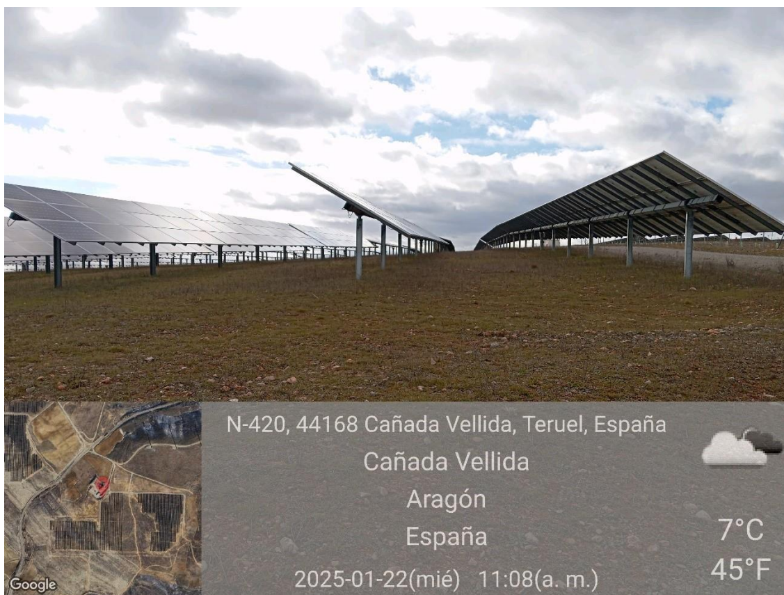
Ilustración 8. Vegetación entre placas en buen estado en la poligonal 2.
