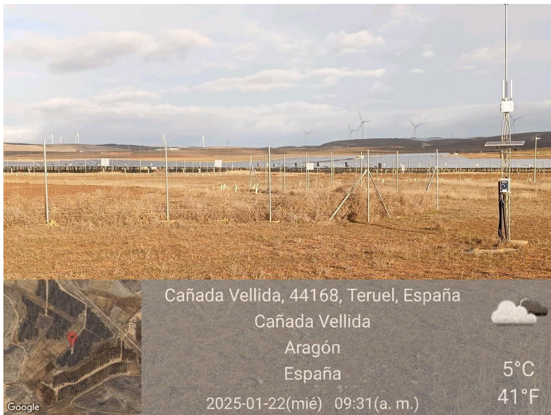
Ilustración 7. Maleza acumulada en el vallado de la poligonal 3.
