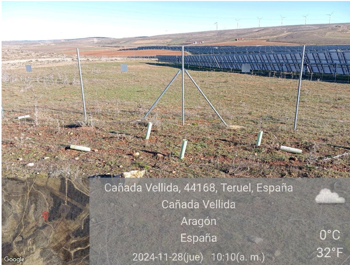
Ilustración 3. Pantalla vegetal en mal estado al sur de la poligonal 3.
