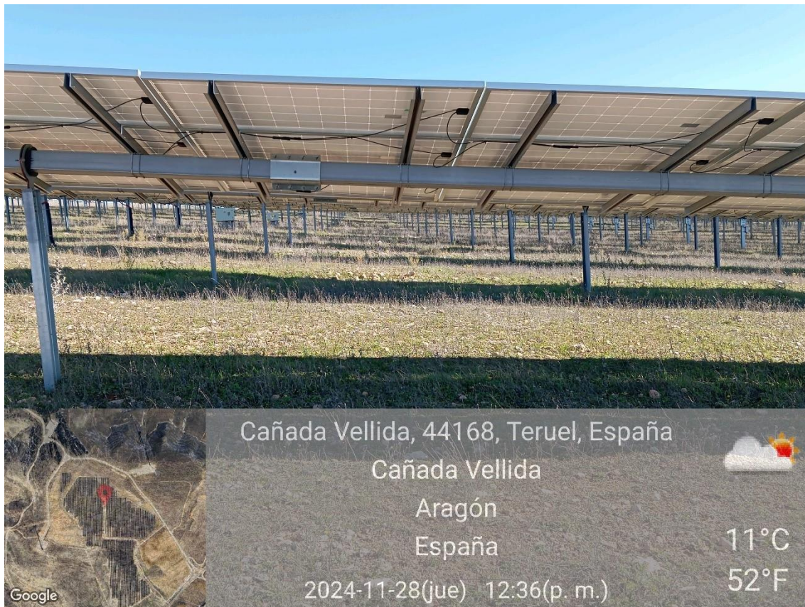
Ilustración 1. Cobertura vegetal adecuada entre placas en la zona 1.
