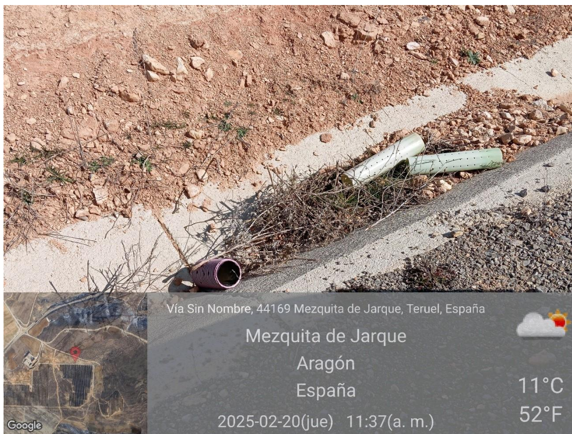
Ilustración 10. Tubos protectores en las canaletas de la poligonal 3.
