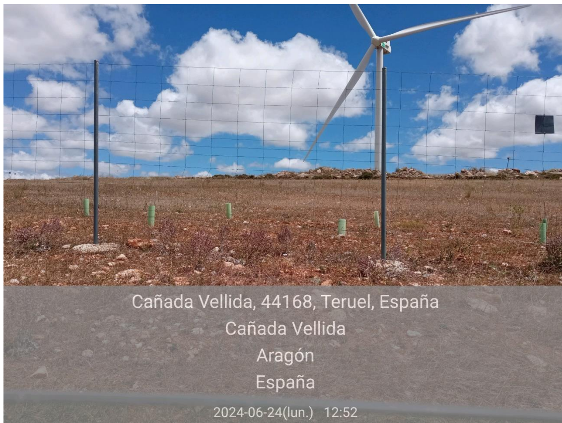
Ilustración 7. Tramo del vallado el campo 1 sin placas anticolidión.
