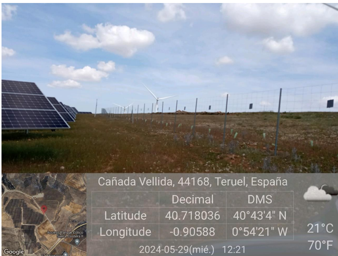
Ilustración 5. Estado del vallado y de la vegetación en el campo 1.
