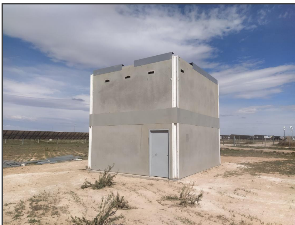
Fotografía 7. Exterior del primillar de nueva construcción.
