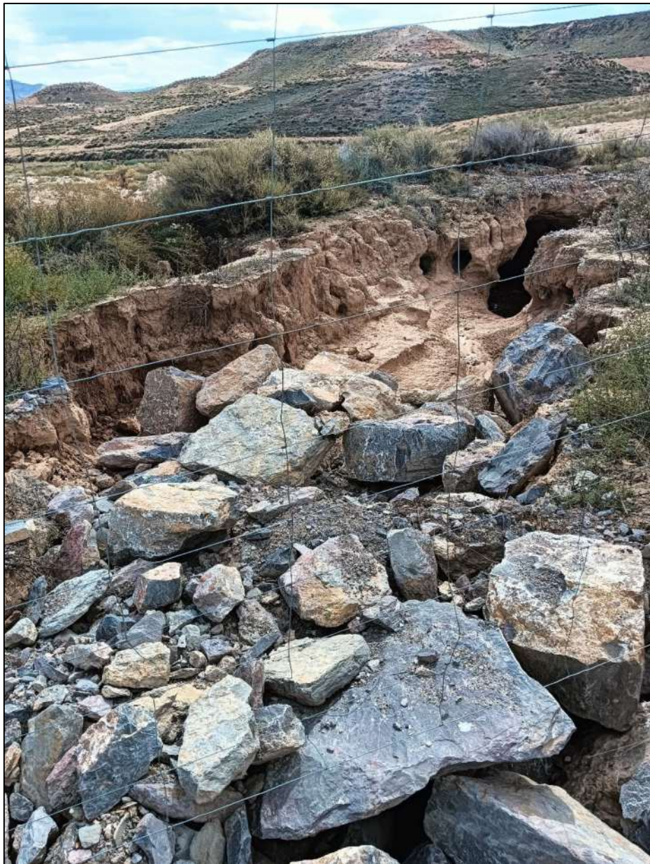
Fotografía 20. Ejecución de drenaje en terreno erosionado
