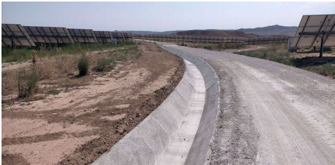
Fotografía 6. Red de drenaje hormigonada justo antes de CT-5
