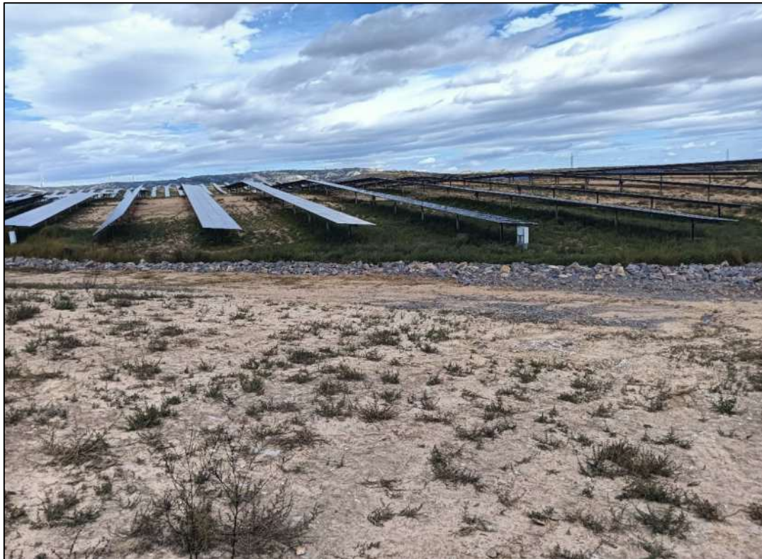
Fotografía 18. Corrección de la erosión mediante zanja drenante
