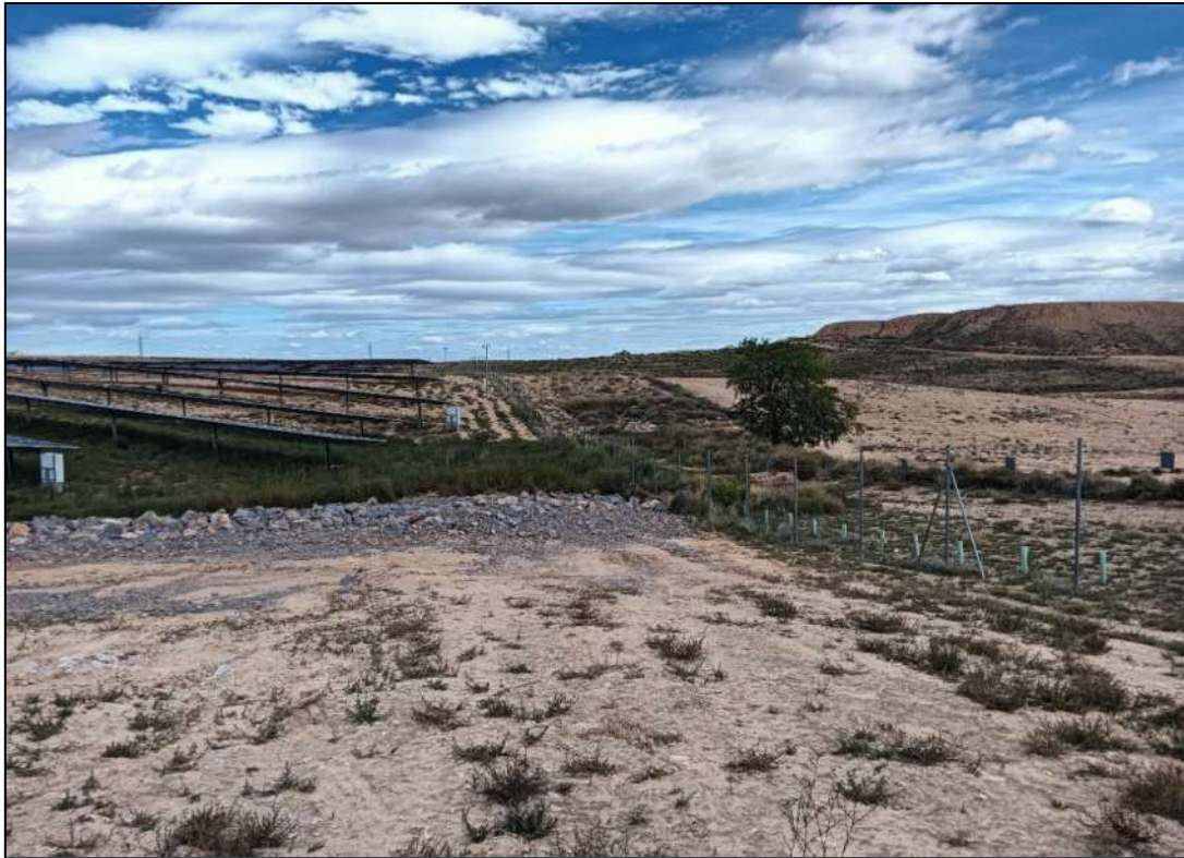
Fotografía 19. Corrección de la erosión mediante zanja drenante
