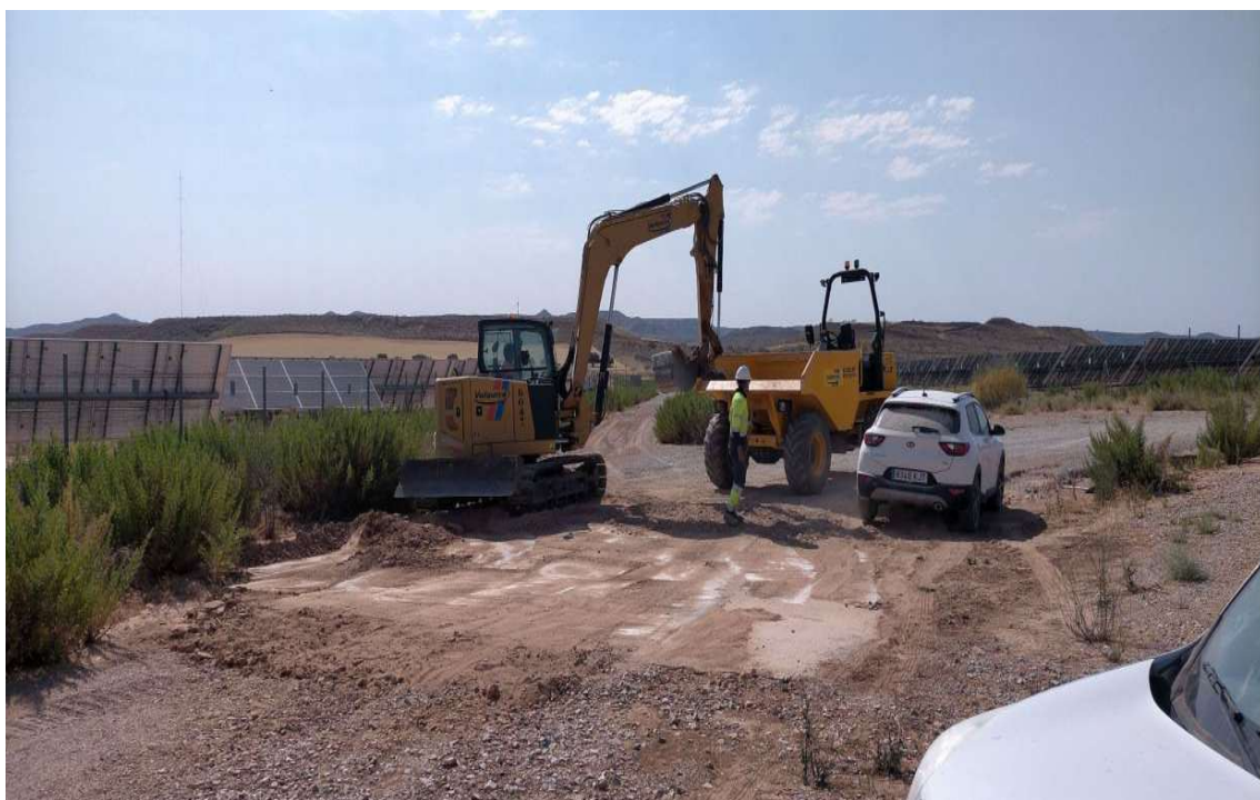
Fotografía 6: Personal trabajando en el acondicionamiento de los viales exteriores de la PFV
