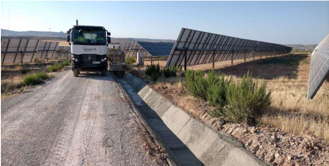
Fotografía 5. Trabajos de hormigonado entre CT-1 y CT-2
