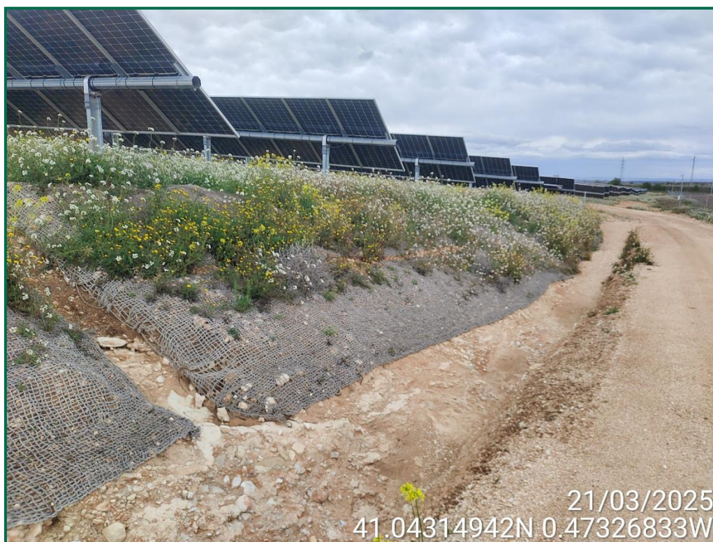
Fotografía 2. Talud interior con malla de coco.
