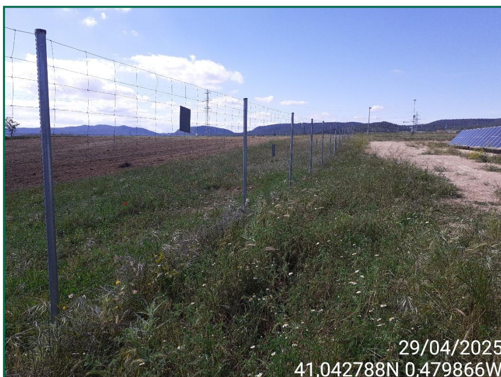
Fotografía 14. Vallado perimetral con placas anticollisión.
