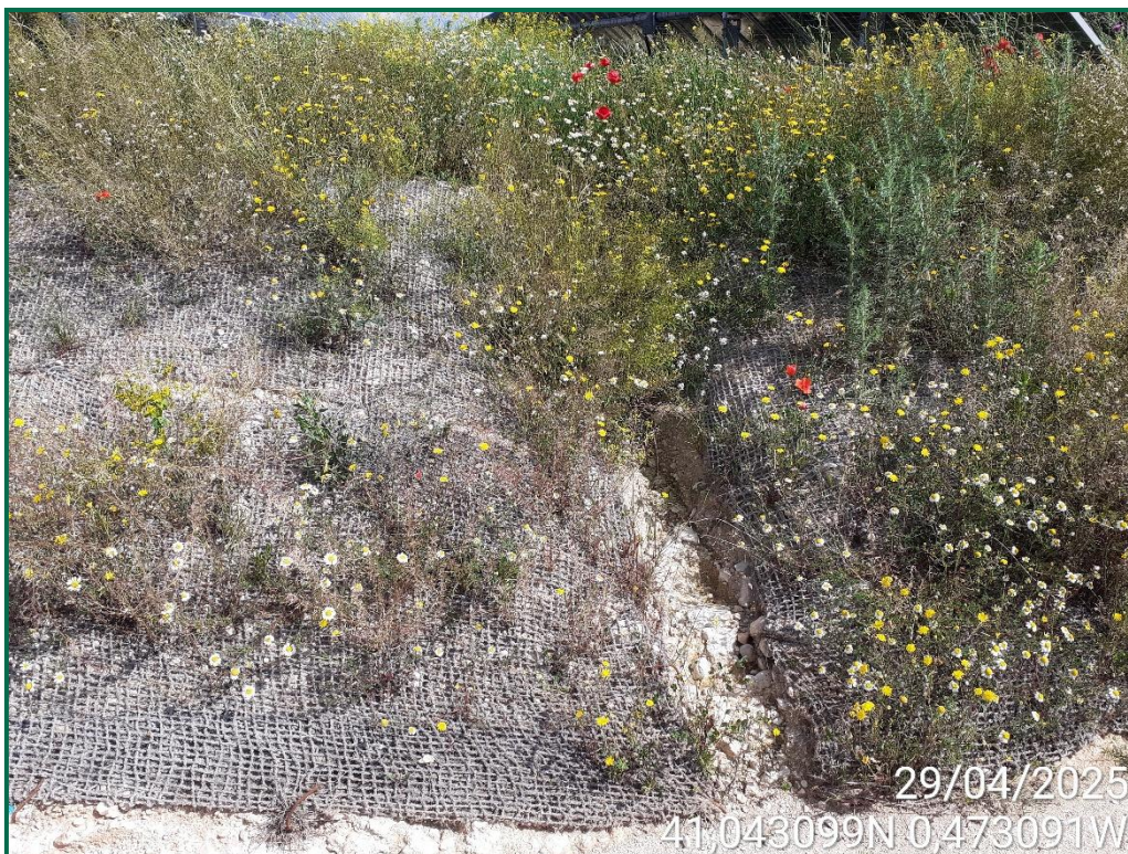
Fotografía 3. Talud interior con malla de coco.
