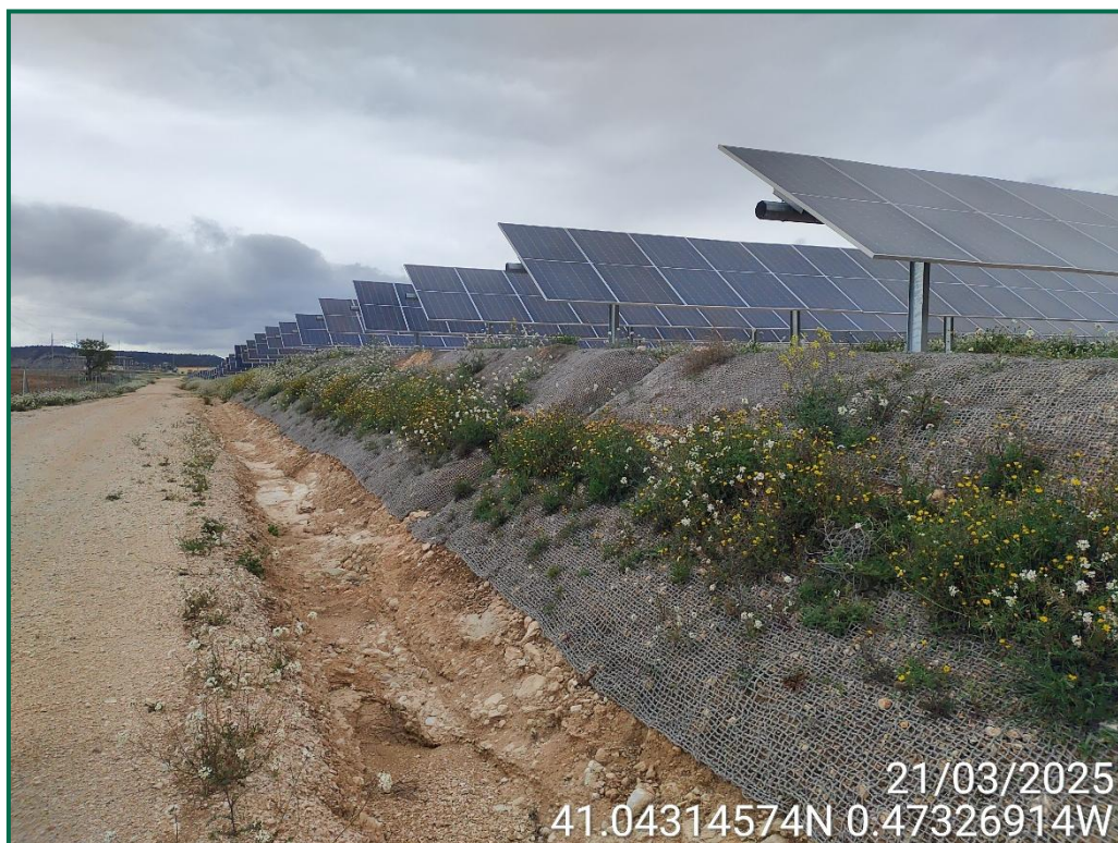
Fotografía 1. Talud interior con malla de coco.
