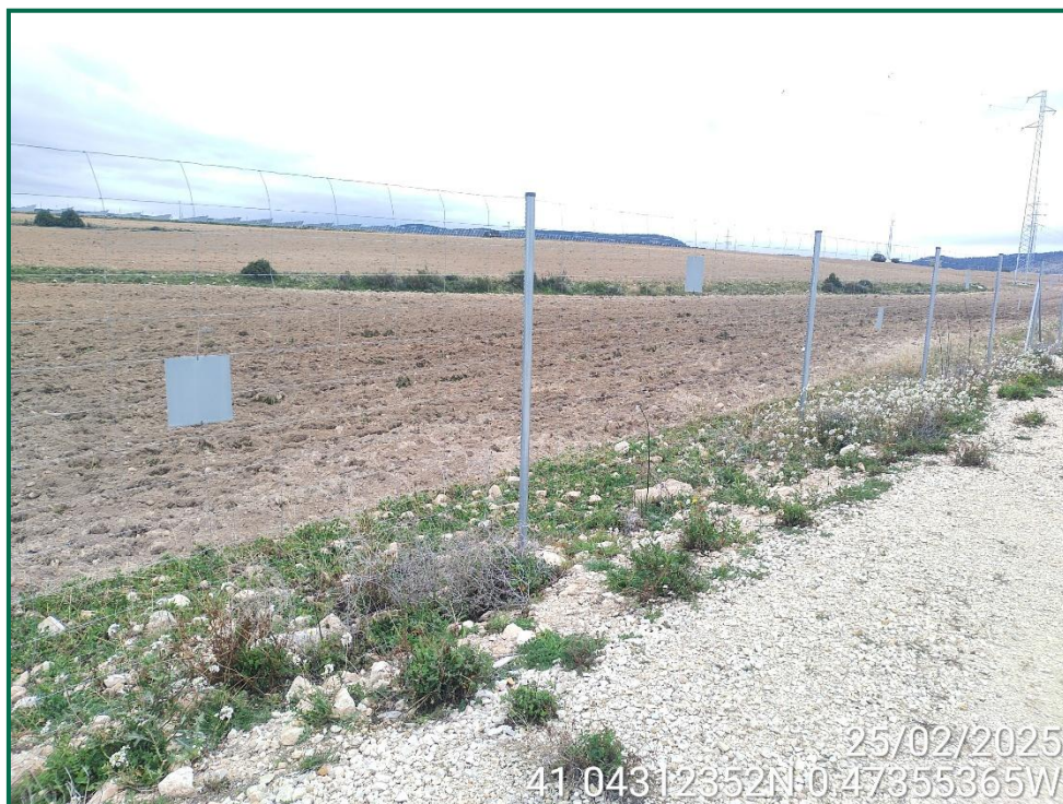
Fotografía 17. Vallado perimetral con placas anticolidión.
