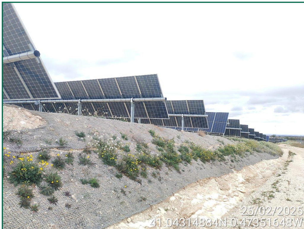
Fotografía 2. Talud interior con malla de coco.
