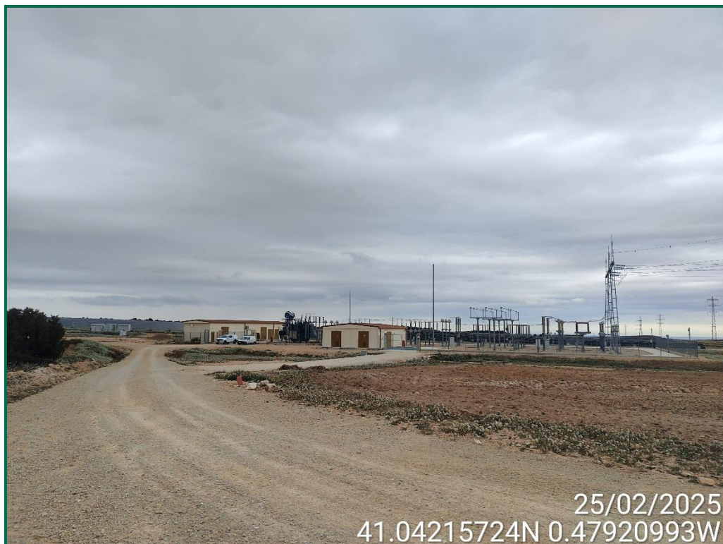
Fotografía 3. Talud de la subestación.
