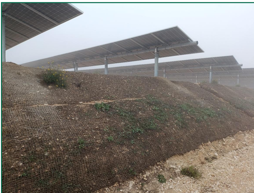
Fotografía 1. Talud interior con malla de coco.
