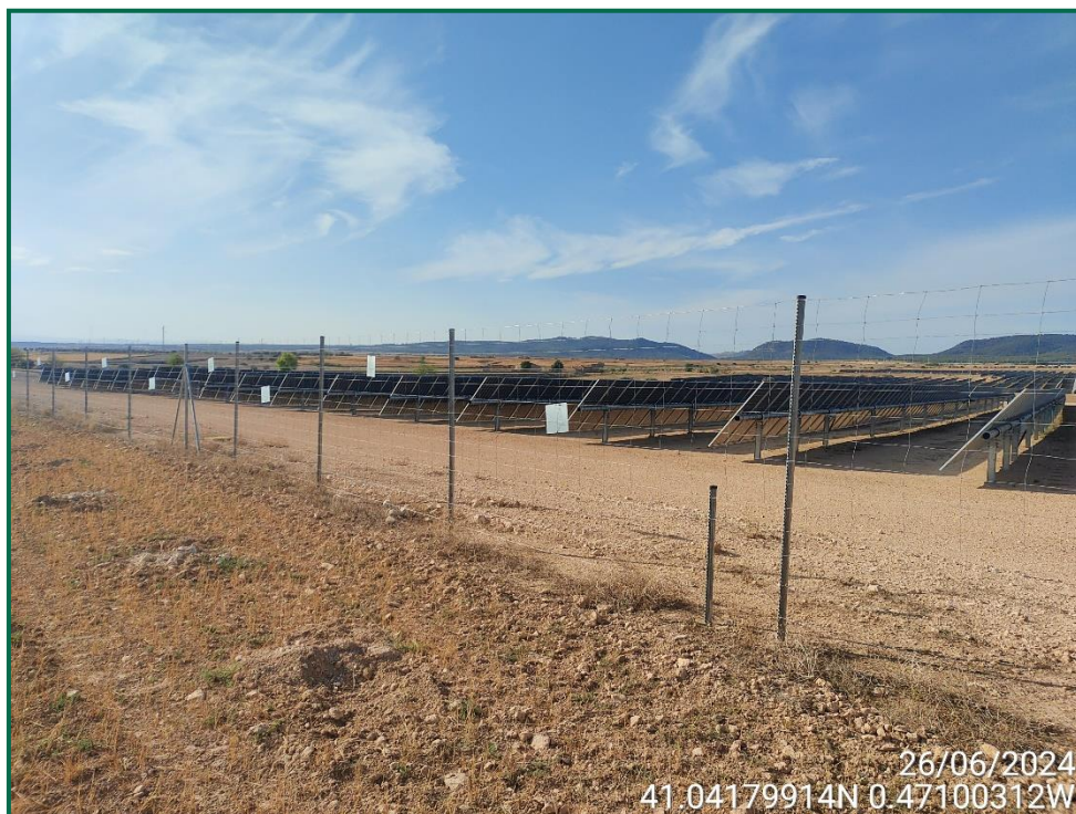
Fotografía 16. Vallado perimetral con placas anticolidión y pasos de fauna.
