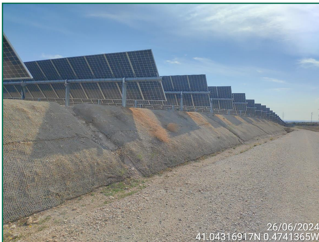
Fotografía 1. Talud con malla de coco.
