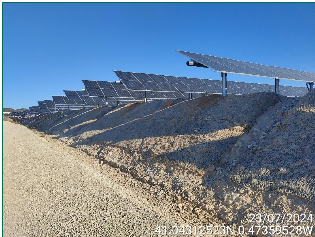
Fotografía 2. Talud con malla de coco.
