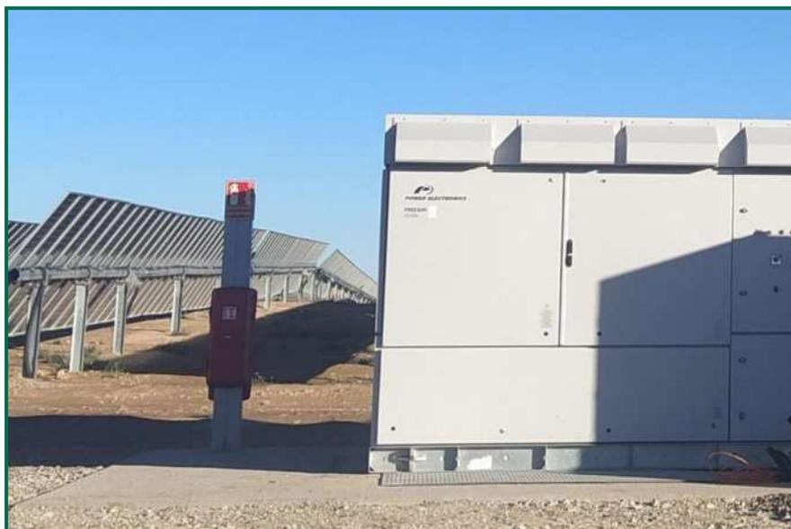
Fotografía 19. Extintor junto a inversor.
