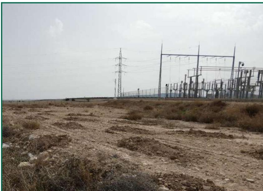
Fotografía 1. Tierra vegetal sobre talud de la SET, ya con algo de vegetación.
