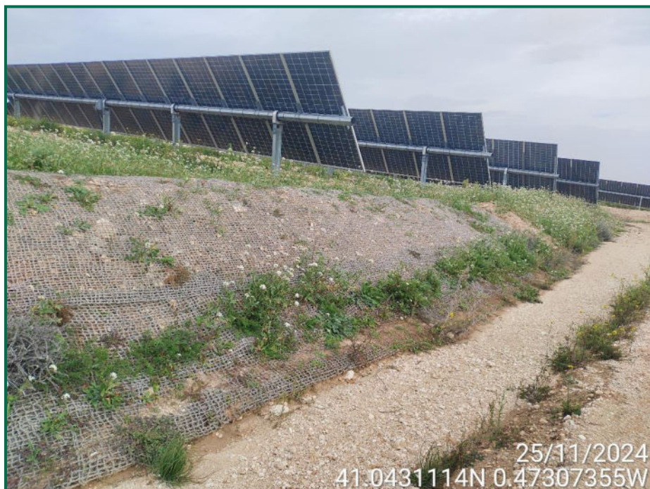
Fotografía 5. Talud con malla de coco en noviembre.
