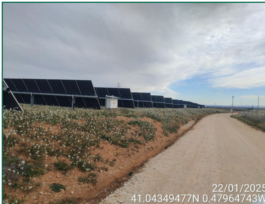
Fotografía 7. Zona de talud sin malla de coco durante el invierno.
