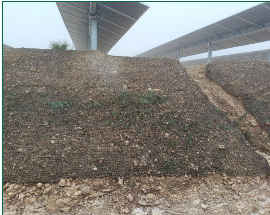
Fotografía 4. Talud con malla de coco con brotes de vegetación.
