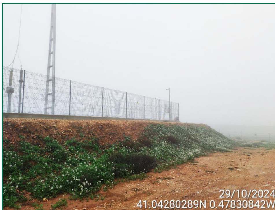
Fotografía 1. Tierra vegetal sobre talud de la SET, ya con algo de vegetación.
