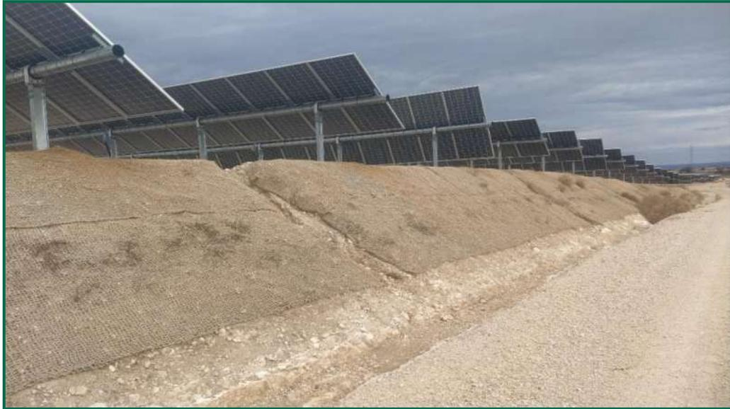
Fotografía 2. Talud con malla de coco.
