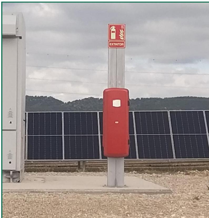
Fotografía 14. Extintor junto a inversores.
