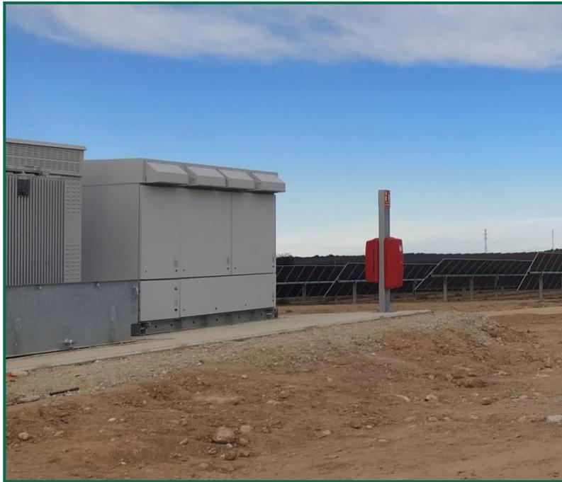
Fotografía 13. Extintor junto a inversores.
