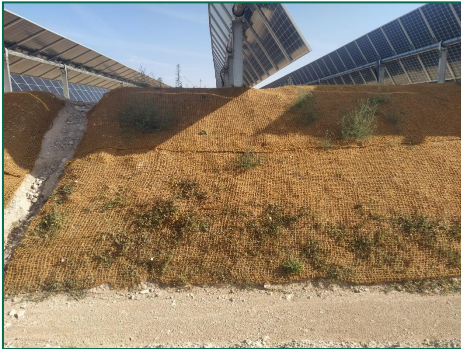
Fotografía 7. Talud con malla de coco en agosto.
