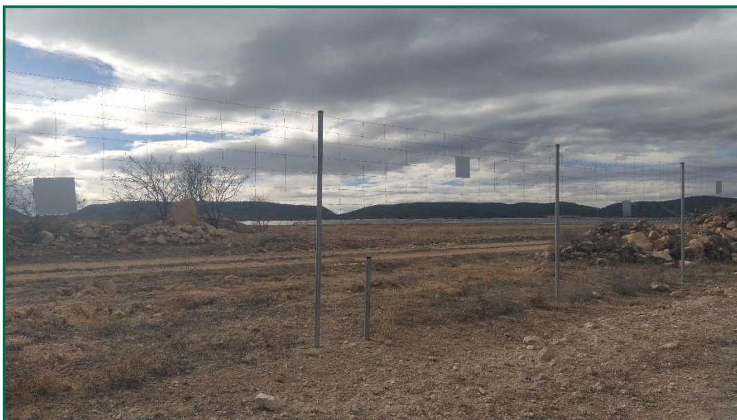
Fotografía 33. Vallado perimetral con placas anticolidión.
