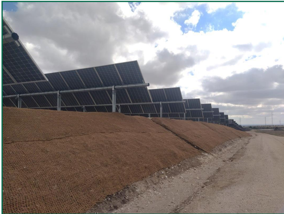
Fotografía 5. Talud con malla de coco recién colocada en el mes de junio.
