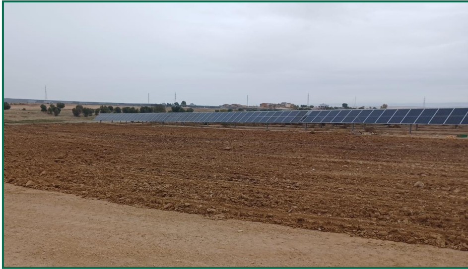
Fotografías 2 y 3. Zonas descompactadas después de las obras.
