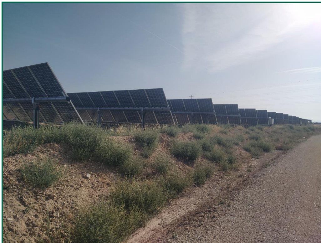
Fotografía 12. Vegetación en talud.
