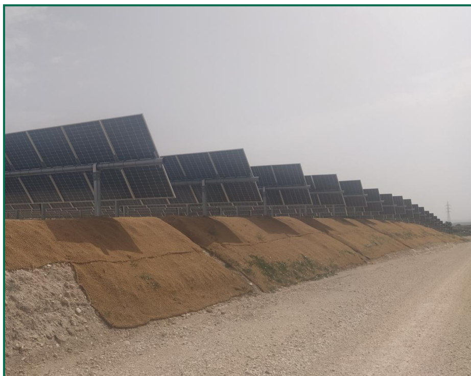
Fotografía 6. Talud con malla de coco con primeros brotes de vegetación en julio.
