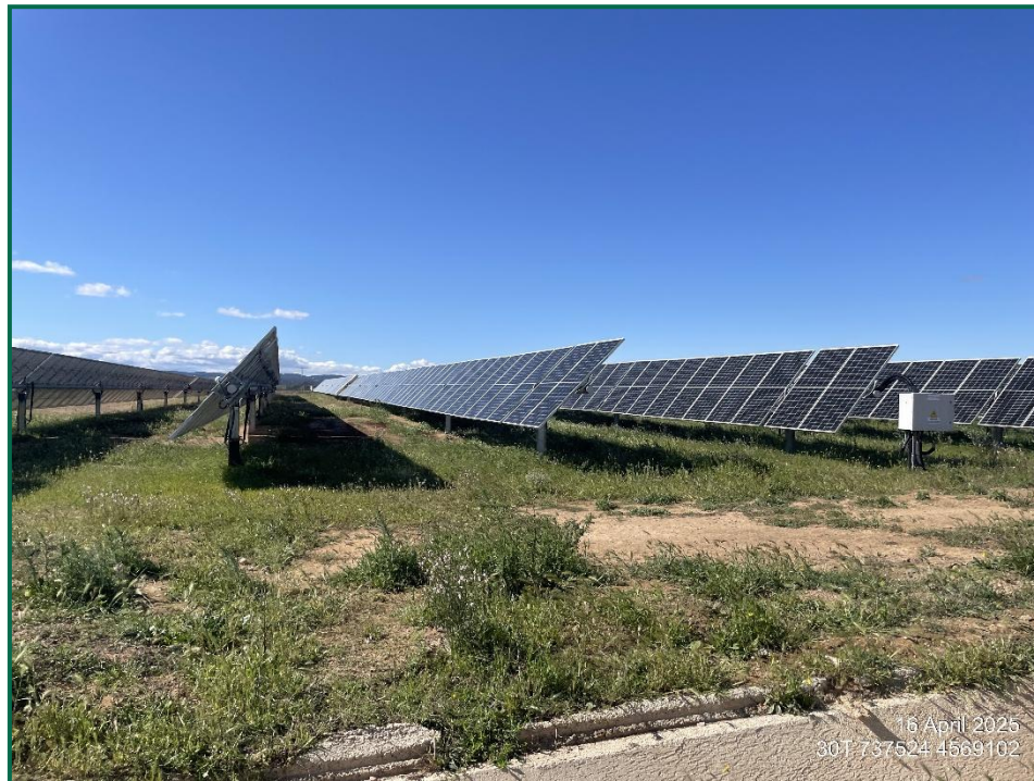
Fotografías 2. Vegetación entre placas actualmente.
