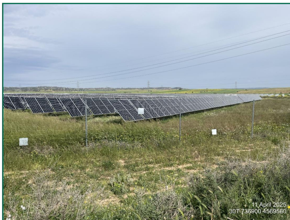
Fotografías 3. Vegetación entre placas actualmente.
