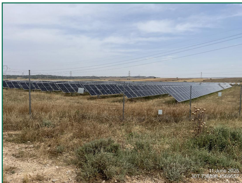
Fotografías 5. Vegetación entre placas actualmente.
