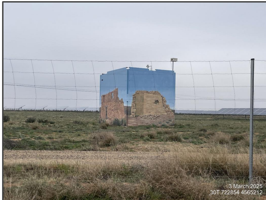
Fotografía 21. Exterior del primillar, pintado.
