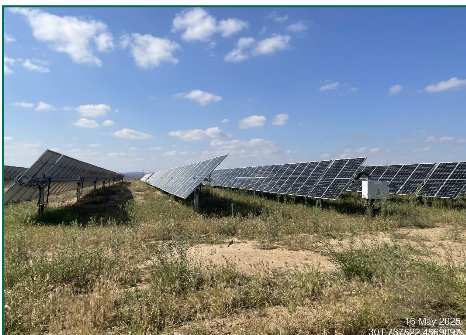
Fotografías 1. Vegetación entre placas actualmente.
