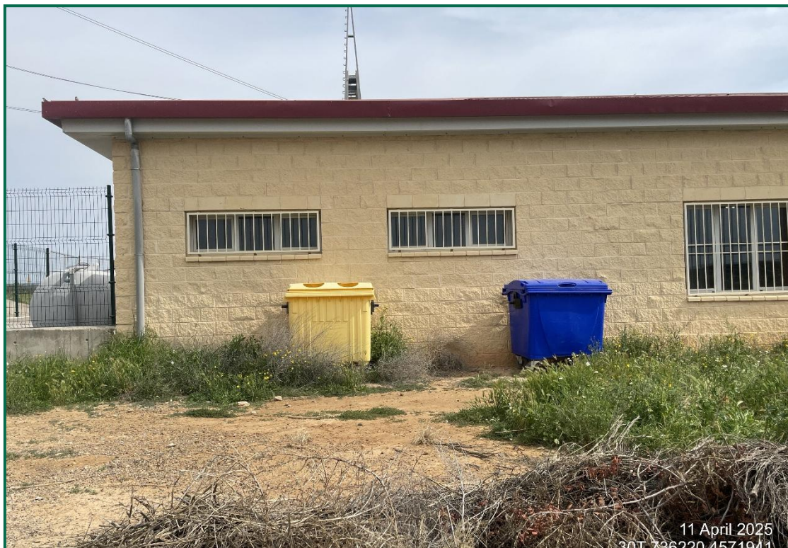
Fotografía 35. Contenedores de residuos no peligrosos en exterior de la subestación.
