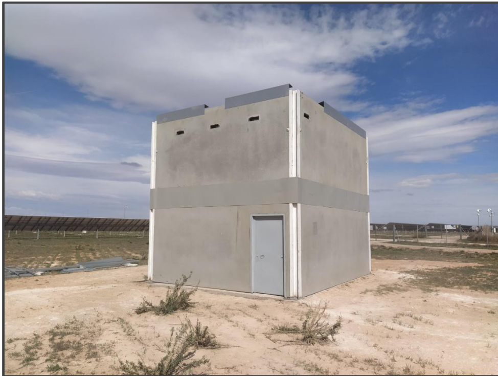
Fotografía 19. Exterior del primillar de nueva construcción.
