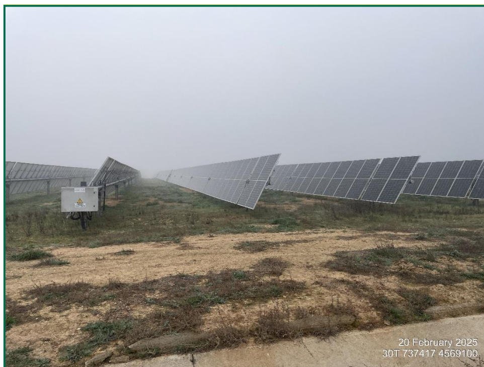
Fotografías 5. Vegetación entre placas actualmente.
