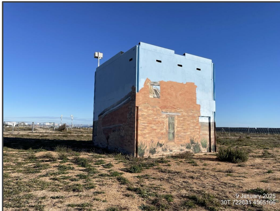
Fotografía 18. Exterior del primillar, pintado.
