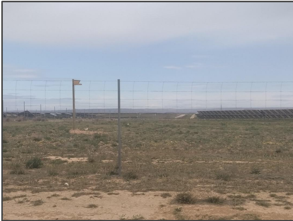
Fotografía 31. Caja para rapaces, sobre poste.
