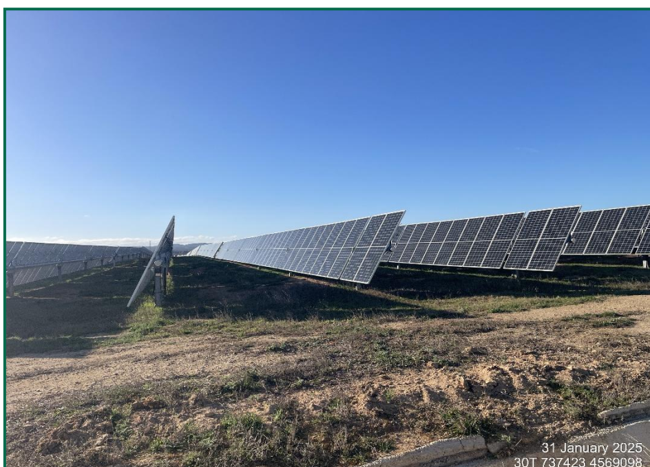
Fotografías 1. Vegetación entre placas actualmente.
