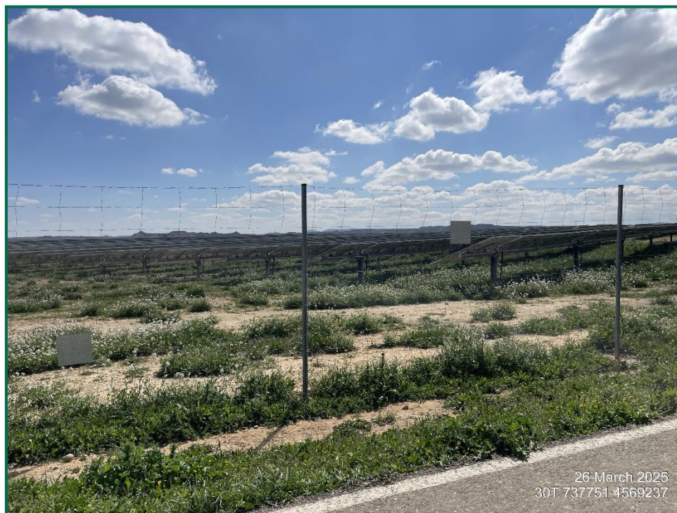
Fotografías 3. Vegetación entre placas actualmente.
