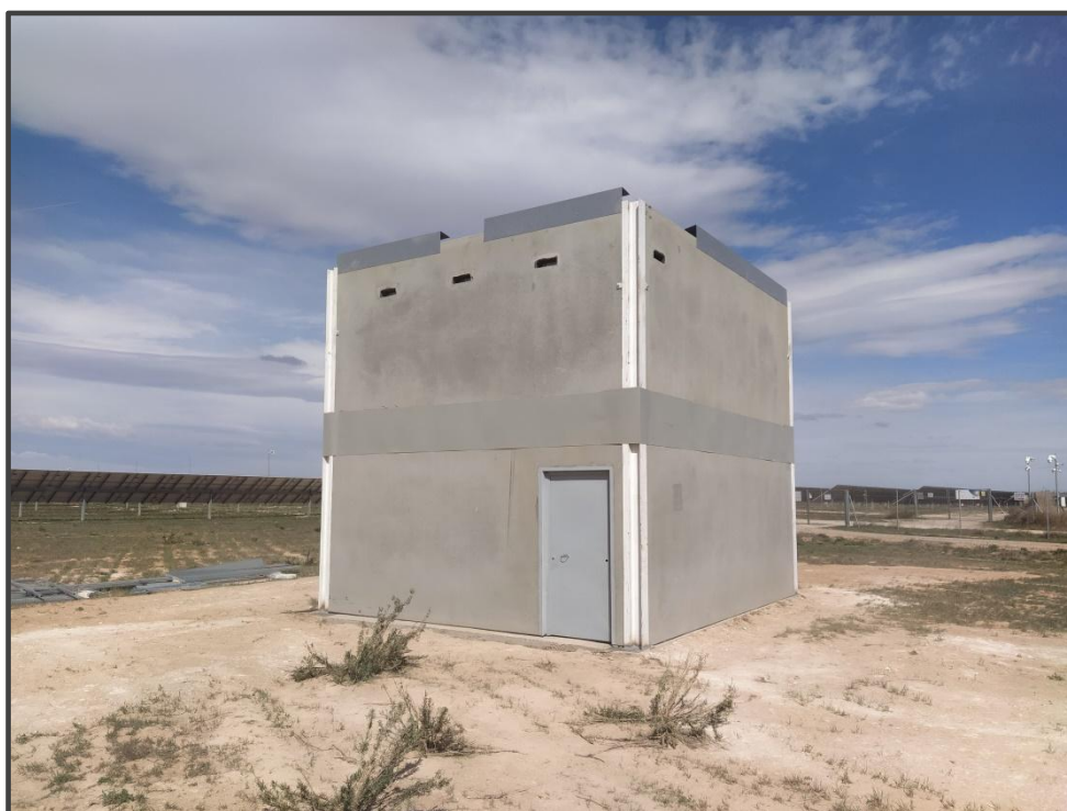
Fotografía 16. Exterior del primillar de nueva construcción.
