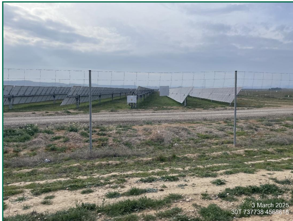
Fotografías 2. Vegetación entre placas actualmente.
