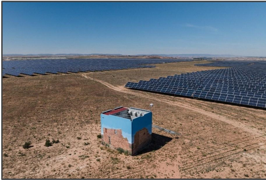
Fotografía 19. Exterior del primillar, pintado.
