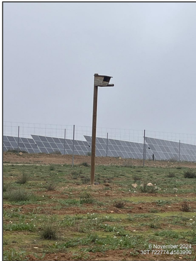
Fotografía 21. Caja para rapaces, sobre poste.
