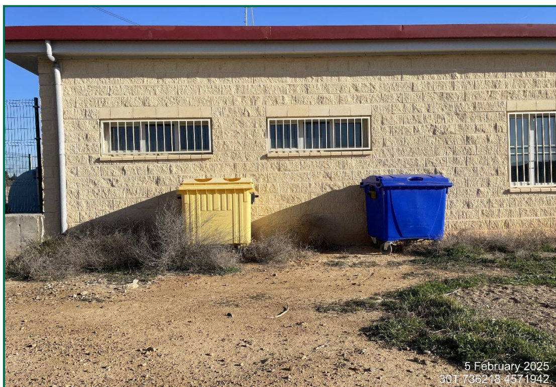
Fotografía 38. Contenedores de residuos no peligrosos en exterior de la subestación.
