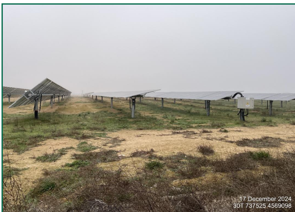
Fotografías 1. Vegetación entre placas actualmente.
