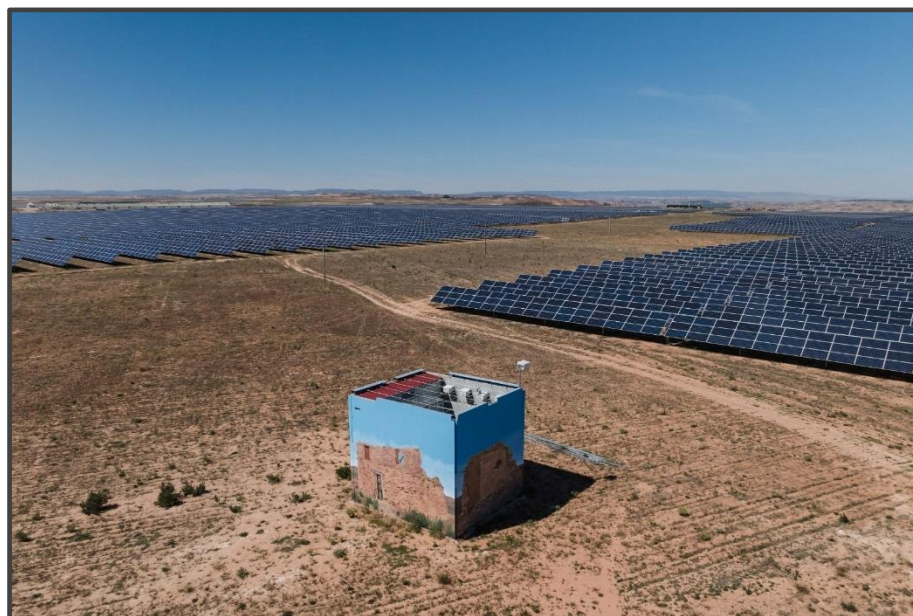
Fotografía 22. Exterior del primillar, pintado.
