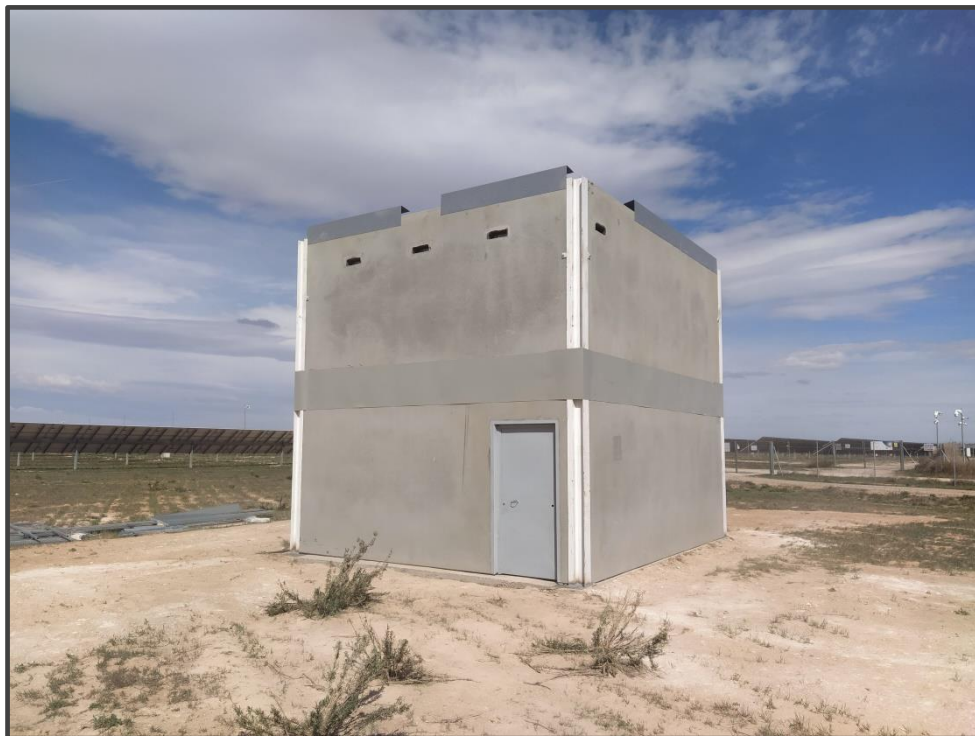
Fotografía 19. Exterior del primillar de nueva construcción.
