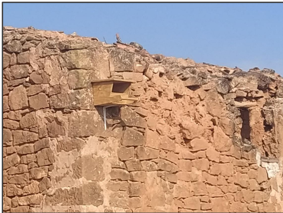
Fotografía 37. Caja para rapaces, sobre muro.
