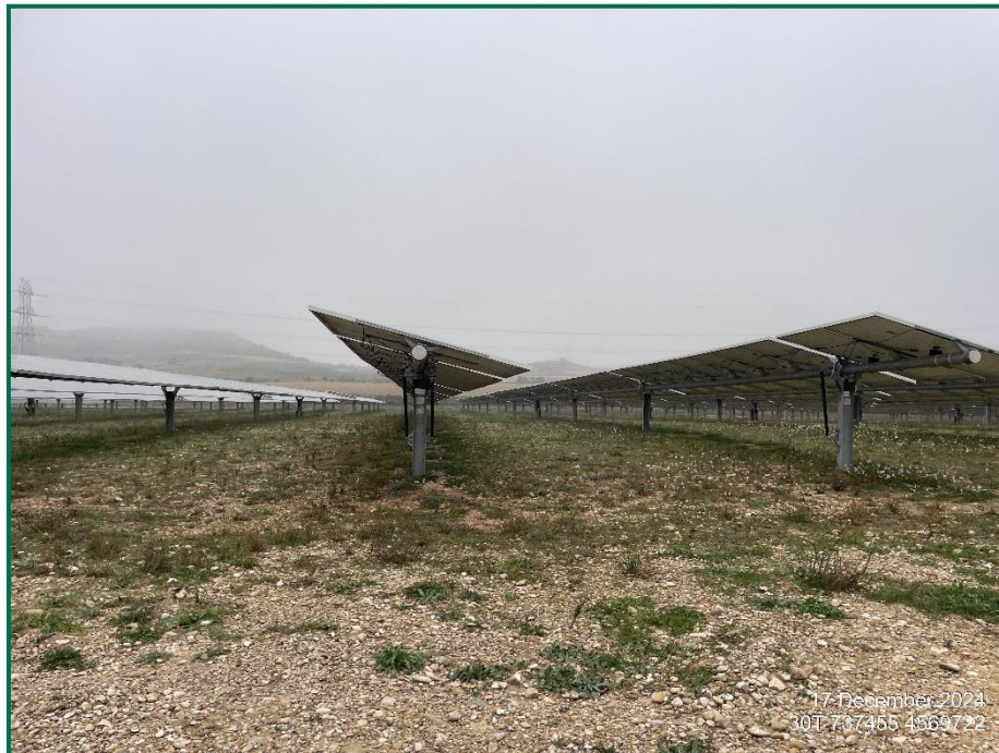
Fotografías 2. Vegetación entre placas actualmente.
