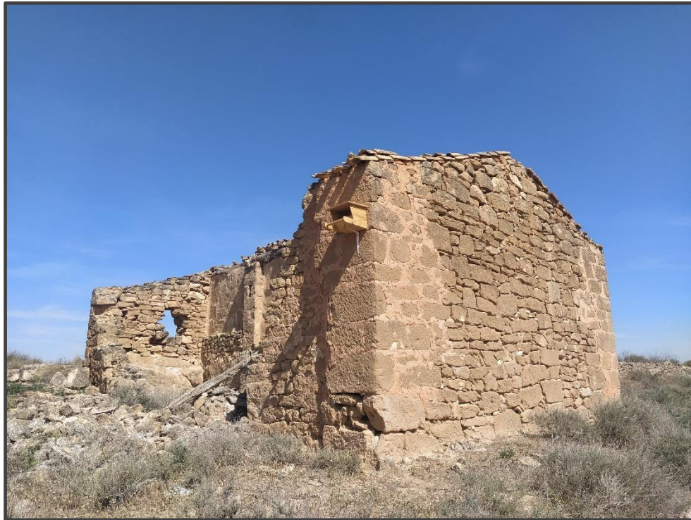
Fotografía 40. Caja para rapaces, sobre muro.
