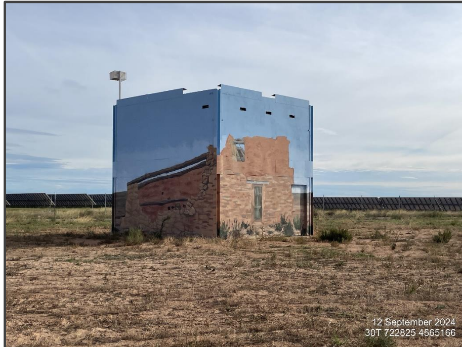
Fotografía 21. Exterior del primillar, pintado.
