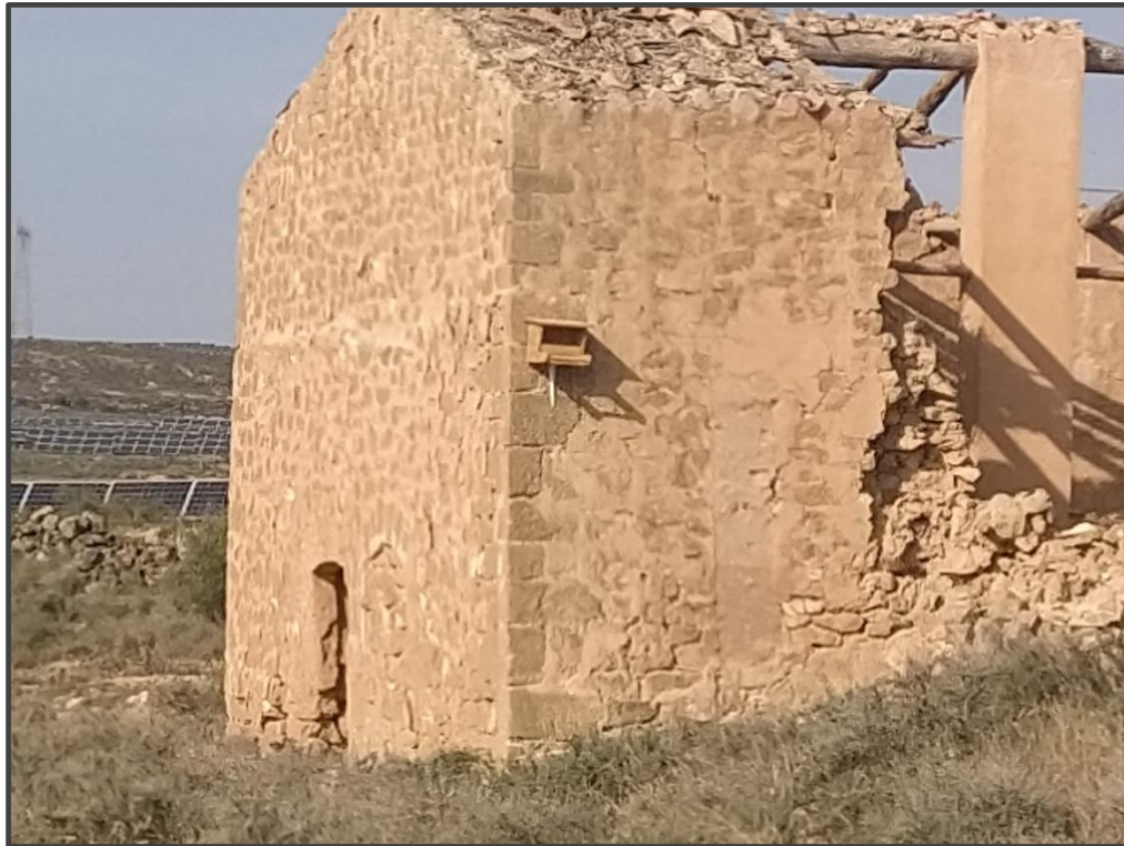
Fotografía 34. Caja para rapaces, sobre muro.
