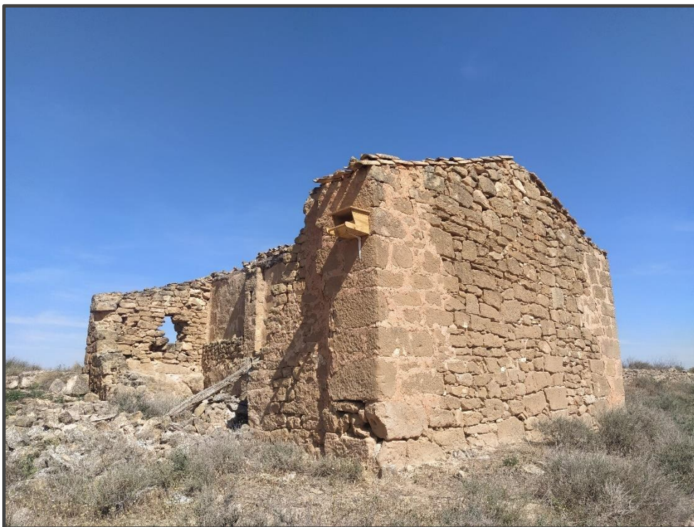
Fotografía 37. Caja para rapaces, sobre muro.
