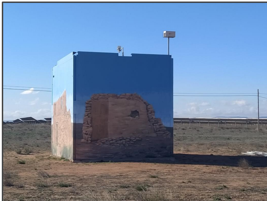
Fotografía 18. Exterior del primillar, pintado.
