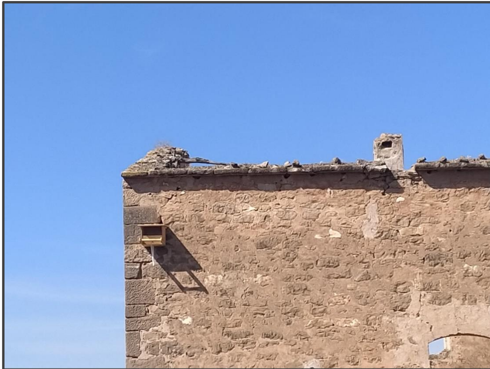
Fotografía 36. Caja para rapaces, sobre muro.
