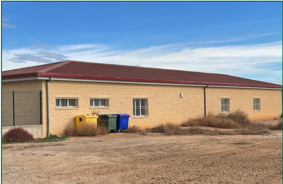
Fotografía 39. Contenedores de residuos no peligrosos en exterior de la subestación.
