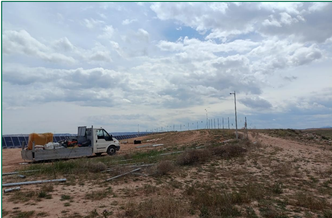
Fotografía 5. Vallado perimetal en proceso de reparación.
