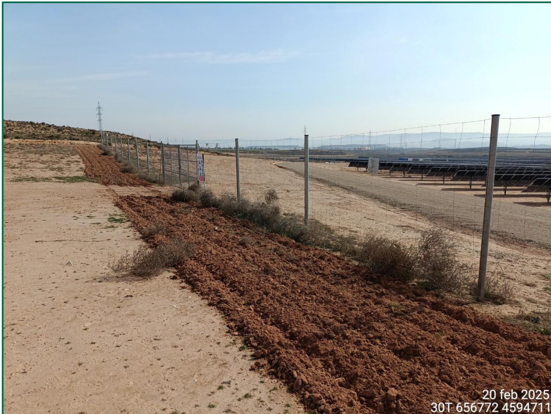
Fotografía 1. Vallado perimetral en la visita de febrero de 2025.
