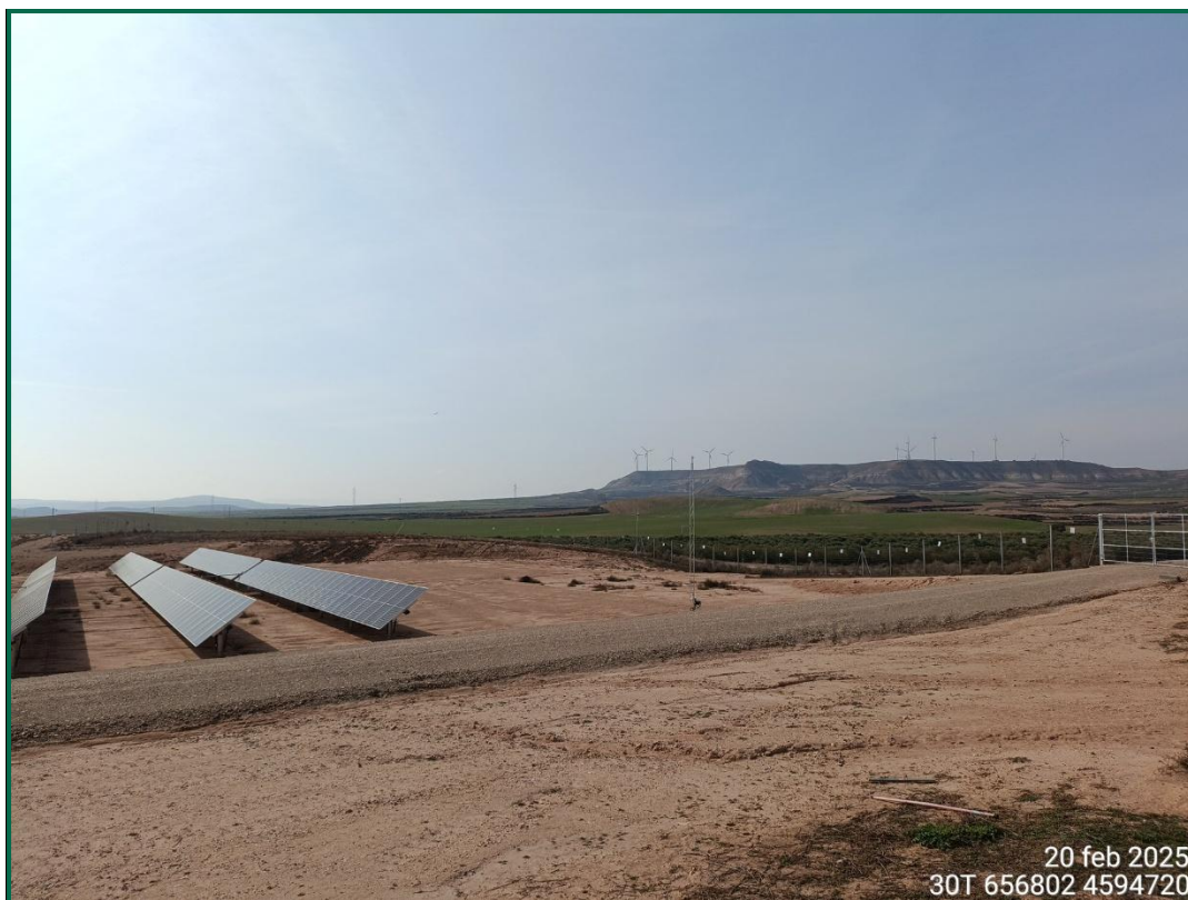
Fotografía 22. Zona de casetas y residuos ya desmantelada.
