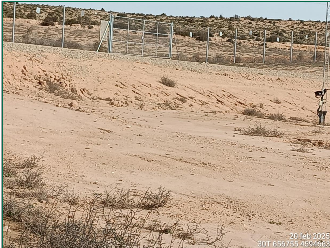
Fotografía 9. Erosión junto al vallado.
