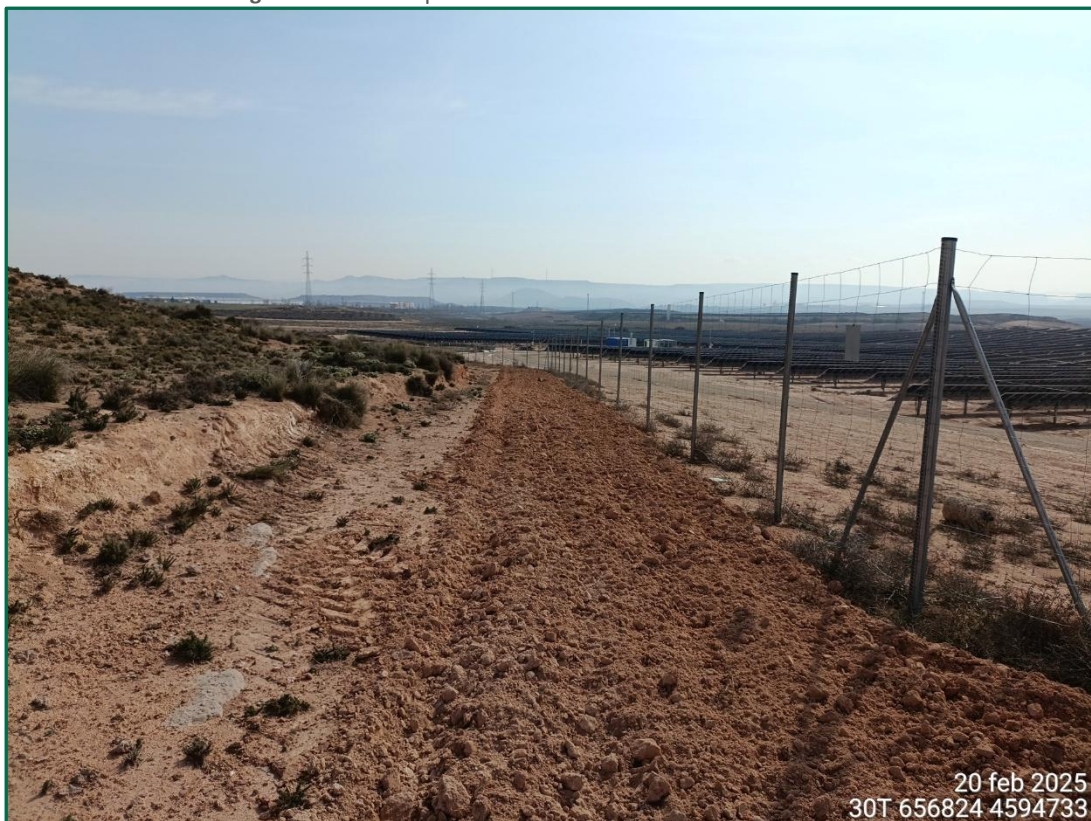
Fotografía 2. Vallado perimetral en la visita de febrero de 2025.
