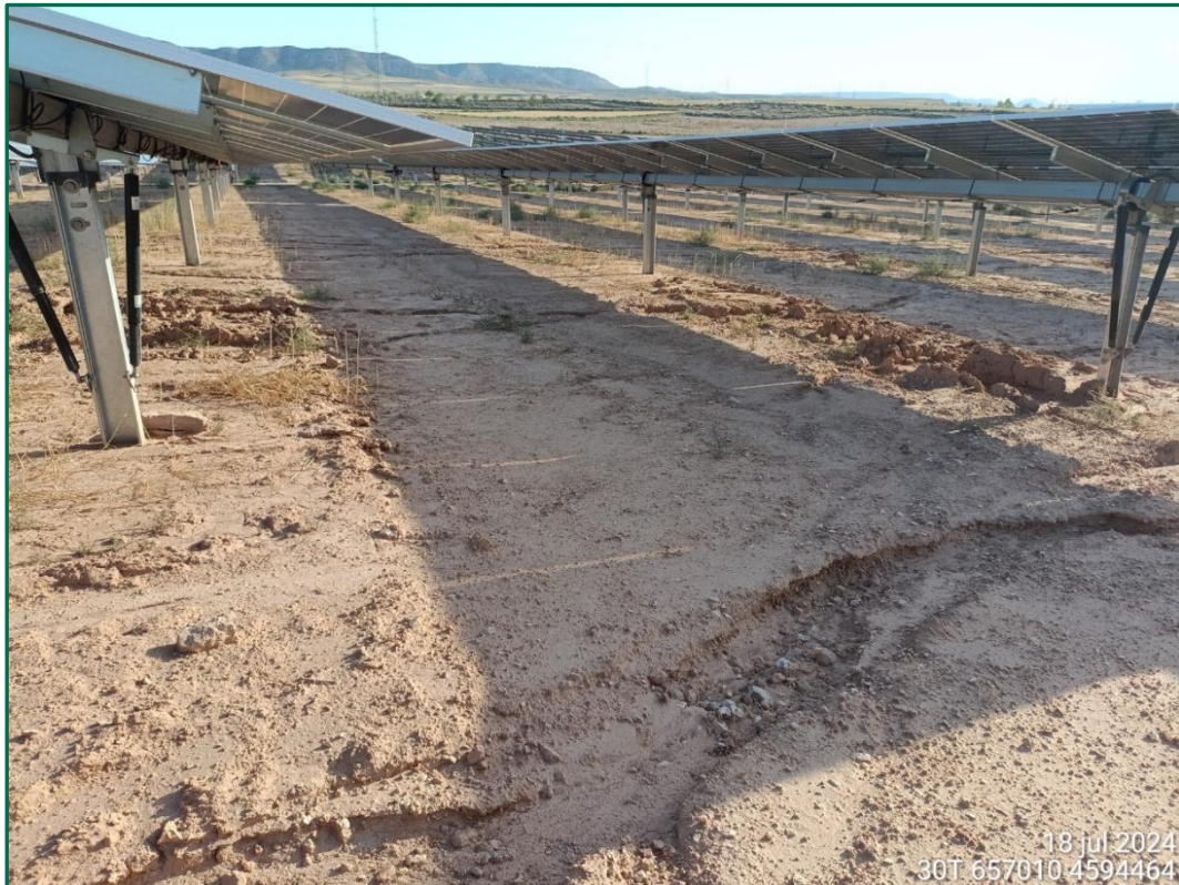
Fotografía 11. Erosión entre plaas solares.
