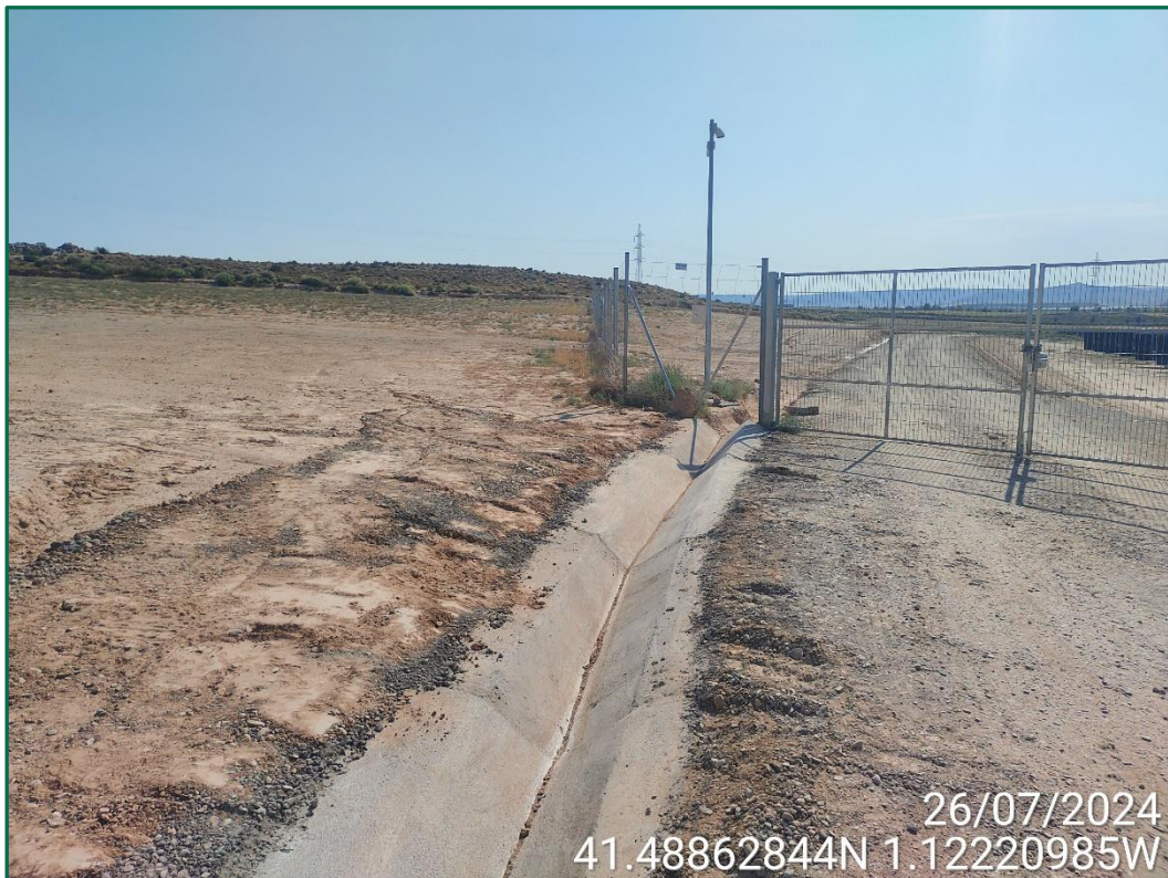
Fotografía 12. Vial y drenaje.
