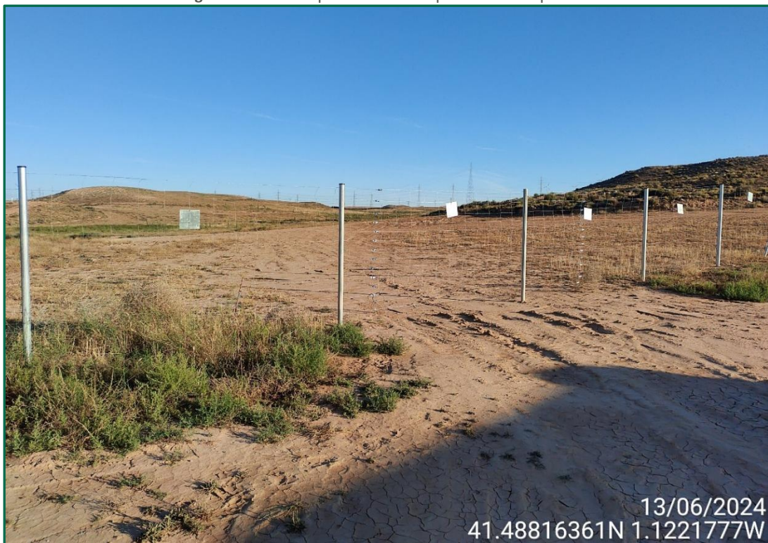
Fotografía 6. Vallado perimetal reparado y reforzado.
