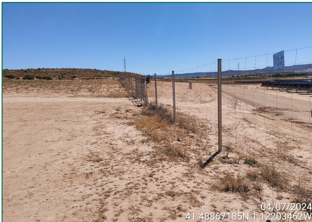
Fotografía 7. Vallado perimetral reparado y reforzado.
