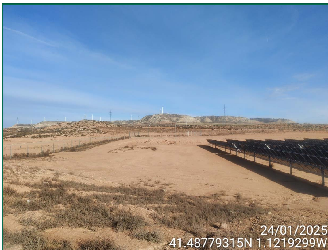
Fotografía 11. Zona de casetas y residuos ya desmantelada.
