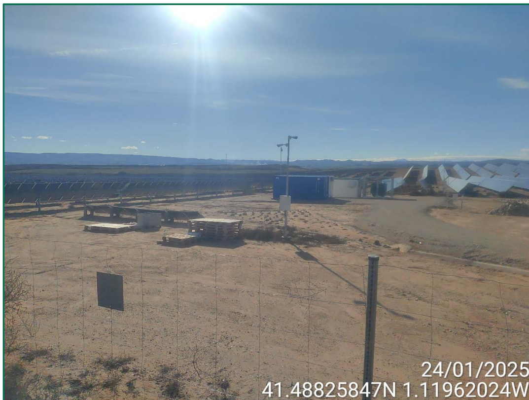
Fotografía 8. Zonas de acumulación de agua.
