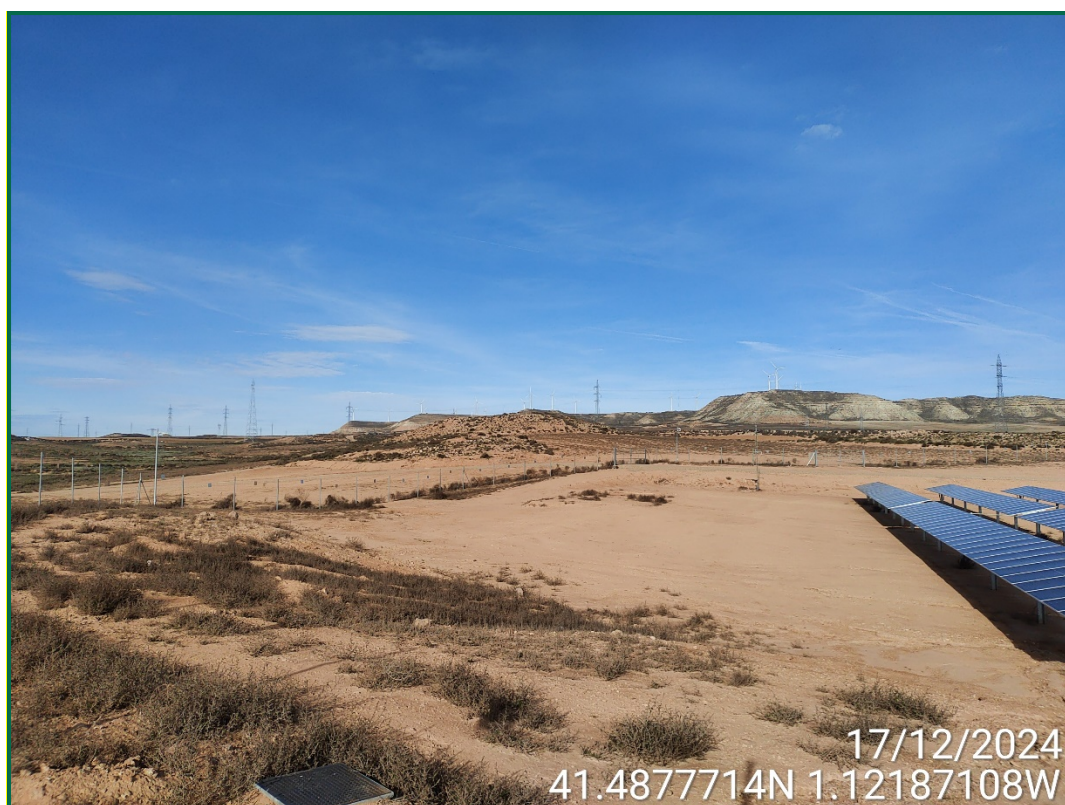
Fotografía 10. Zona de casetas y residuos ya desmantelada.
