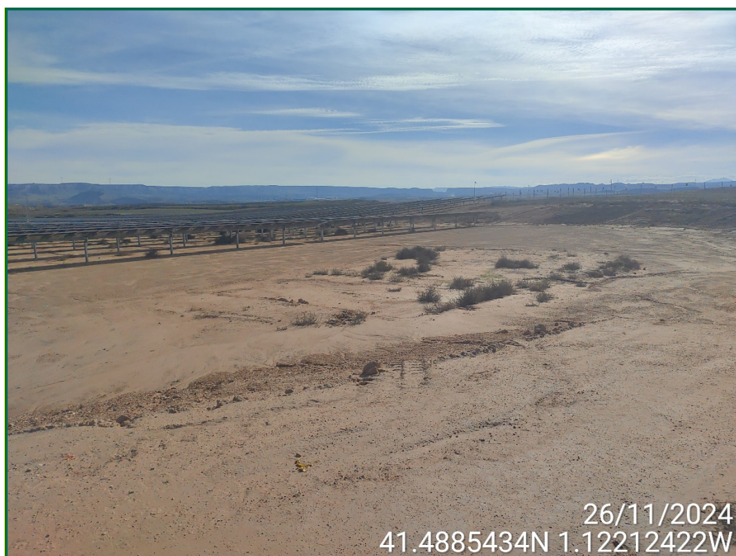
Fotografía 13. Zona de casetas y residuos ya desmantelada.
