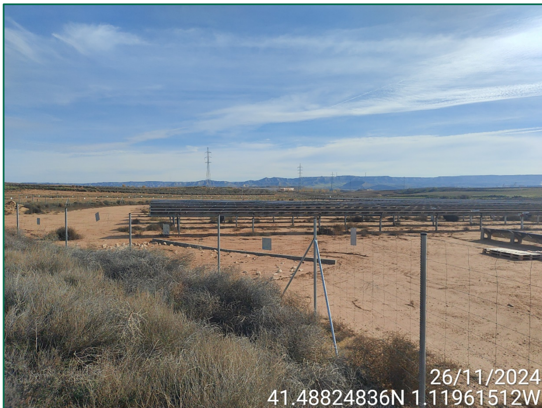
Fotografía 8. Zonas de acumulación de agua.
