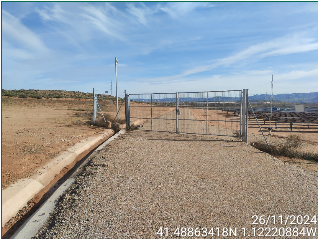
Fotografía 6. Vial y puerta de acceso.
