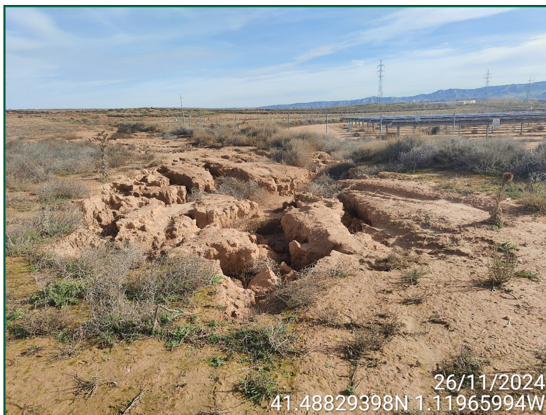
Fotografía 3. Erosión junto al vallado.
