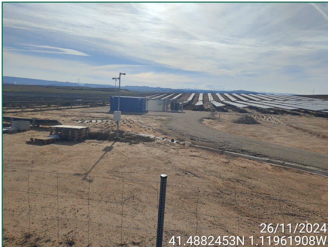
Fotografía 7. Zonas de acumulación de agua.
