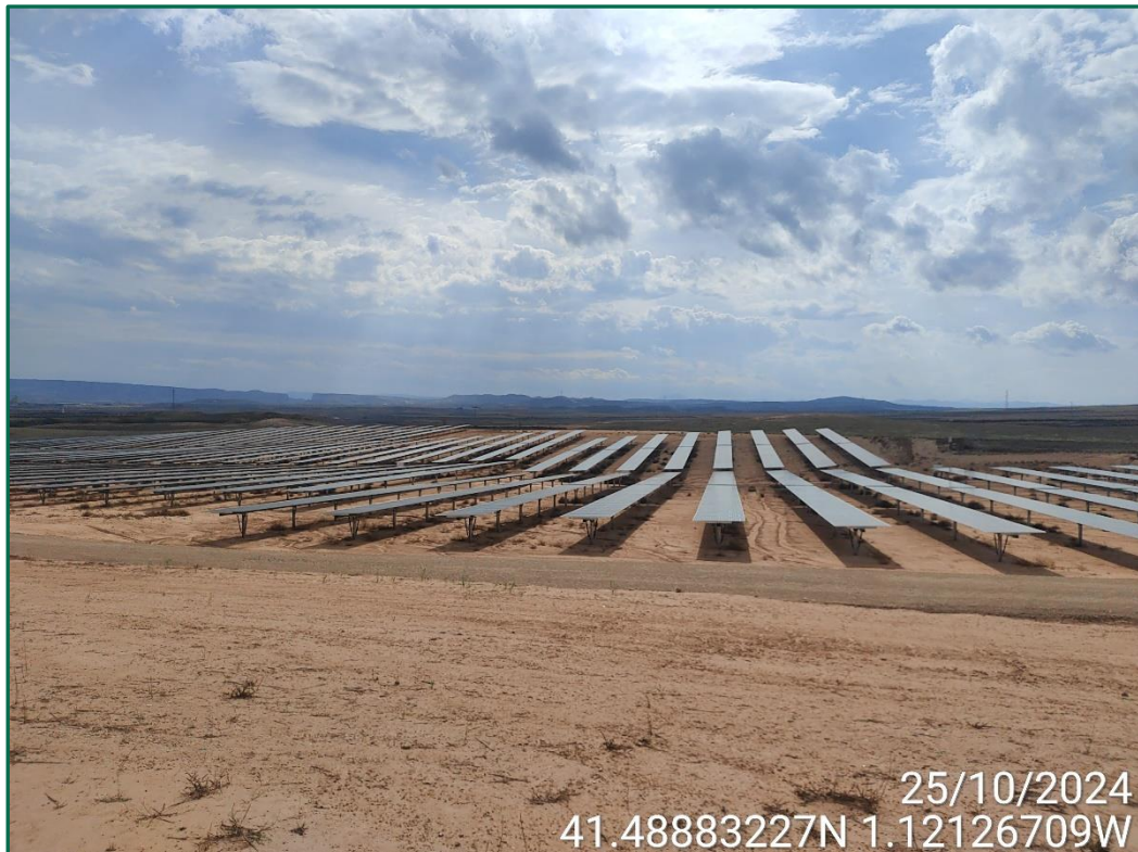
Fotografía 4. Erosión entre las placas fotovoltaicas.
