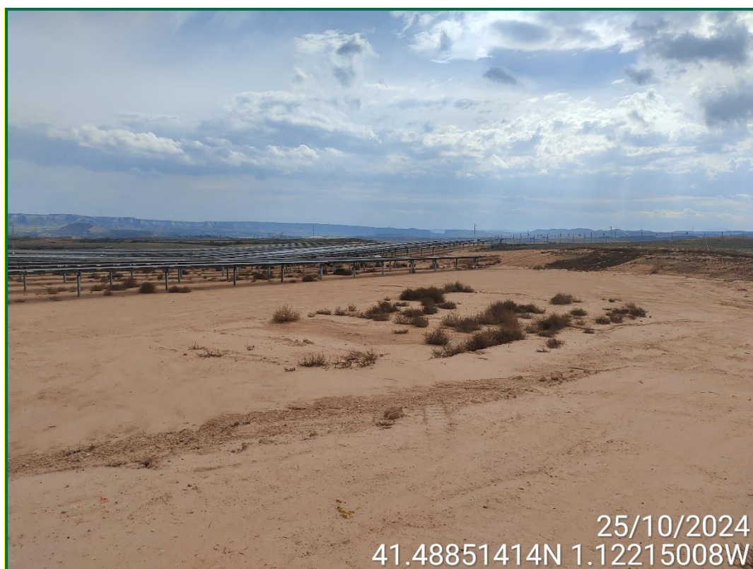
Fotografía 11. Zona de casetas y residuos ya desmantelada.
