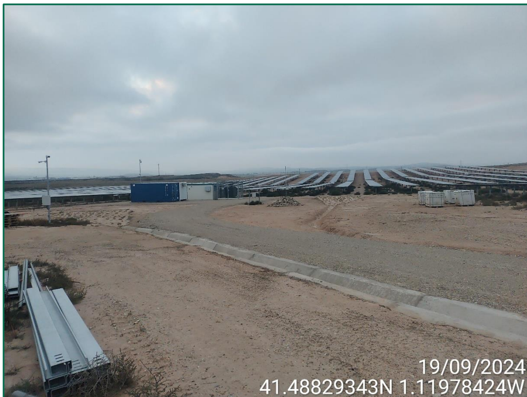
Fotografía 9. Zonas de acumulación de agua.
