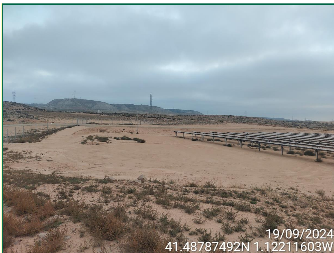
Fotografía 16. Zona de casetas y residuos ya desmantelada.
