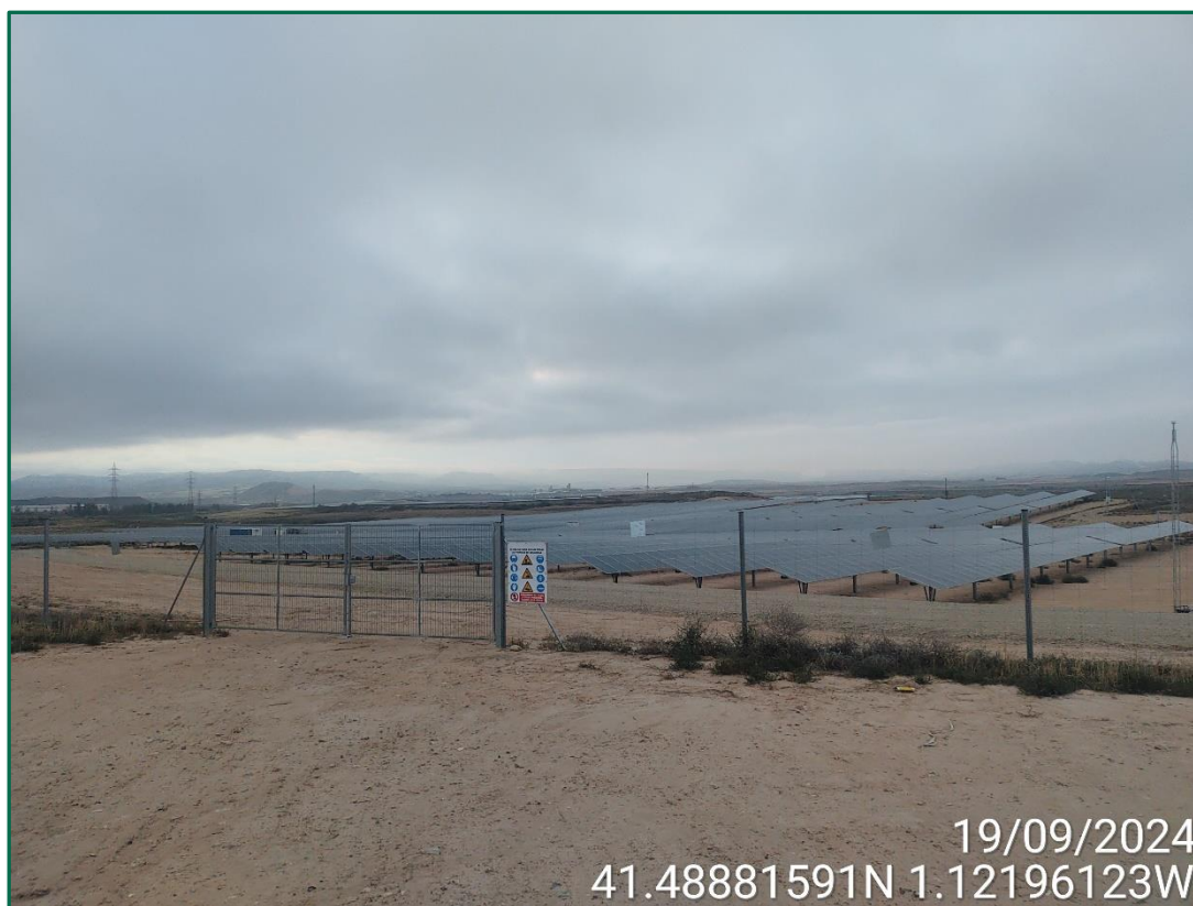
Fotografía 1. Vallado perimetral y puerta de acceso.
