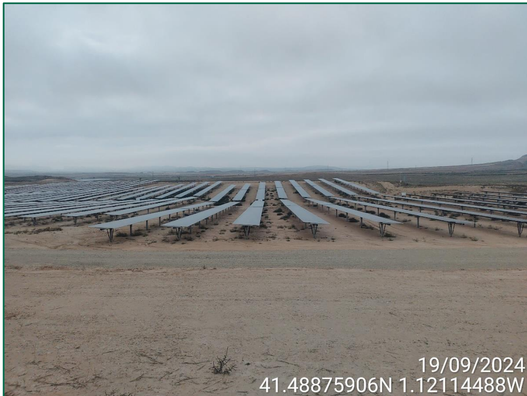
Fotografía 6. Erosión entre las placas fotovoltaicas.
