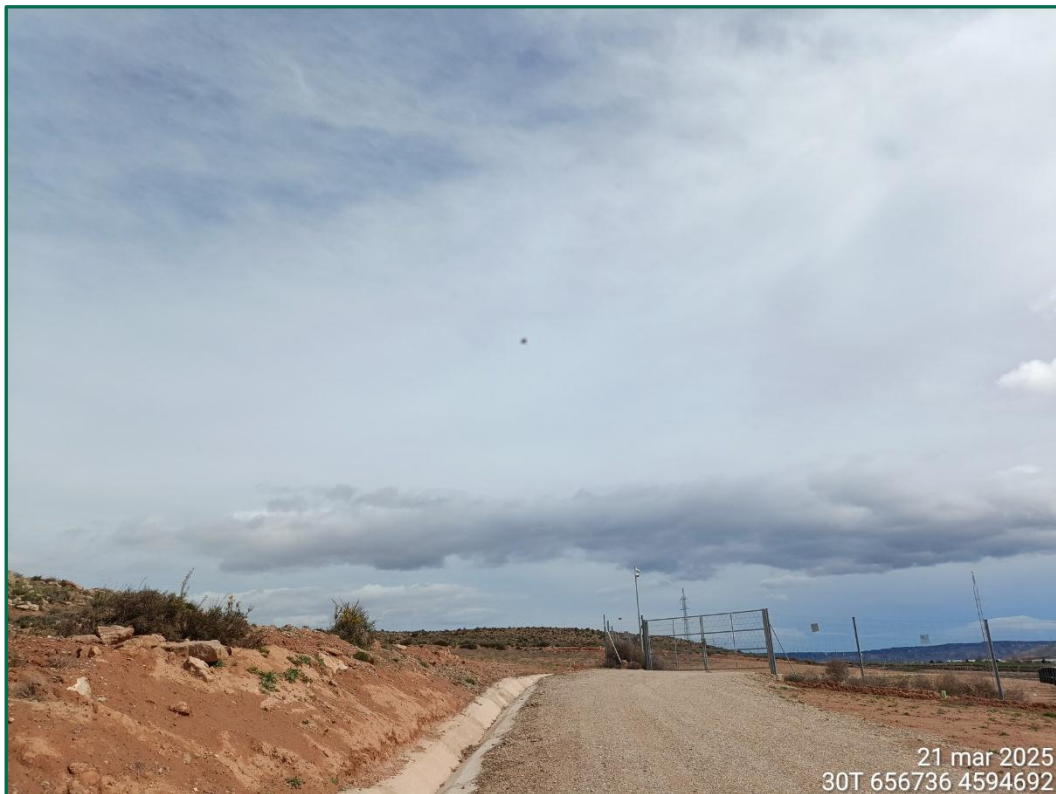
Fotografía 3. Vial y drenaje.
