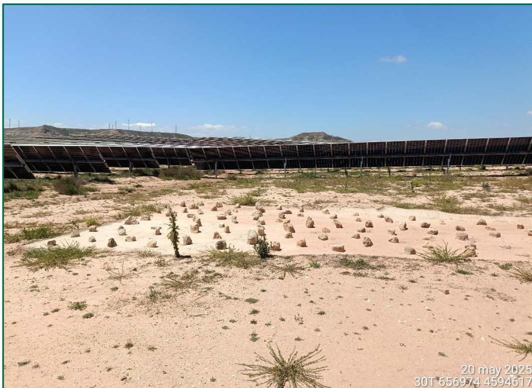
Fotografía 4. Zonas de acumulación y disipación de velocidad del agua.
