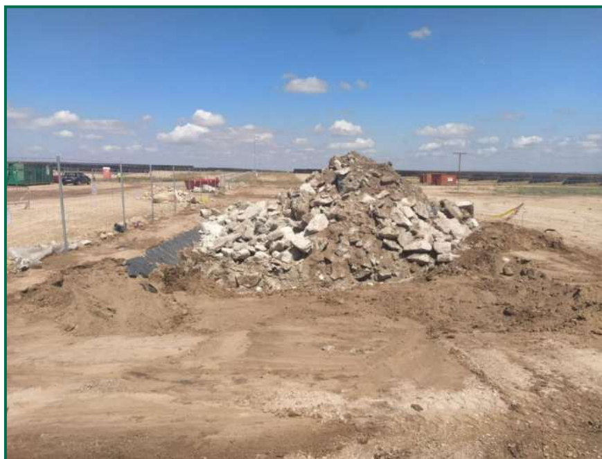
Fotografía 35. Zona de lavado de hormigón en proceso de retirada.
