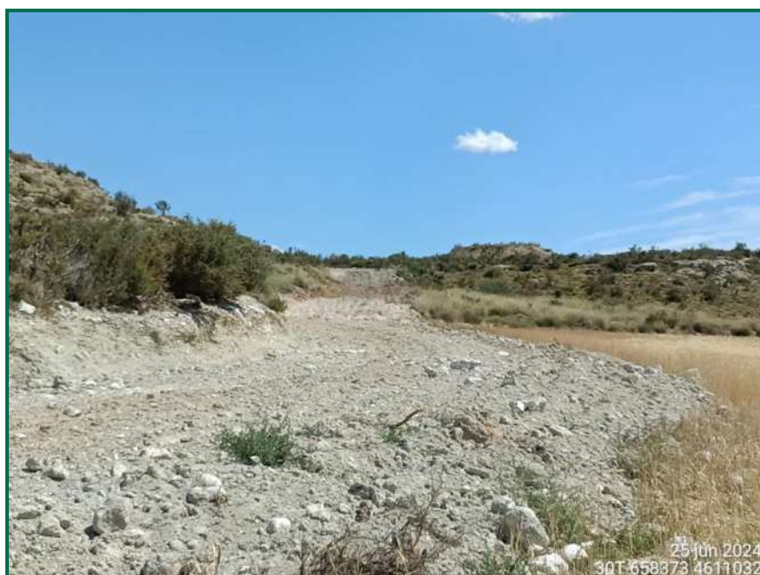
Fotografía 17. Acceso apoyo 17 después de extender la tierra vegetal.
