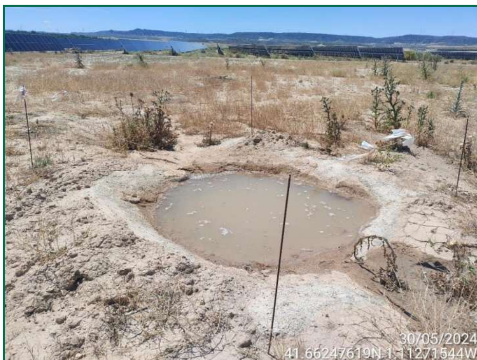
Fotografía 27. Balsete ya construido. Estado en mayo 2024
