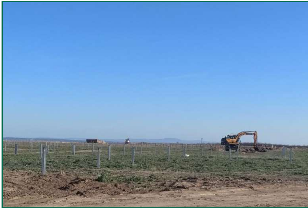
Fotografía 11. Hincas sobre el terreno.
