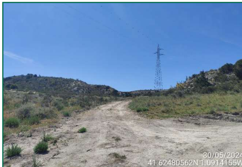
Fotografía 16. Acceso apoyo 21 en mayo, antes de la restitución.
