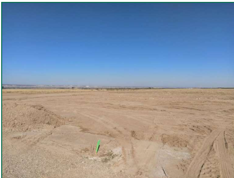
Fotografía 1. Jalonamiento previo mediante estacas.
