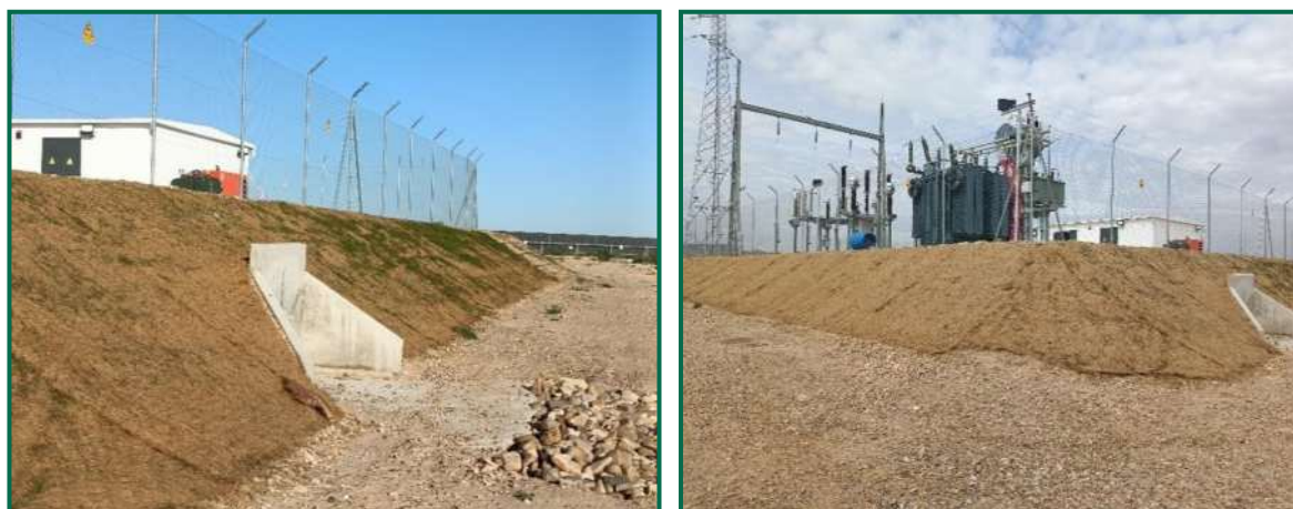
Fotografías 51, 52, 53 y 54. Malla vegetal en talud de la subestación.
