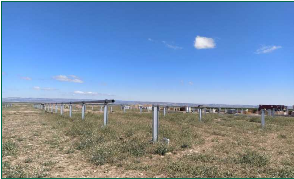
Fotografía 13. Hincas sobre el terreno.
