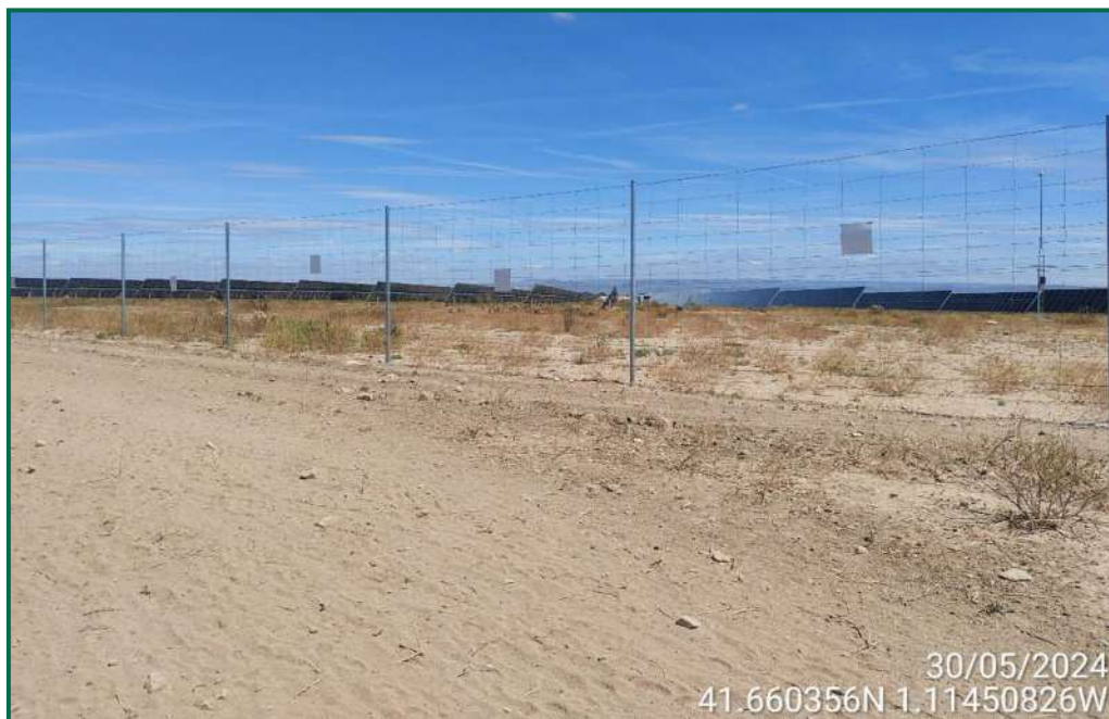
Fotografía 20. Vallado con placas anticollisión.
