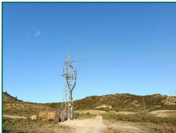
Fotografías 47 y 48. Apoyos en proceso de instalación.
