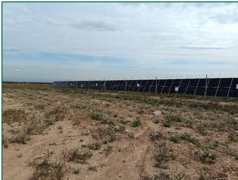
Fotografía 42. Zona con plantones ya colocados.
