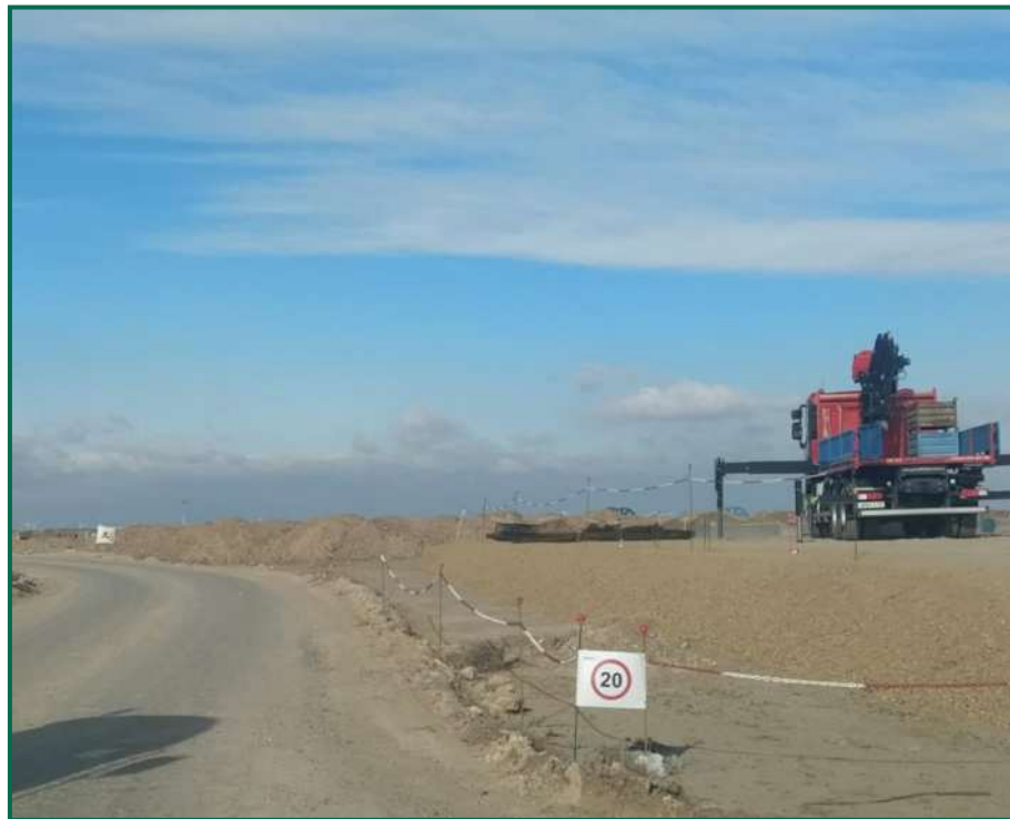
Fotografía 6. Señal de limitación de velocidad al inicio de las obras.
