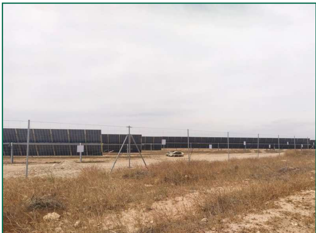
Fotografía 5. Vallado con placas anticollisión.
