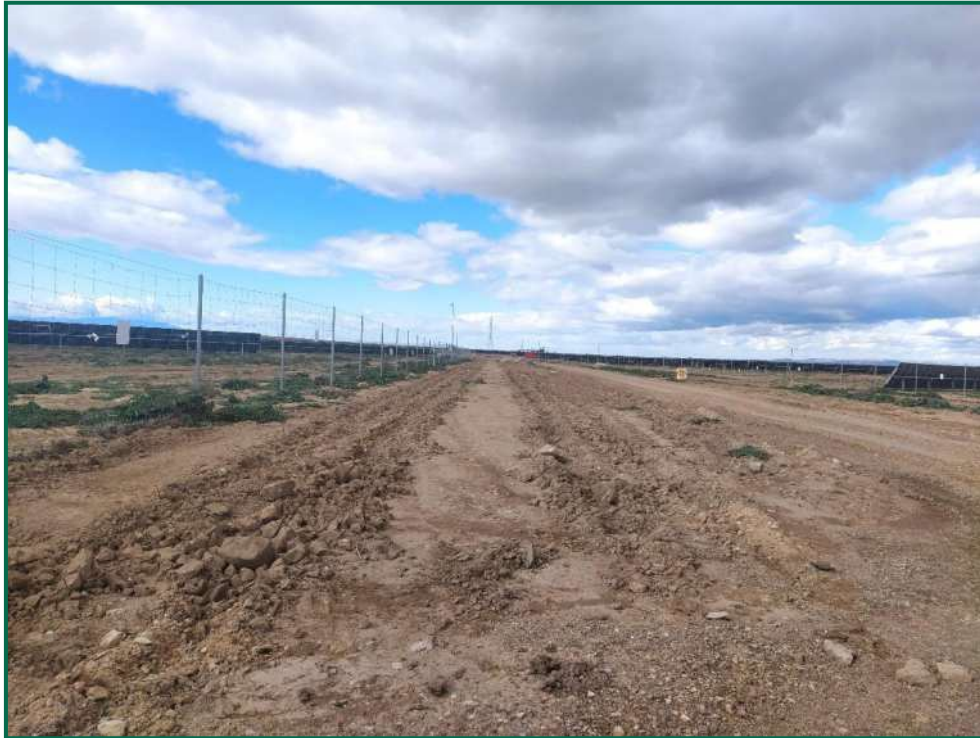
Fotografía 41. Zona con plantones ya colocados.
