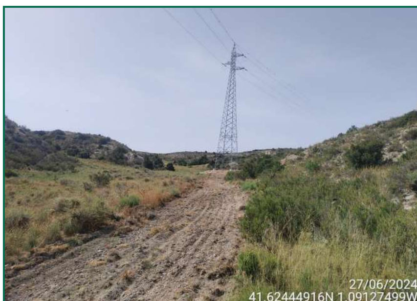
Fotografía 18. Acceso apoyo 21 después de extender la tierra vegetal.
