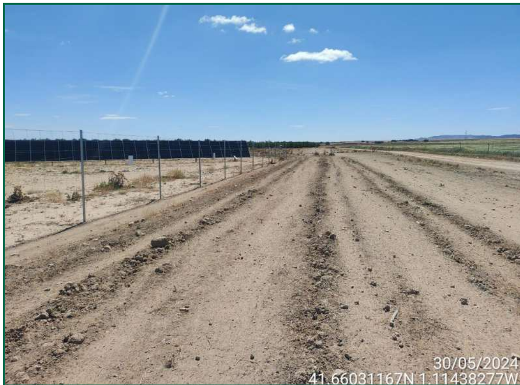
Fotografía 19. Vallado con placas anticollisión.
