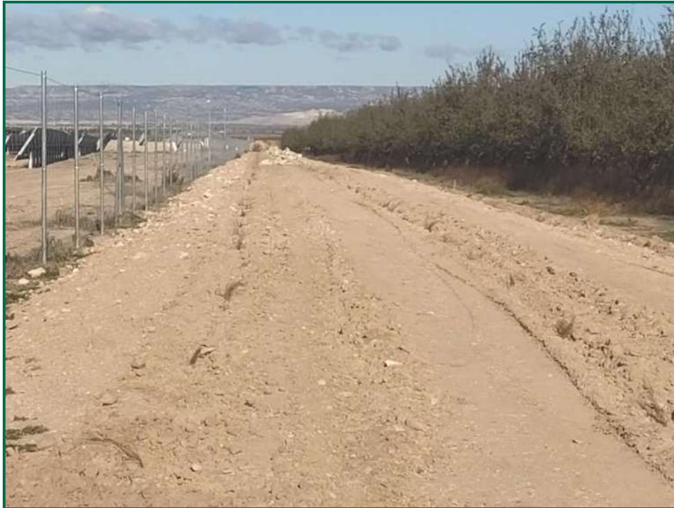
Fotografía 40. Zona con plantones ya colocados.
