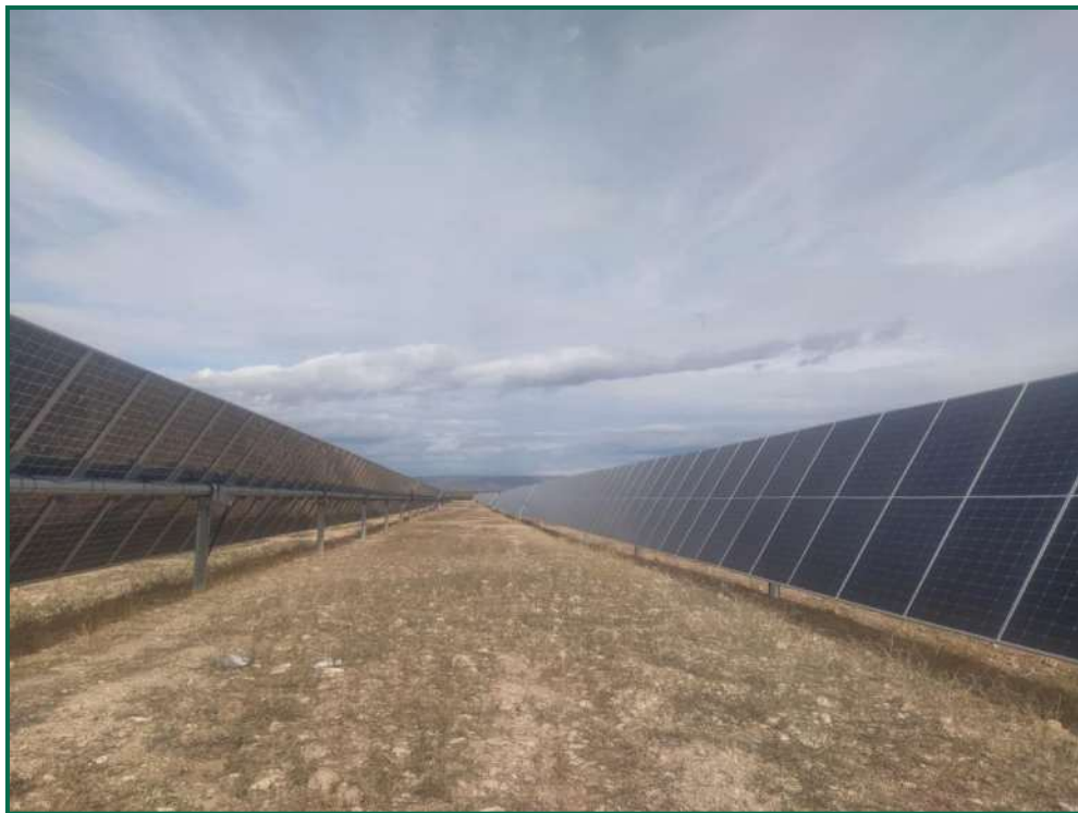
Fotografía 12. Hincas sobre el terreno.
