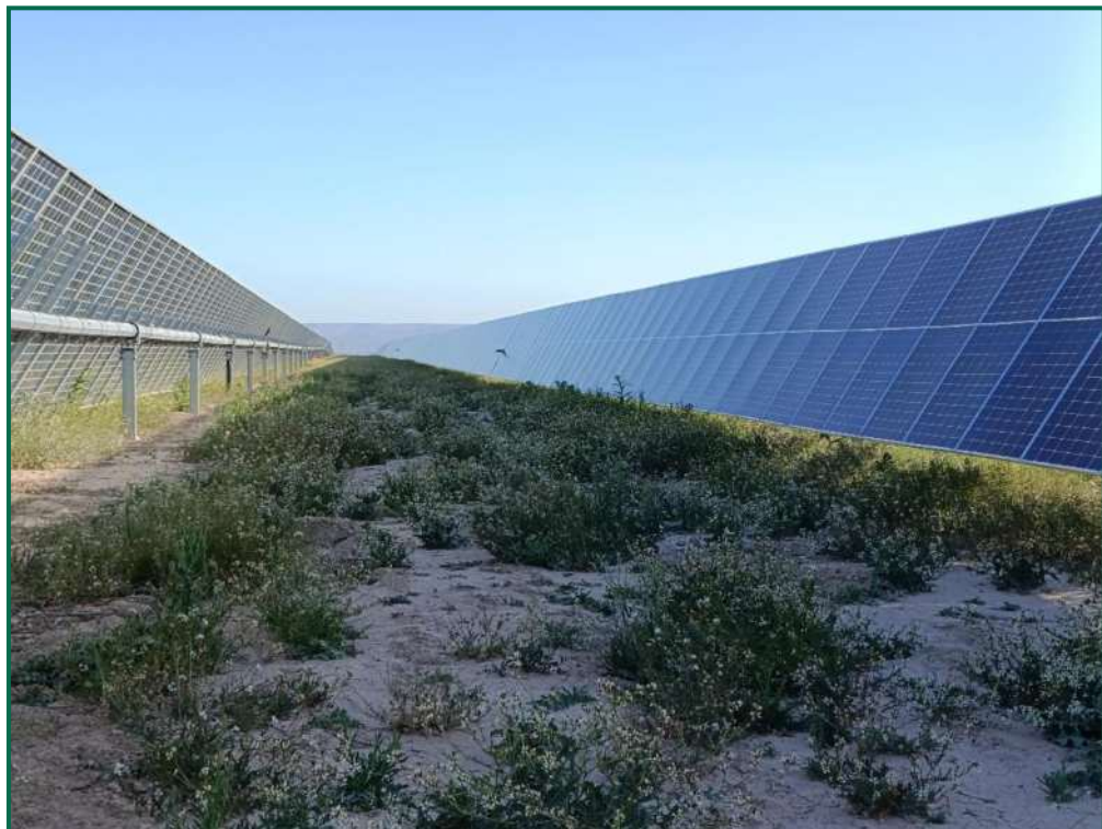
Fotografía 14. Hincas sobre el terreno.
