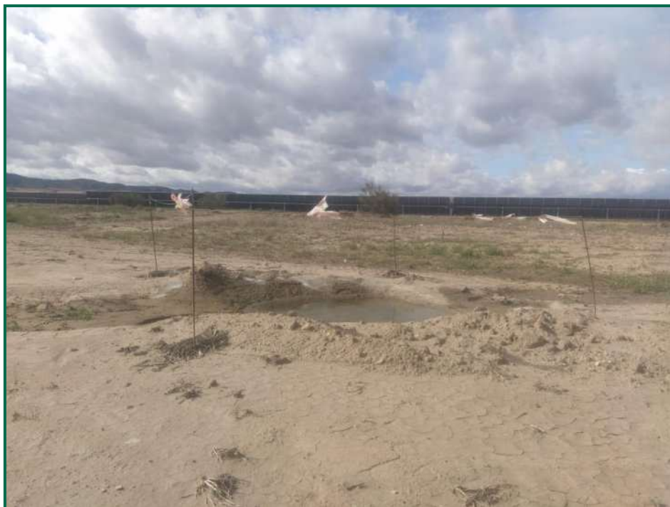
Fotografía 26. Balsete ya construido.
