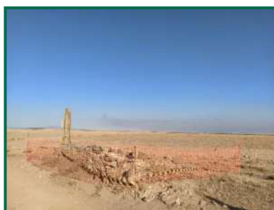
Fotografía 61. Muelle de carga
