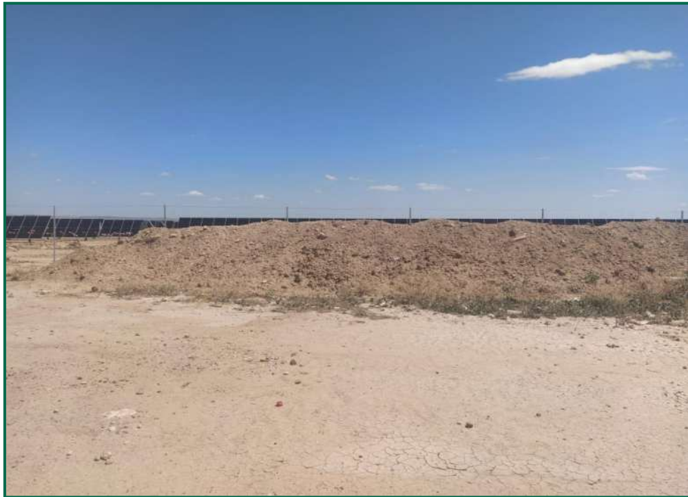
Fotografía 9. Acopio de tierra.
