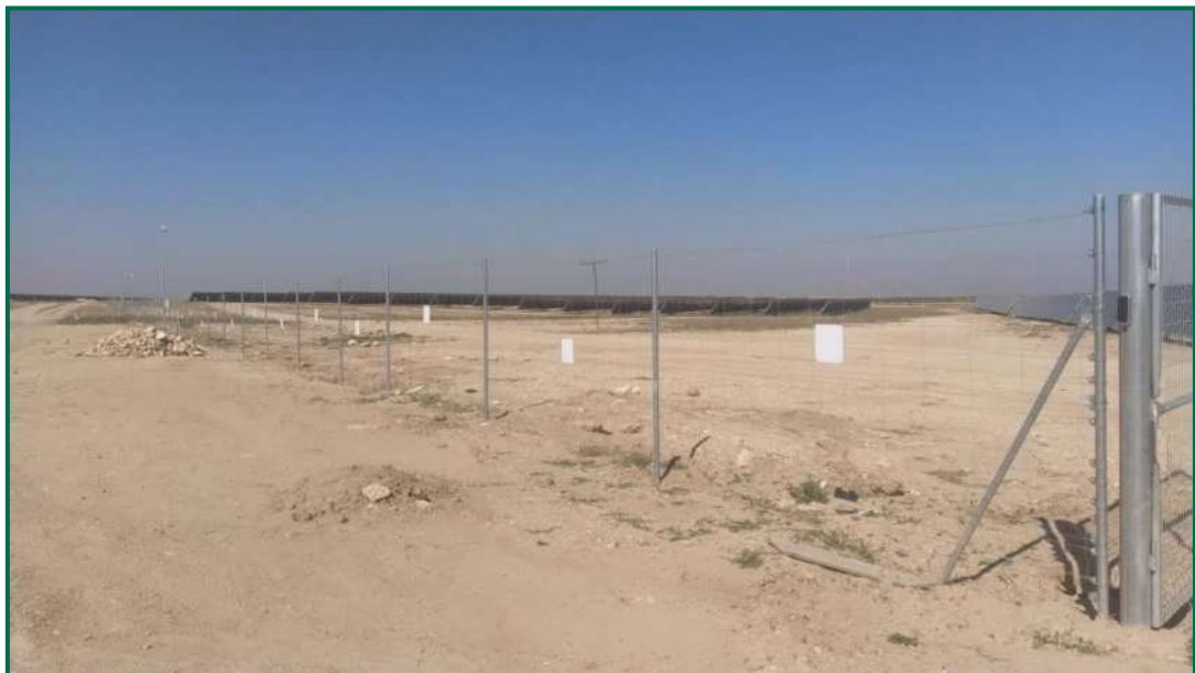
Fotografía 3. Vallado durante la obra.
