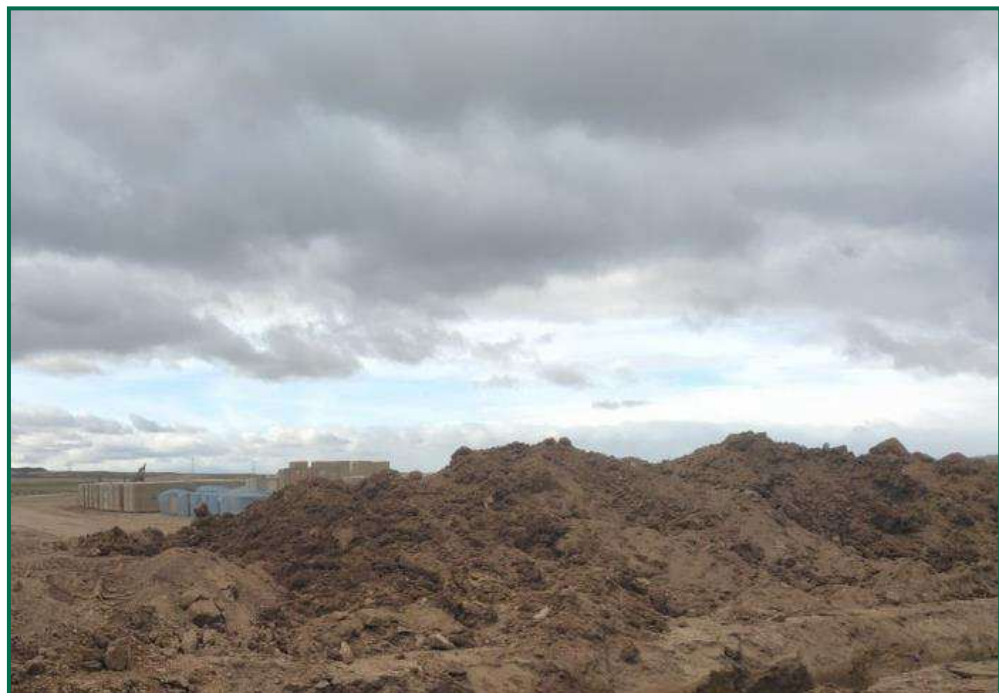
Fotografía 10. Acopio de tierra.
