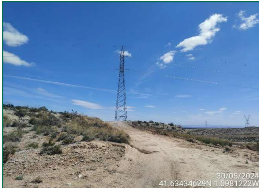
Fotografía 15. Acceso apoyo 17, antes de la restitución.
