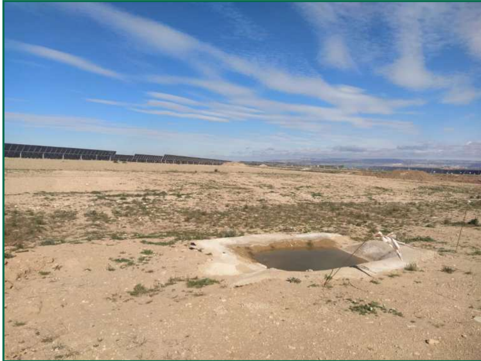
Fotografía 25. Balsete ya construido.
