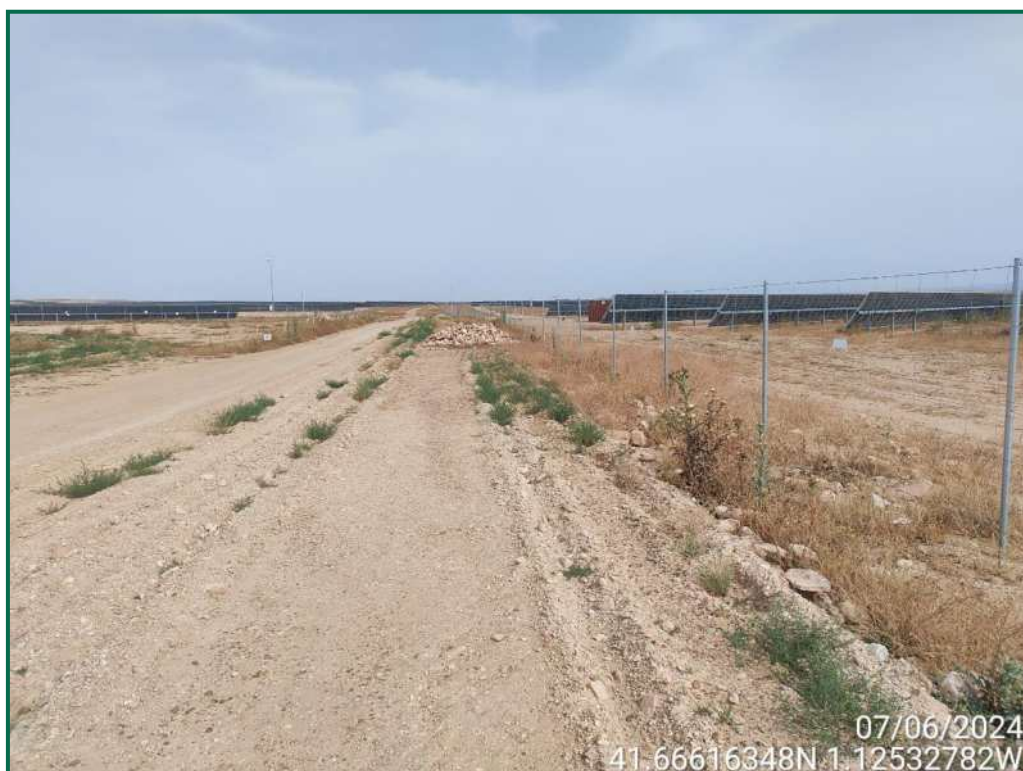
Fotografía 21. Vallado con varias placas anticolidión rotas.
