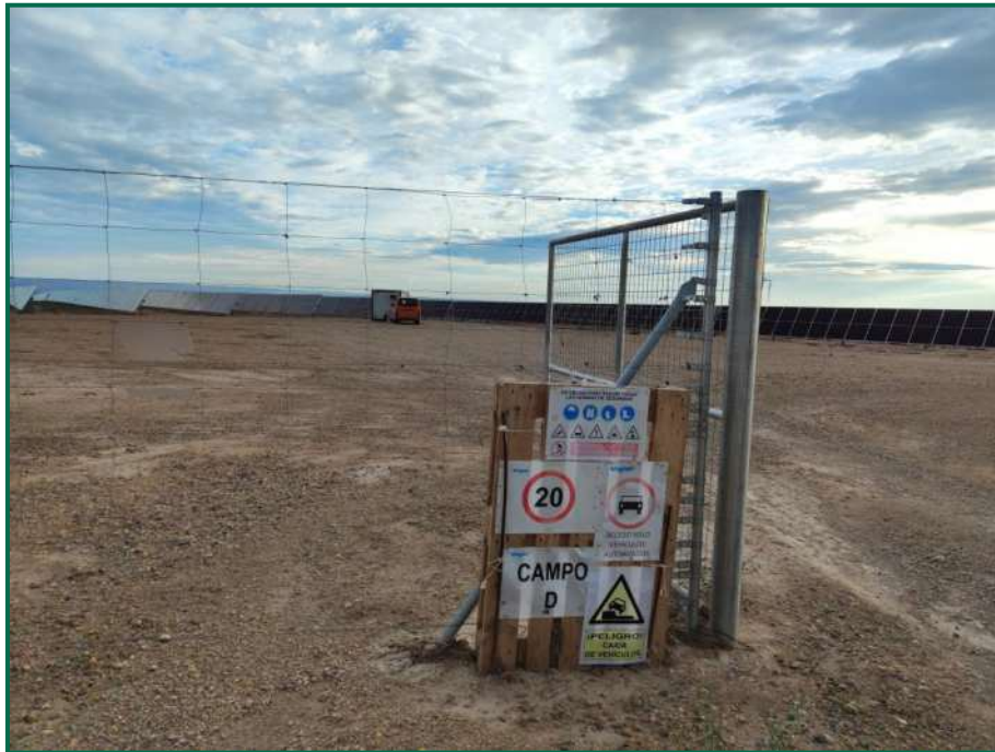
Fotografía 7. Señal de limitación de velocidad.
