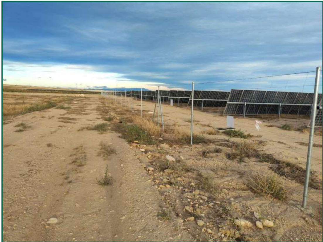
Fotografía 2. Vallado durante la obra.
