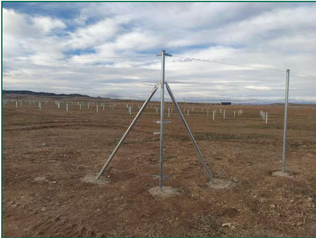
Fotografía 4. Detalle vallado durante su colocación.
