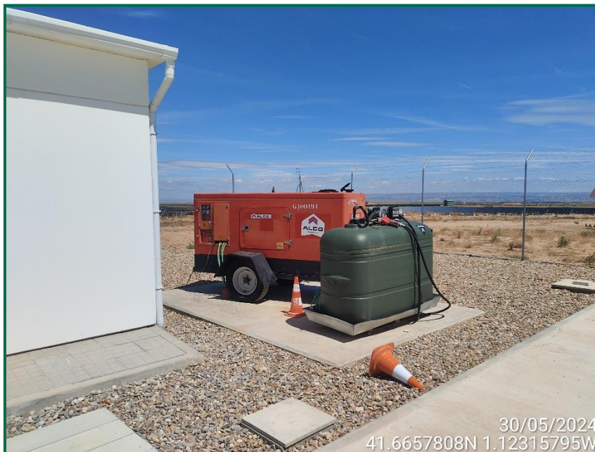
Fotografía 10. Grupo electrógeno.
