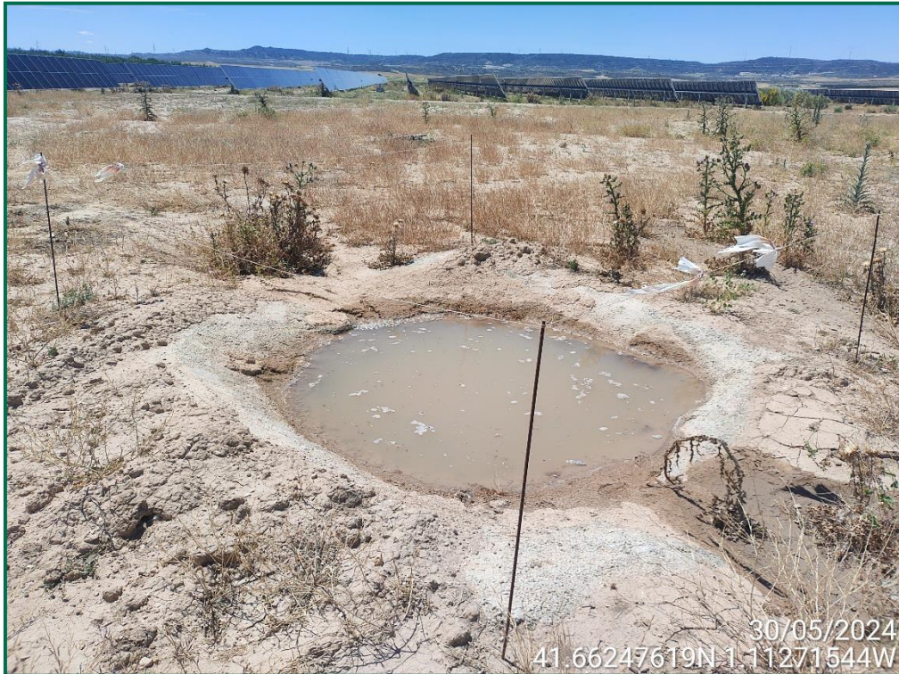
Fotografía 8. Balsete ya construido.
