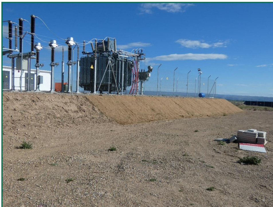
Fotografía 13. Malla sobre talud.
