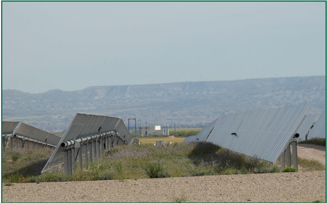
Fotografía 4. Hincas sobre el terreno.
