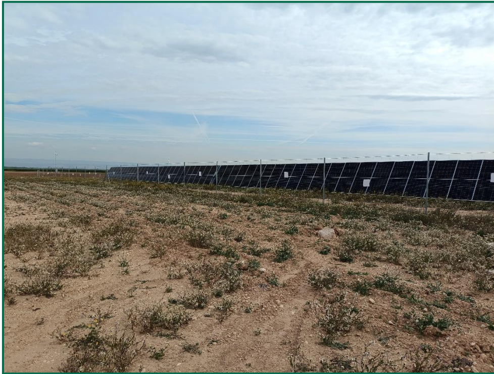
Fotografía 15. Zona con plantones ya colocados.
