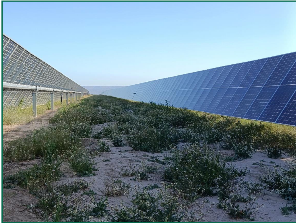
Fotografía 4. Hincas sobre el terreno.
