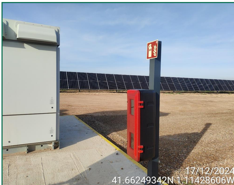
Fotografía 24. Extintor junto a inversor.
