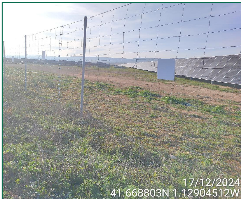
Fotografía 20. Vallado perimetral con placas anticollisión.
