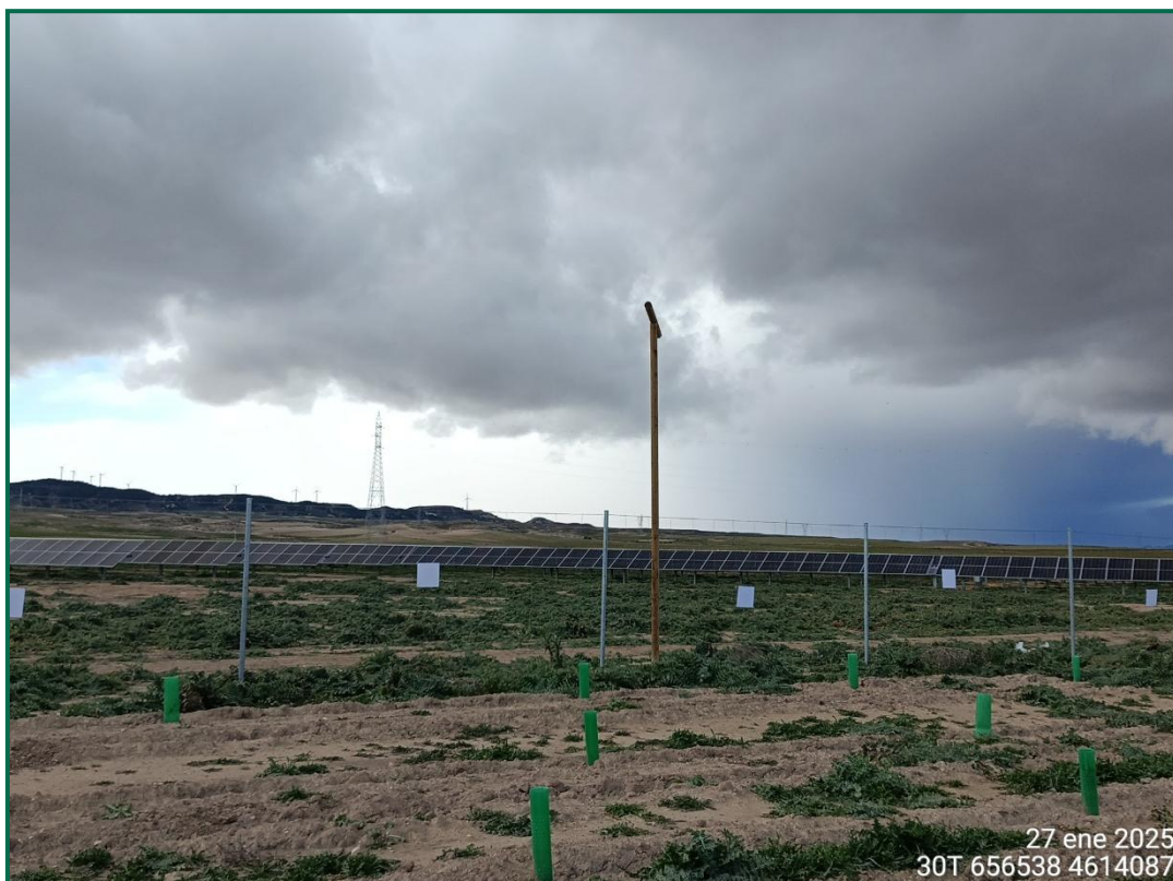
Fotografía 21. Vallado perimetral con placas anticolidión.
