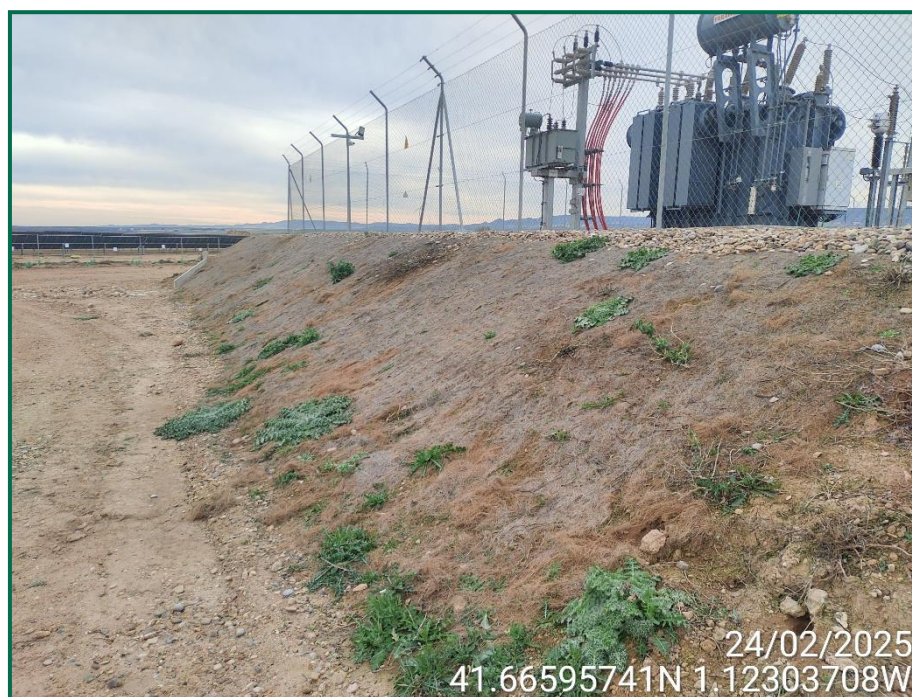
Fotografía 2. Tierra vegetal y malla de coco sobre talud posterior de la SET.
