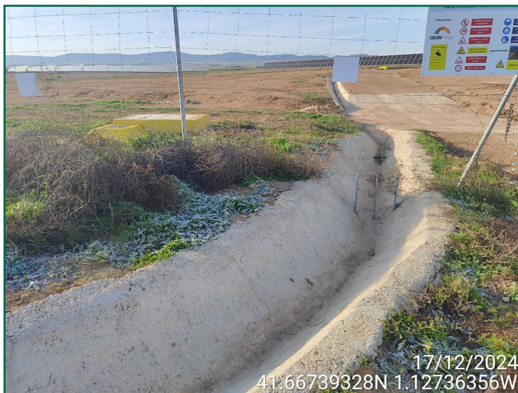
Fotografía 6. Drenaje de la planta solar.
