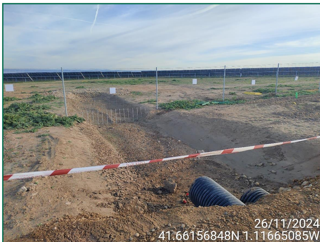
Fotografía 5. Construcción de drenaje y paso.
