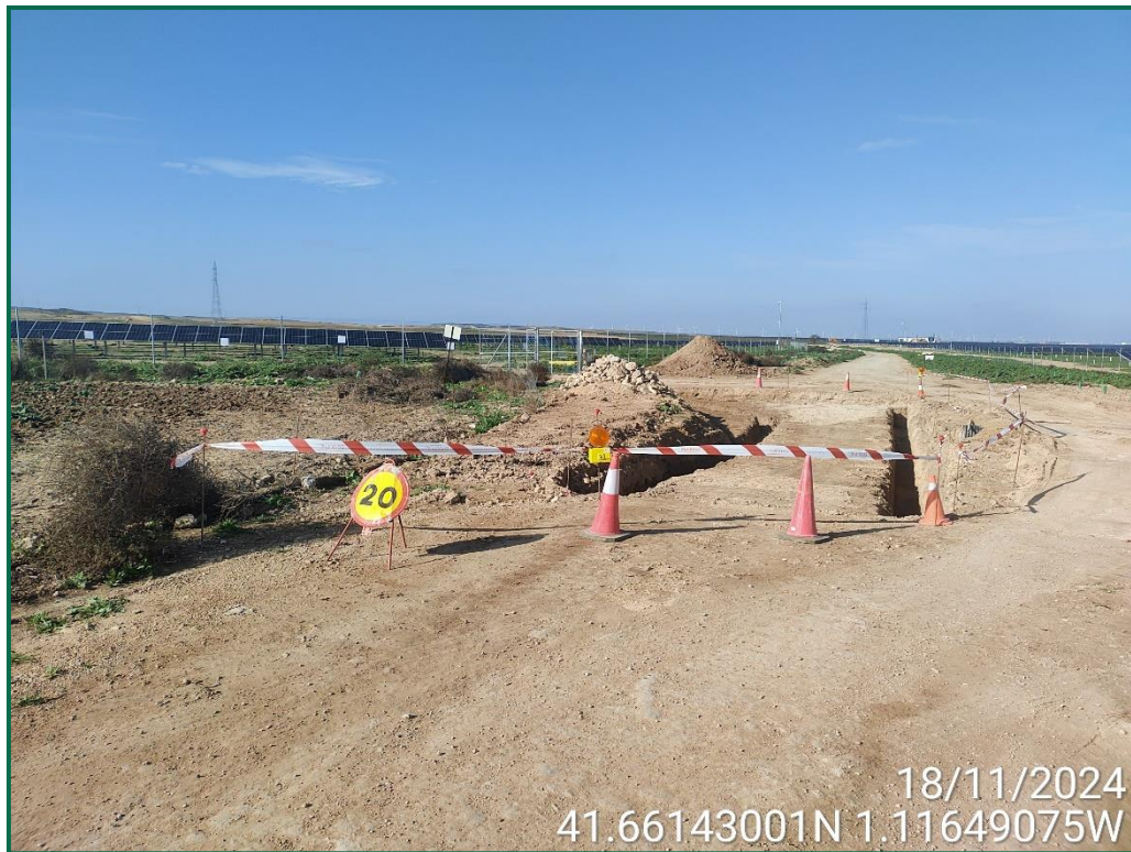
Fotografía 4. Construcción de drenaje y paso.
