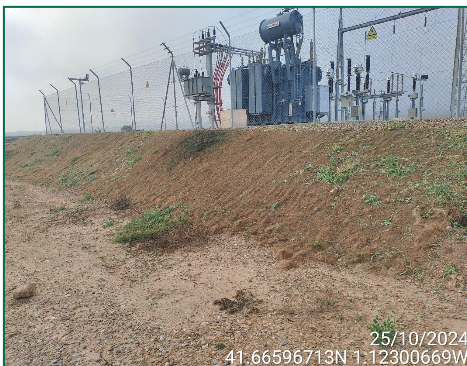
Fotografía 1. Tierra vegetal y malla de coco sobre talud posterior de la SET.
