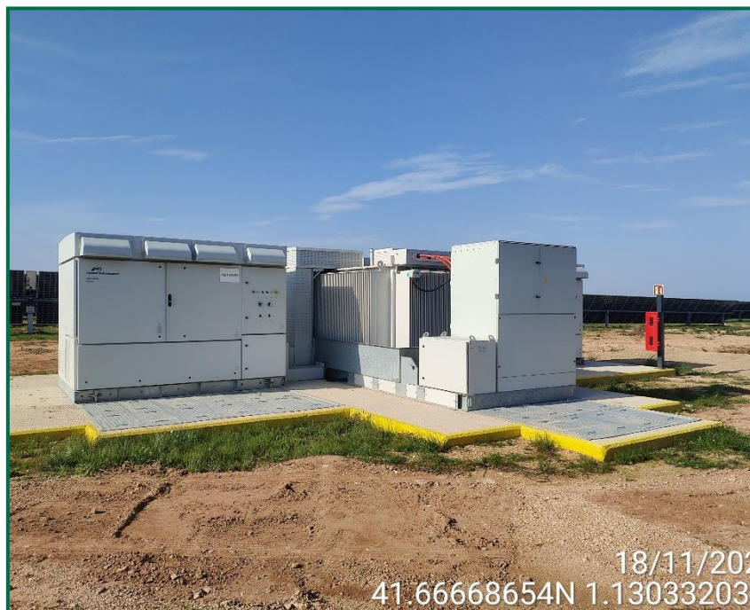
Fotografía 24. Extintor junto a inversor.
