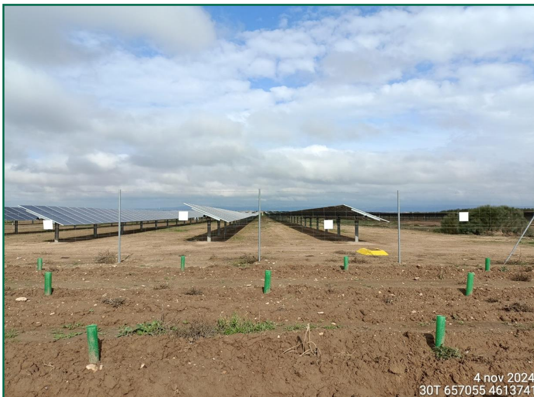
Fotografía 21. Vallado perimetral con placas anticolisión.
