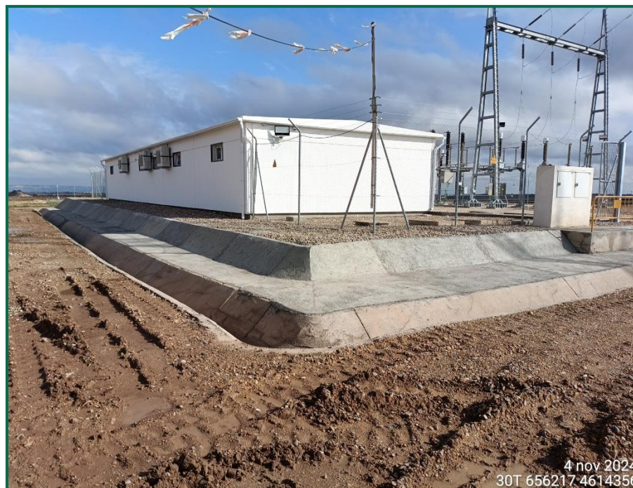
Fotografía 3. Zona de talud hormigonada.
