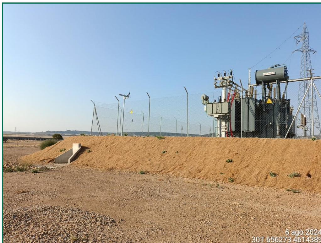
Fotografía 2. Talud de la subestación con malla de coco e hidrosiembra.
