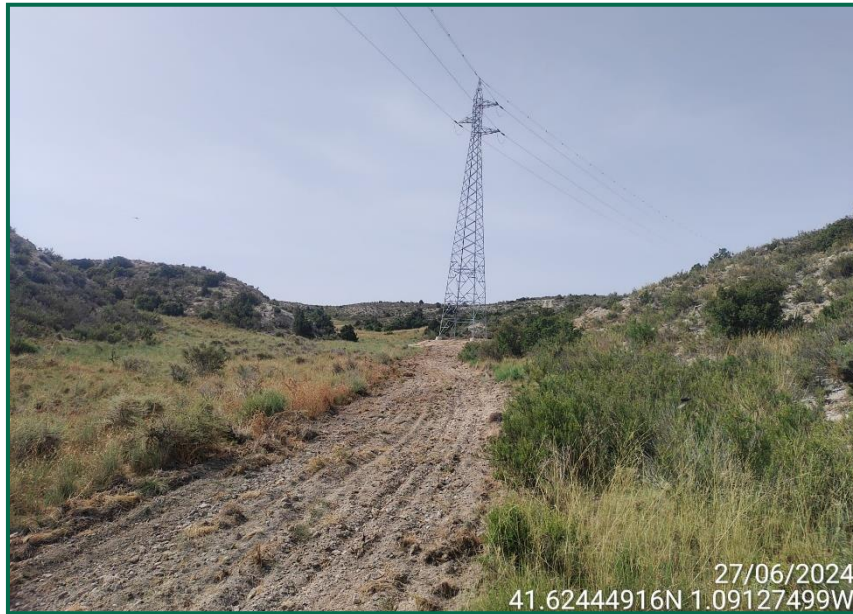
Fotografía 5. Acceso apoyo 21 después de extender la tierra vegetal.
