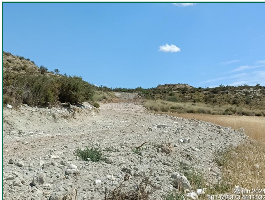
Fotografía 4. Acceso apoyo 17 después de extender la tierra vegetal.
