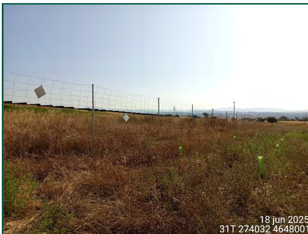
Fotografía 19. Placas anticolidión y vallado perimetral.
