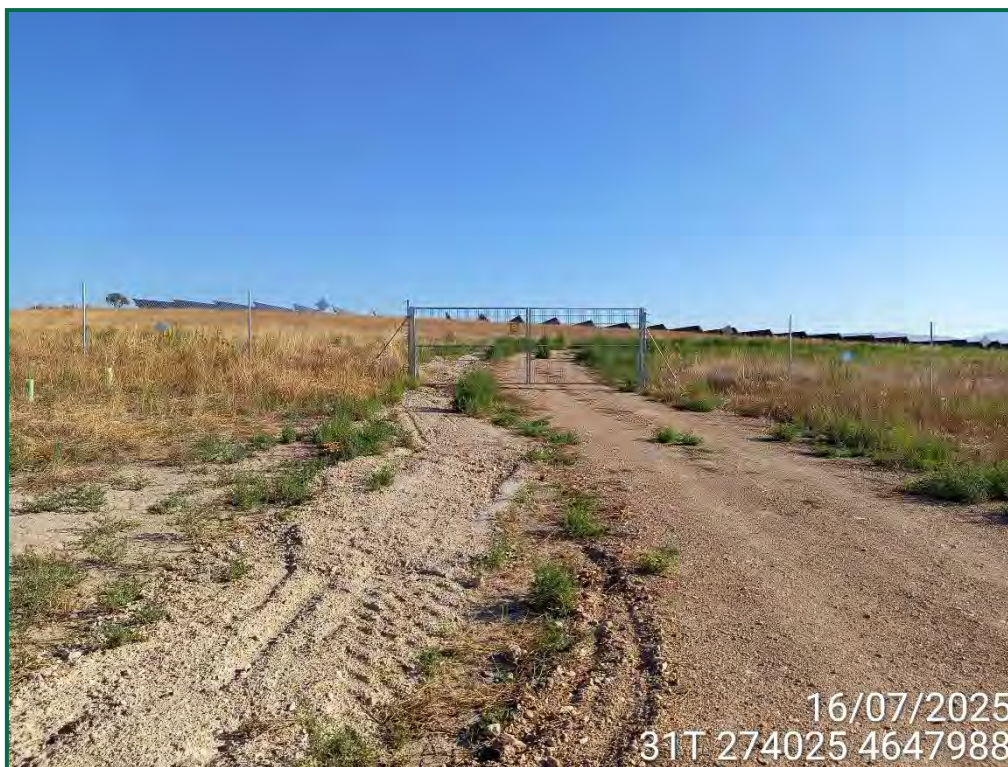
Fotografía 6. Drenaje en la entrada de la PFV cerrado.
