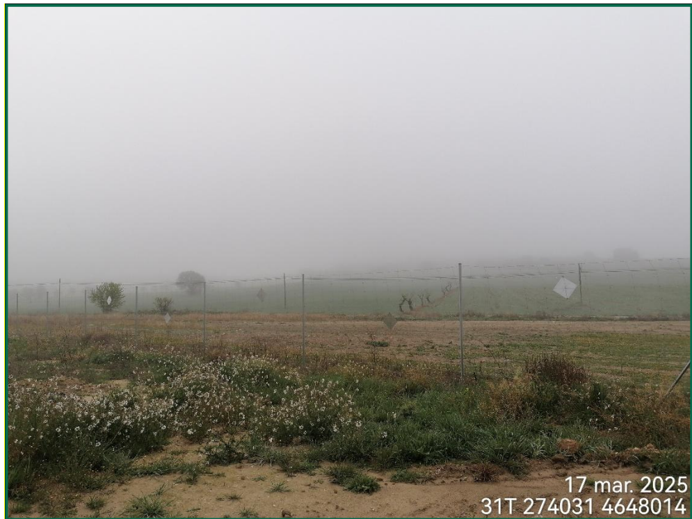
Fotografía 18. Placas anticolidión y vallado perimetral.
