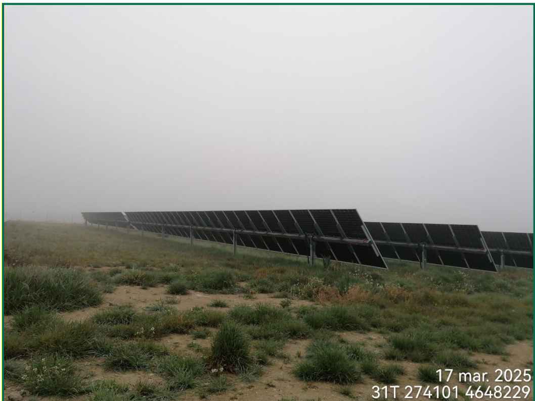
Fotografía 7. Vegetación herbácea entre seguidores.
