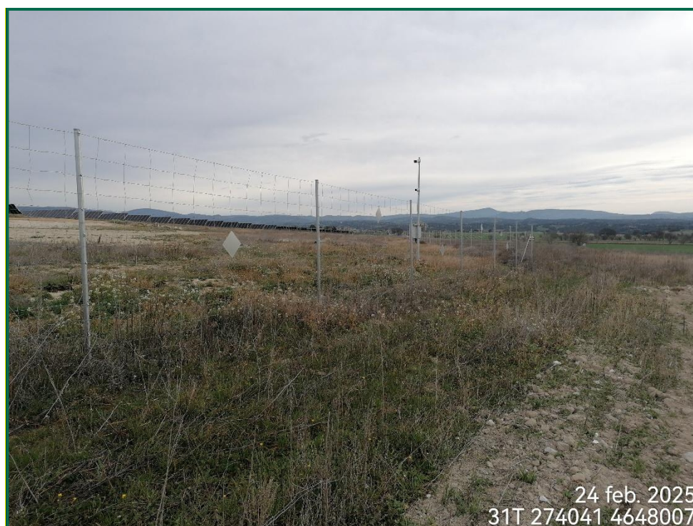
Fotografía 17. Placas anticolidión y vallado perimetral.
