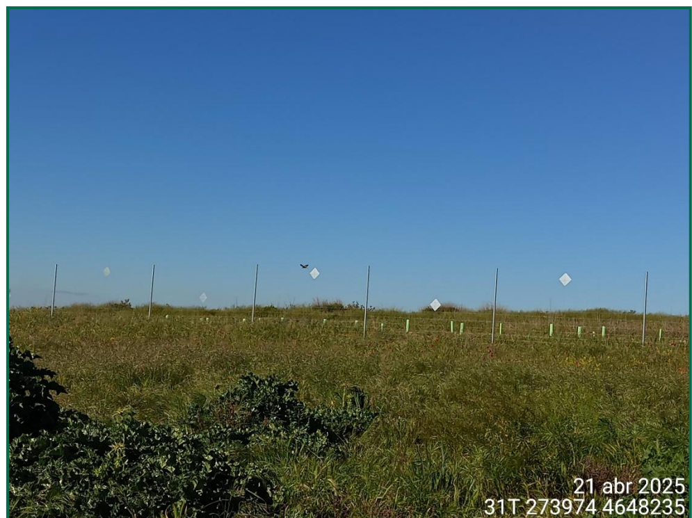
Fotografía 19. Placas anticolidión y vallado perimetral.
