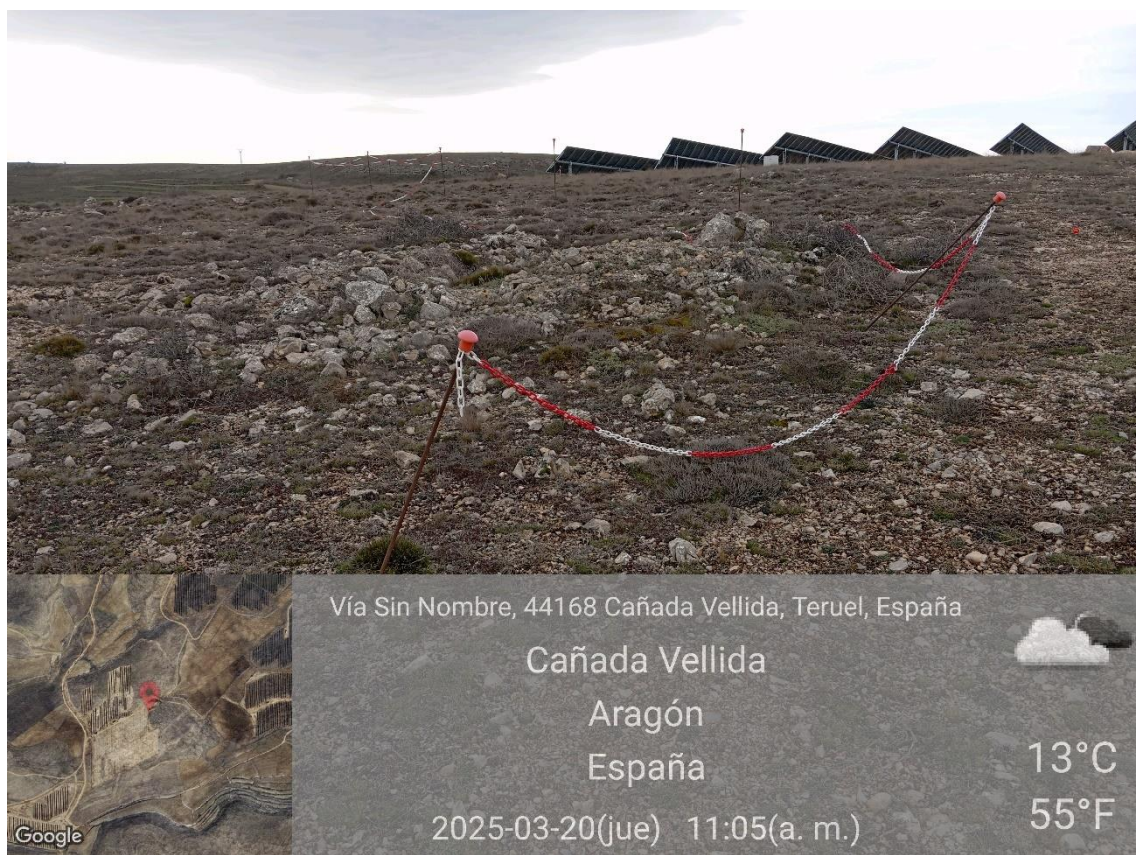
Ilustración 5. Trinchera con las balizas caídas en poligonal 4.
