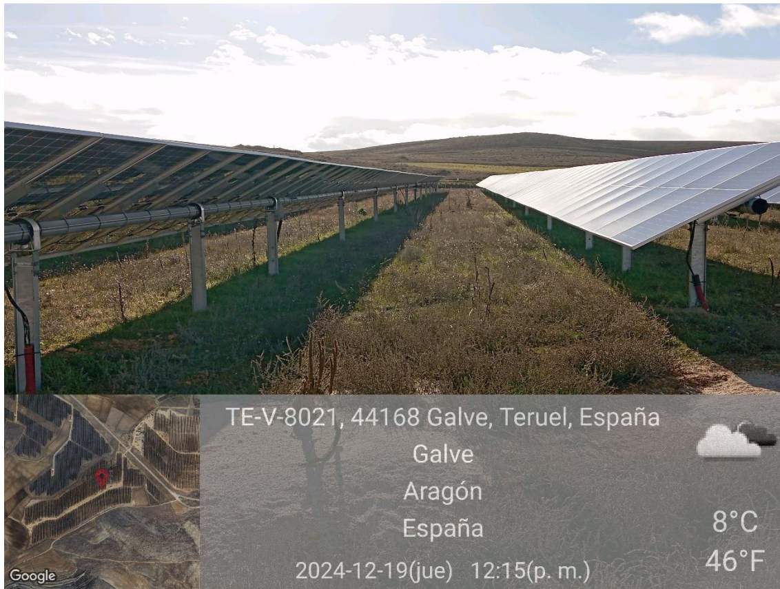
Ilustración 7. Vegetación entre placas en buen estado en la poligonal 3.
