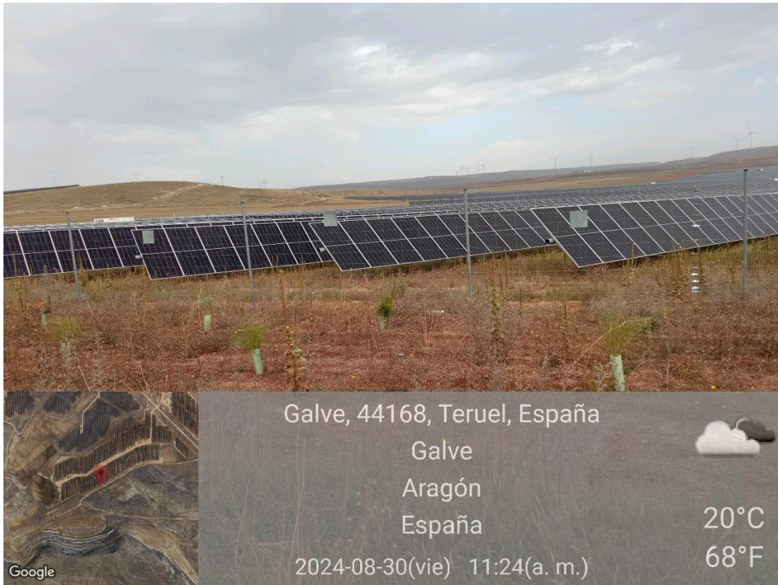
Ilustración 4. Vallado y pantalla vegetal en buen estado en la zona 3.
