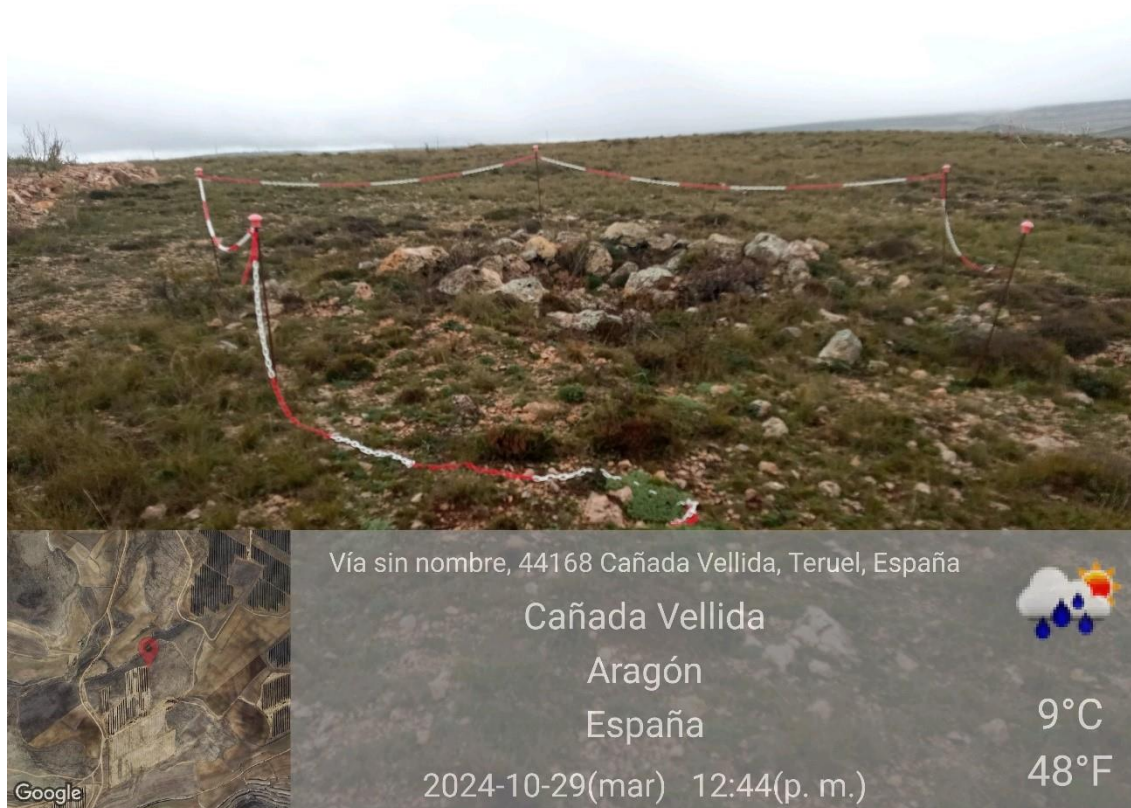
Ilustración 8. Trinchera mal acordonada.
