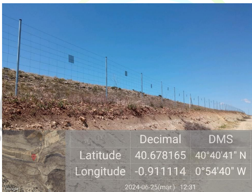
Ilustración 5. Vallado en buen estado de la ZONA 5.
