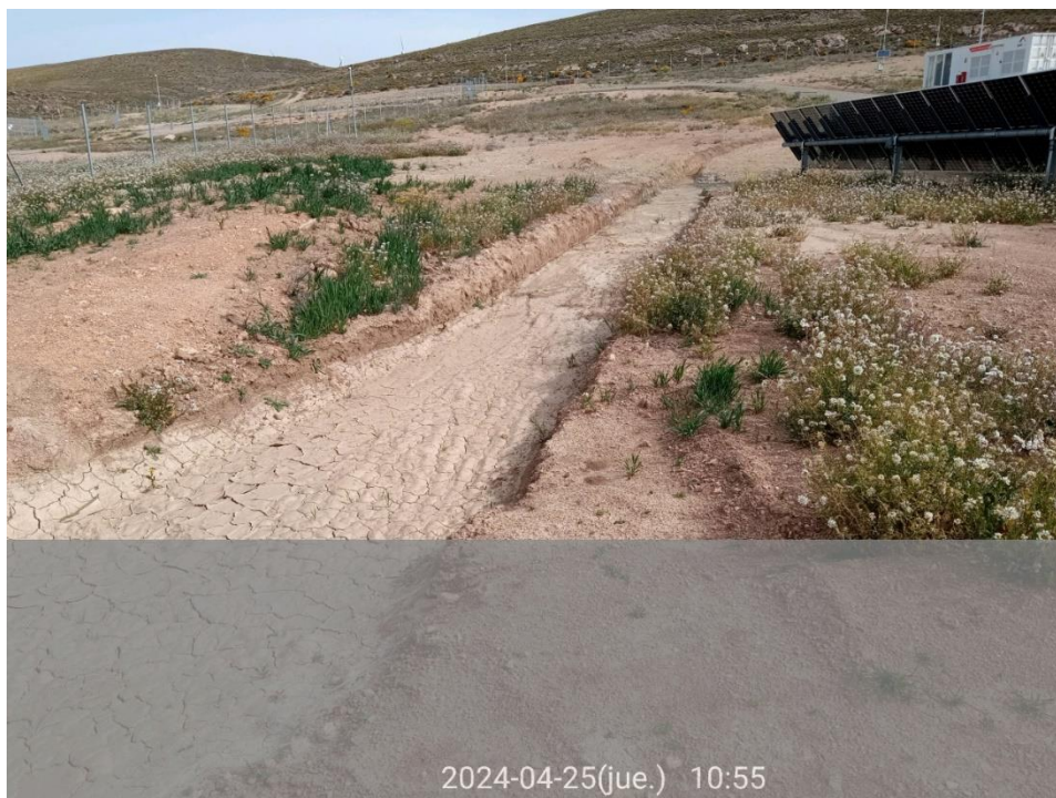
Ilustración 9. Canaleta sin cementar zona 2 en buen estado.
