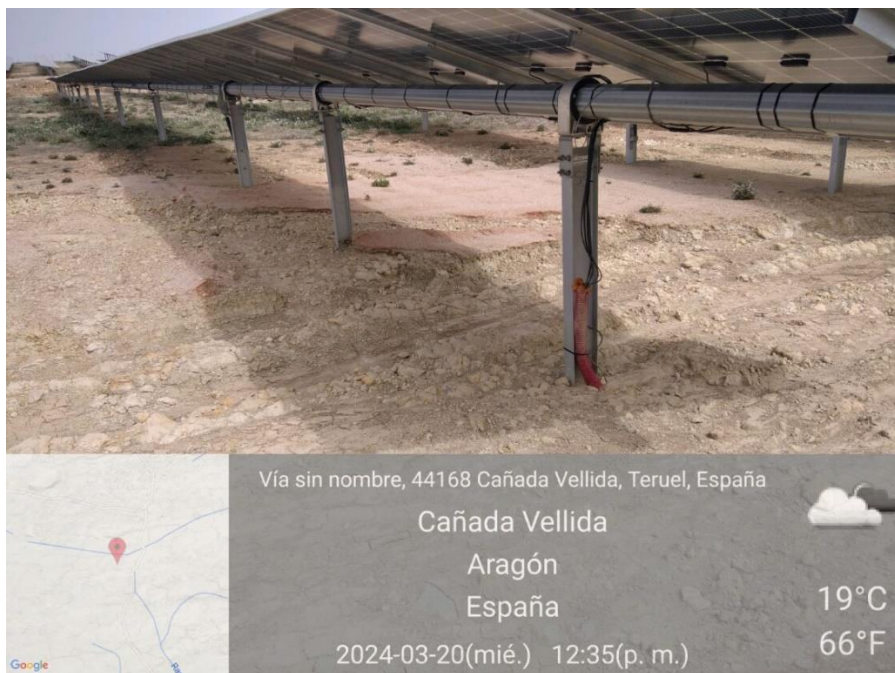
Ilustración 7. Erosión suelos bajo placas.
