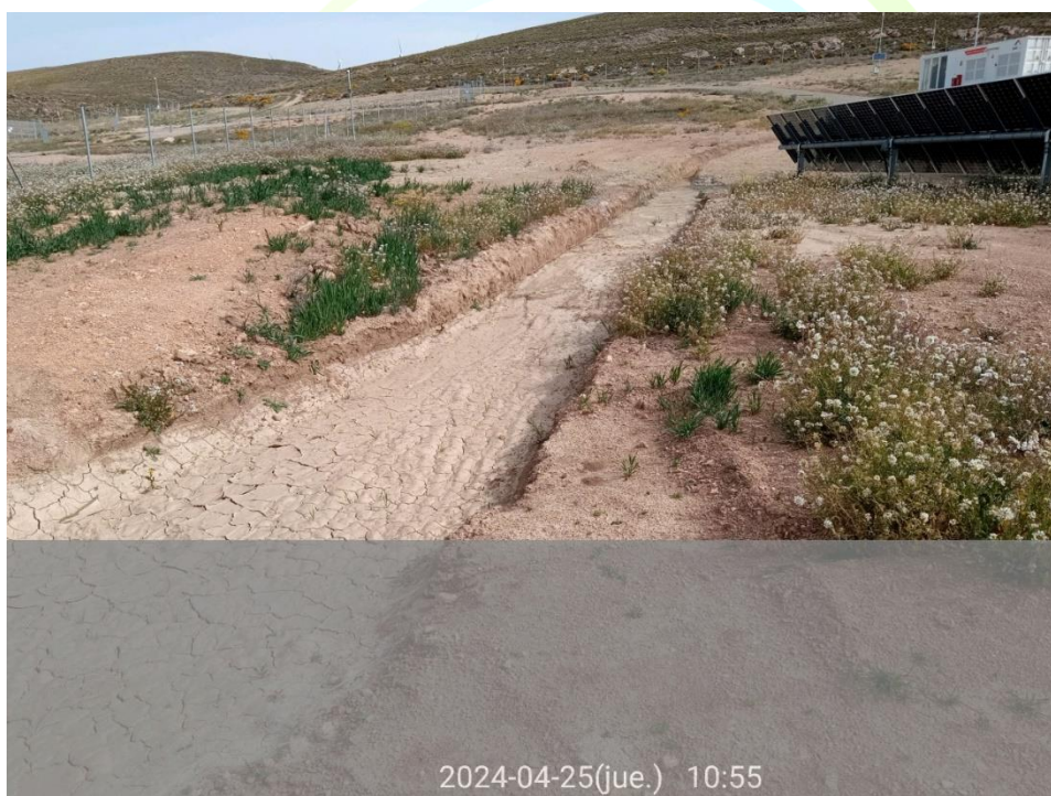
Ilustración 11. Canaleta sin cementar zona 2 en buen estado.
