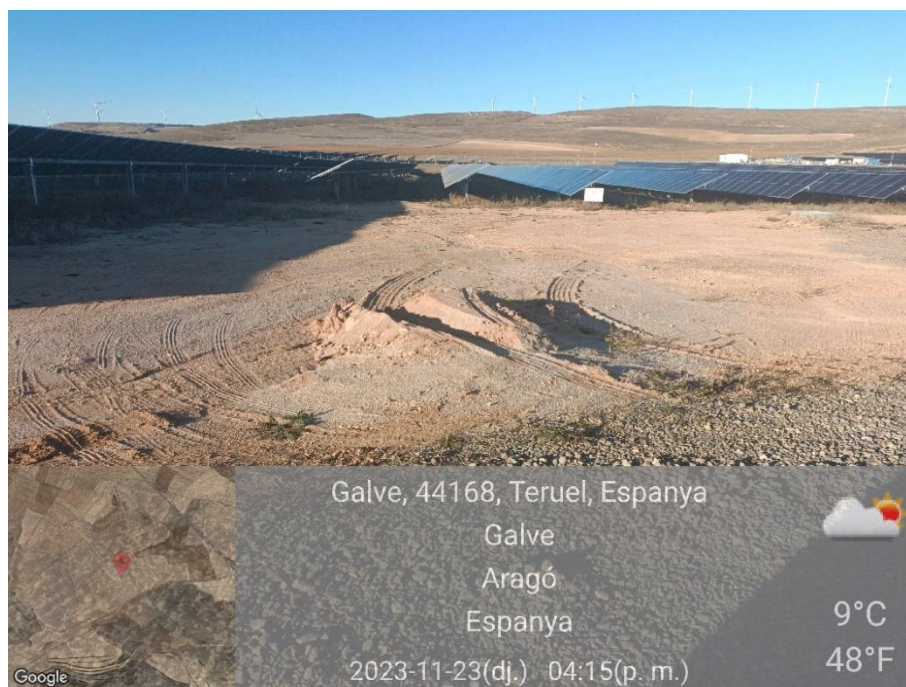
Ilustración 6. Zona de acopio de materiales en la zona 3.
