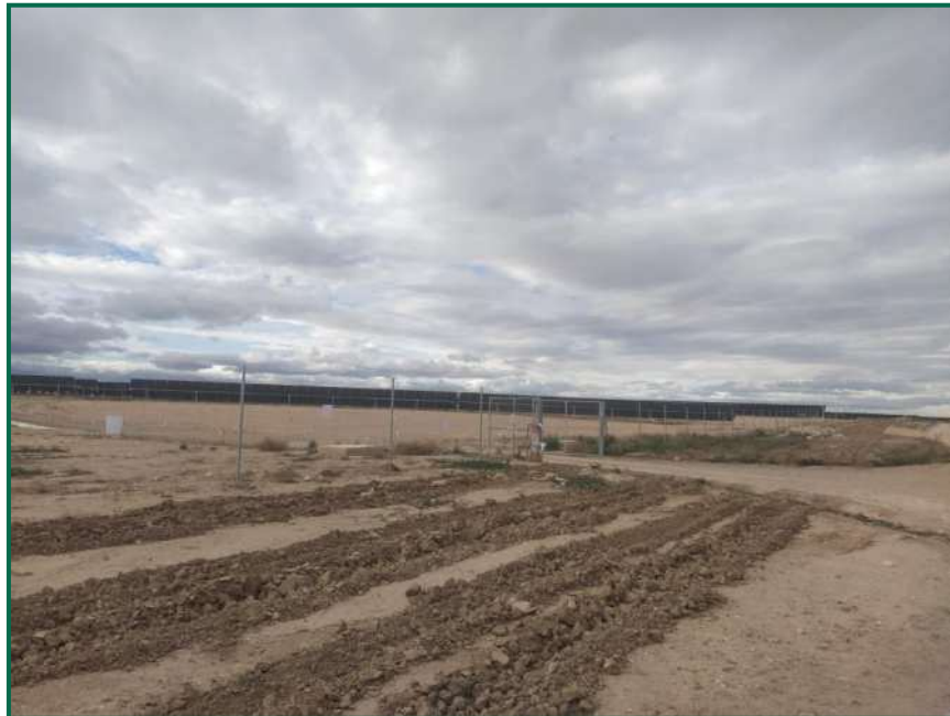
Fotografía 32. Preparación del terreno para plantaciones.
