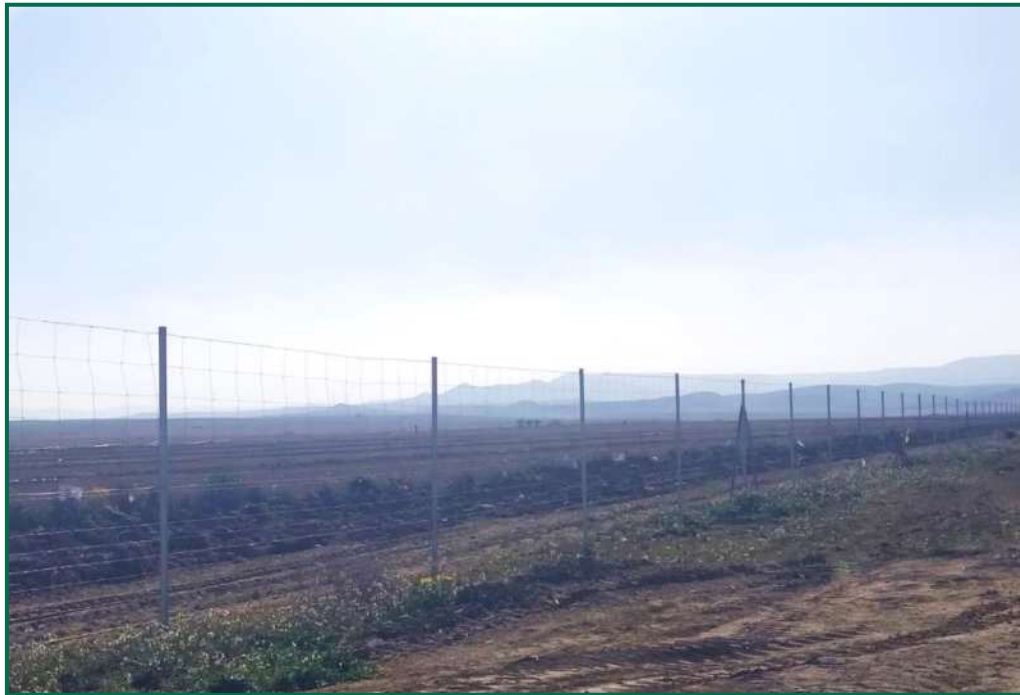
Fotografía 4. Vallado durante la obra.
