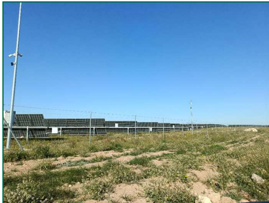
Fotografía 37. Zona con plantones ya colocados.
