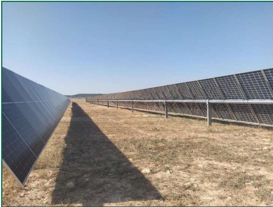
Fotografía 10. Hincas sobre el terreno.
