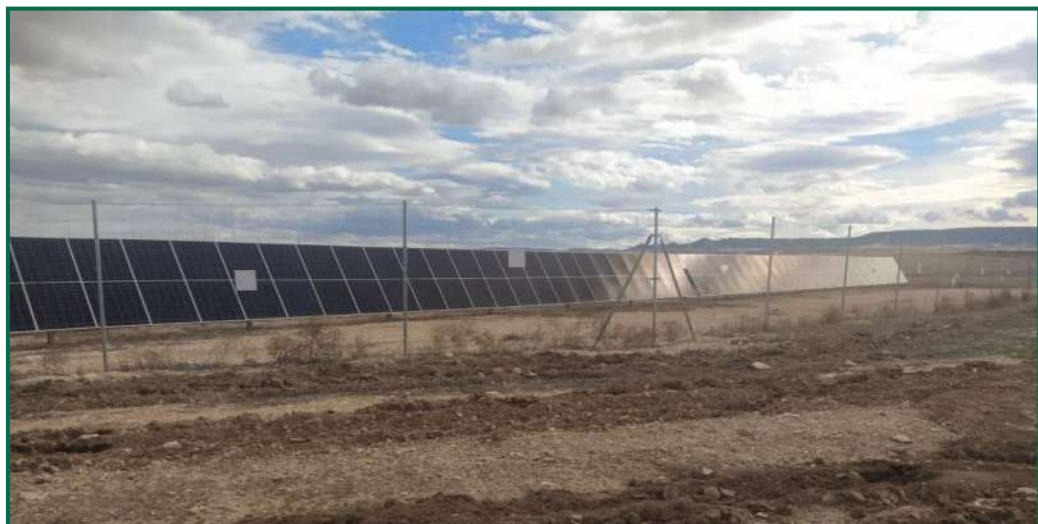
Fotografía 3. Vallado durante la obra.
