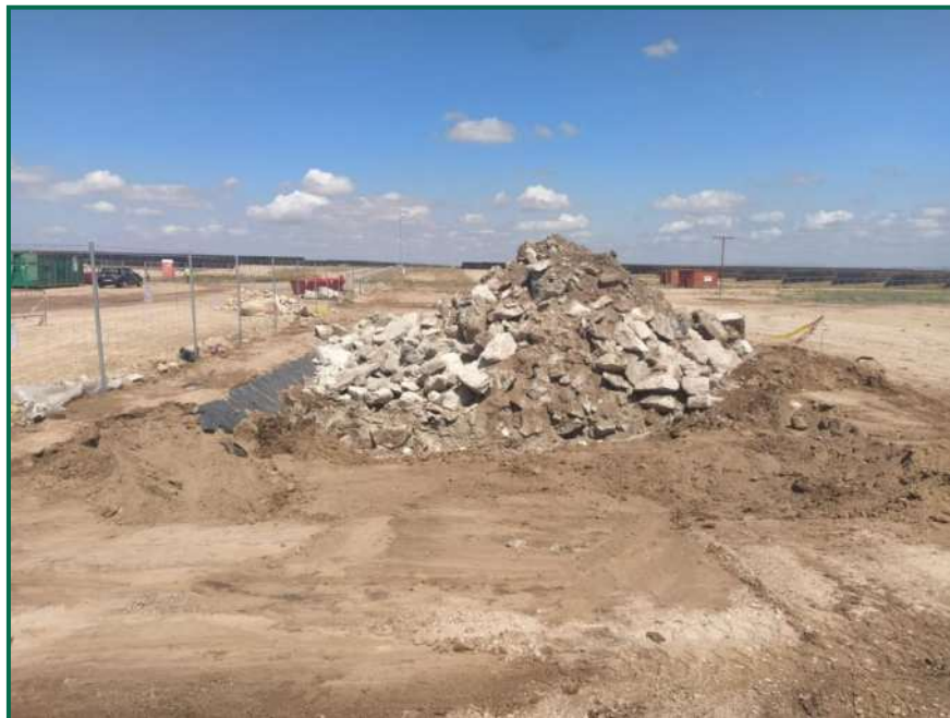
Fotografía 27. Zona de lavado de hormigón en proceso de retirada.
