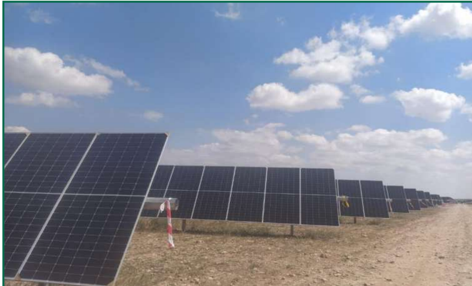
Fotografía 11. Hincas sobre el terreno.
