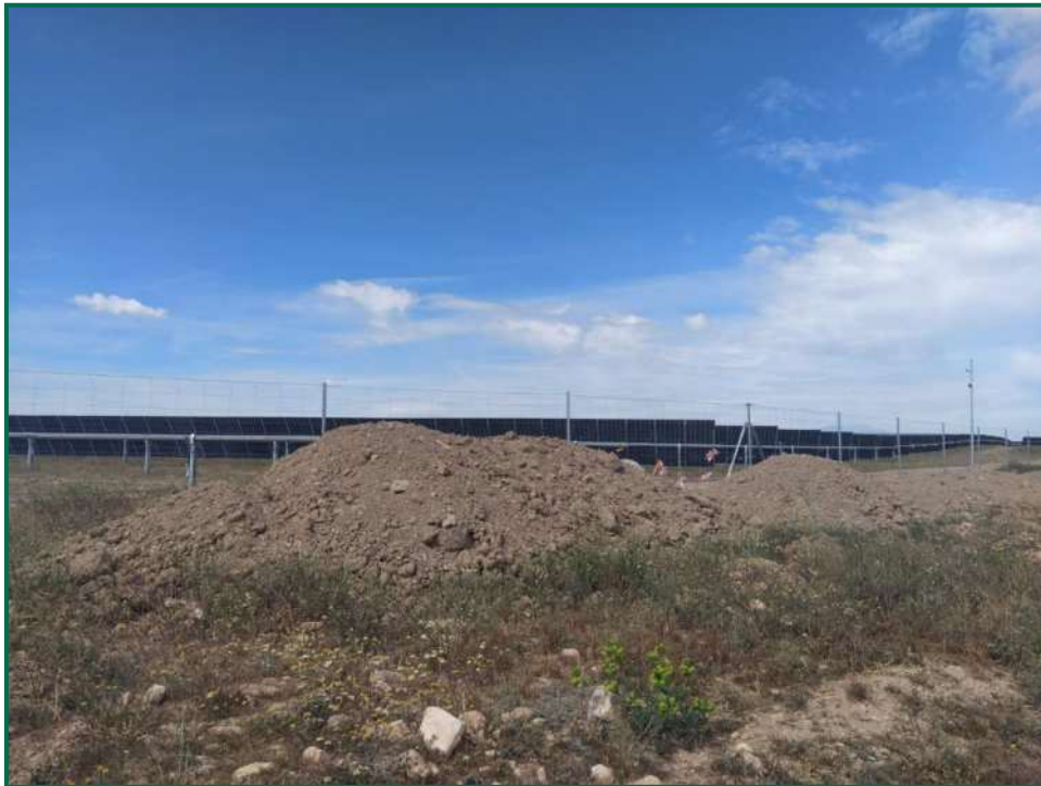
Fotografía 8. Acopio de tierra.
