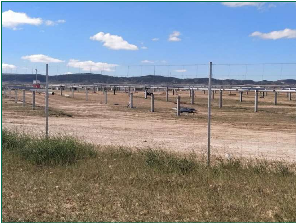
Fotografía 2. Vallado durante la obra.
