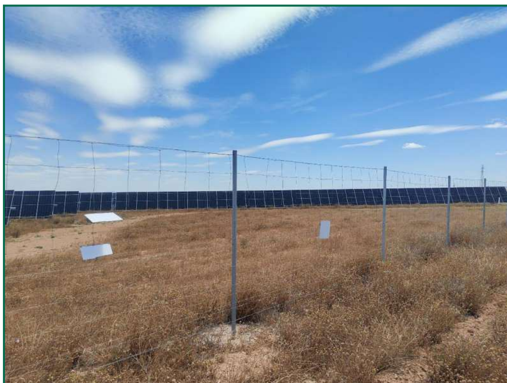
Fotografía 14. Vallado con varias placas anticolisión rotas.
