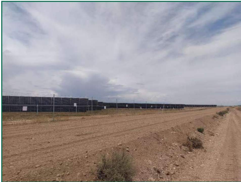
Fotografía 9. Acopio de tierra ya extendida.
