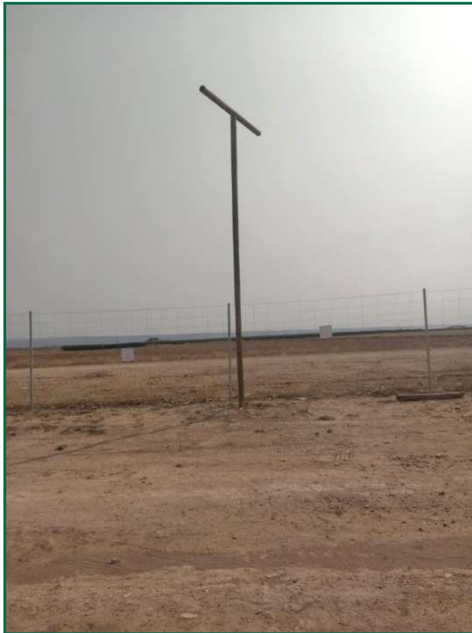
Fotografía 15. Poste posadero ya ejecutado.
