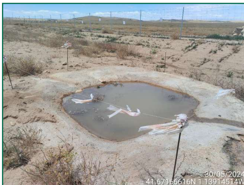
Fotografía 20. Balsete ya construido. Estado en mayo 2024
