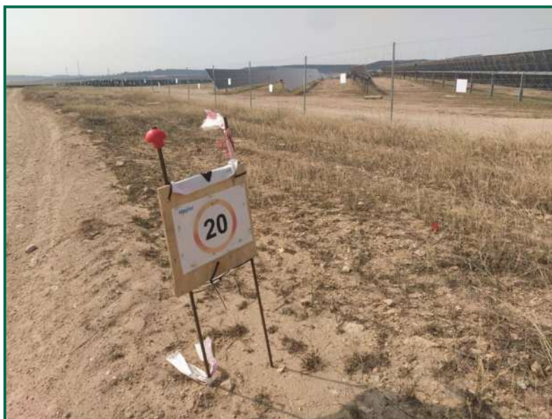
Fotografía 5. Señal de limitación de velocidad al inicio de las obras.
