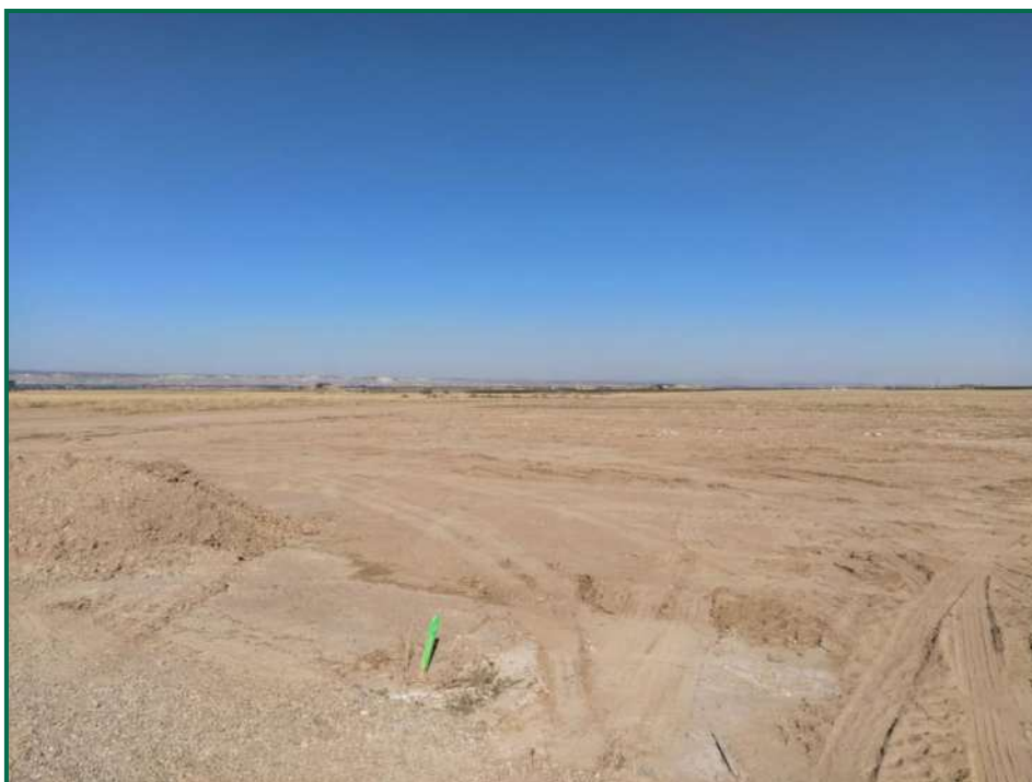
Fotografía 1. Jalonamiento previo mediante estacas.
